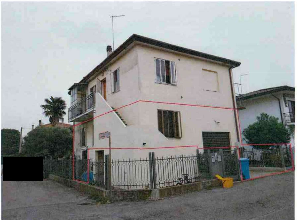
Vista nord-ovest fabbricato
