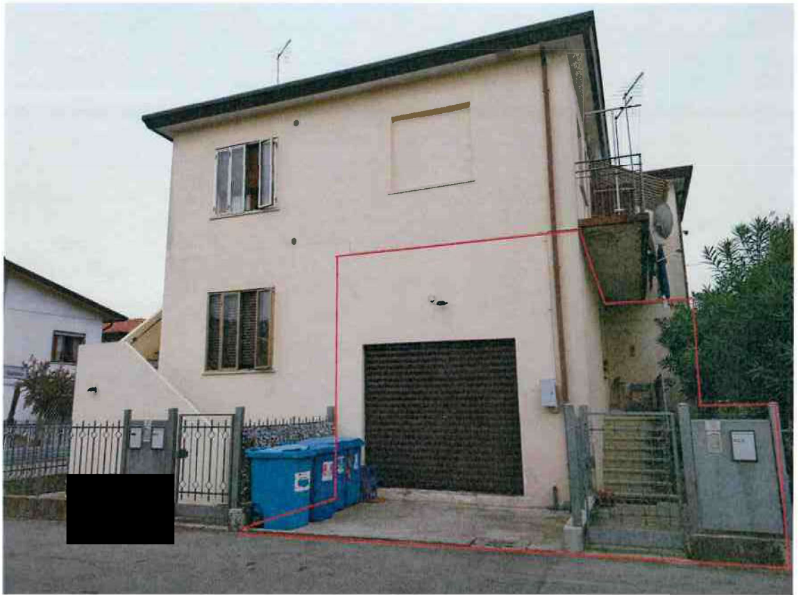
Vista ovest fabbricato
