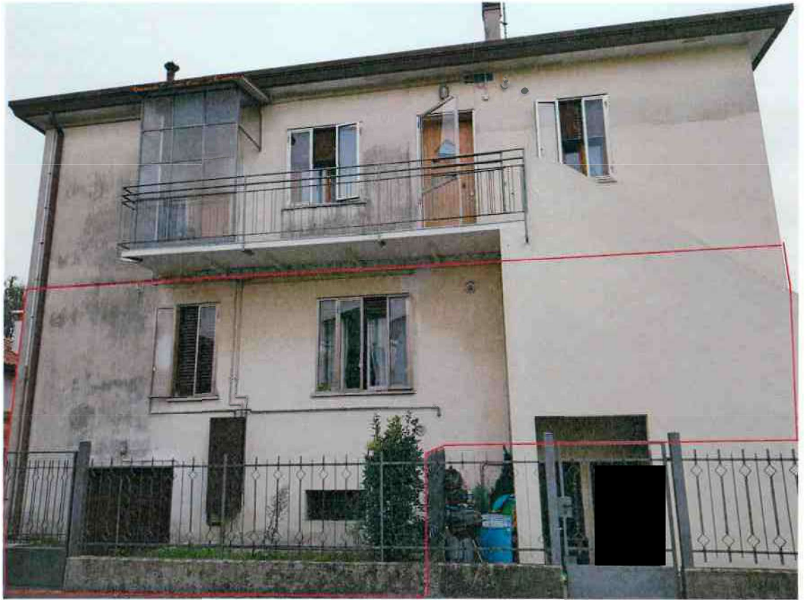
Vista nord fabbricato
