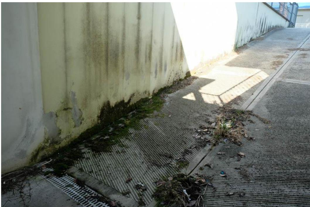
Foto n.92 – particolare dei segni dell'umidità risalente presente nello scivolo e nell'area di manovra ad uso comune alle autorimesse poste al piano interrato
