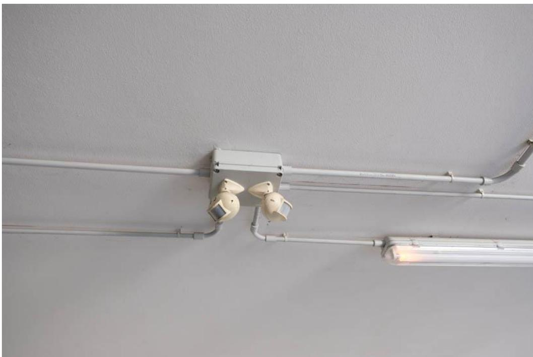
Foto n.96– particolare sensori di illuminazione dell'area di manovra per l'accesso alle autorimesse poste al piano interrato
