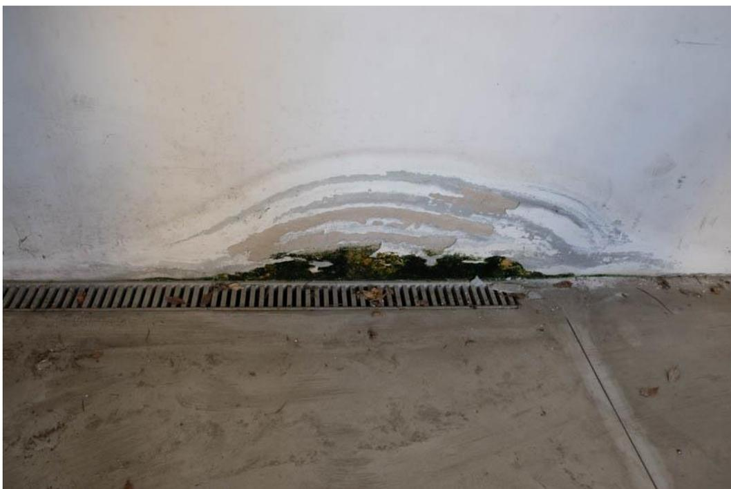
Foto n.93 – particolare dei segni dell'umidità risalente presente nell'area di manovra ad uso comune alle autorimesse poste al piano interrato
