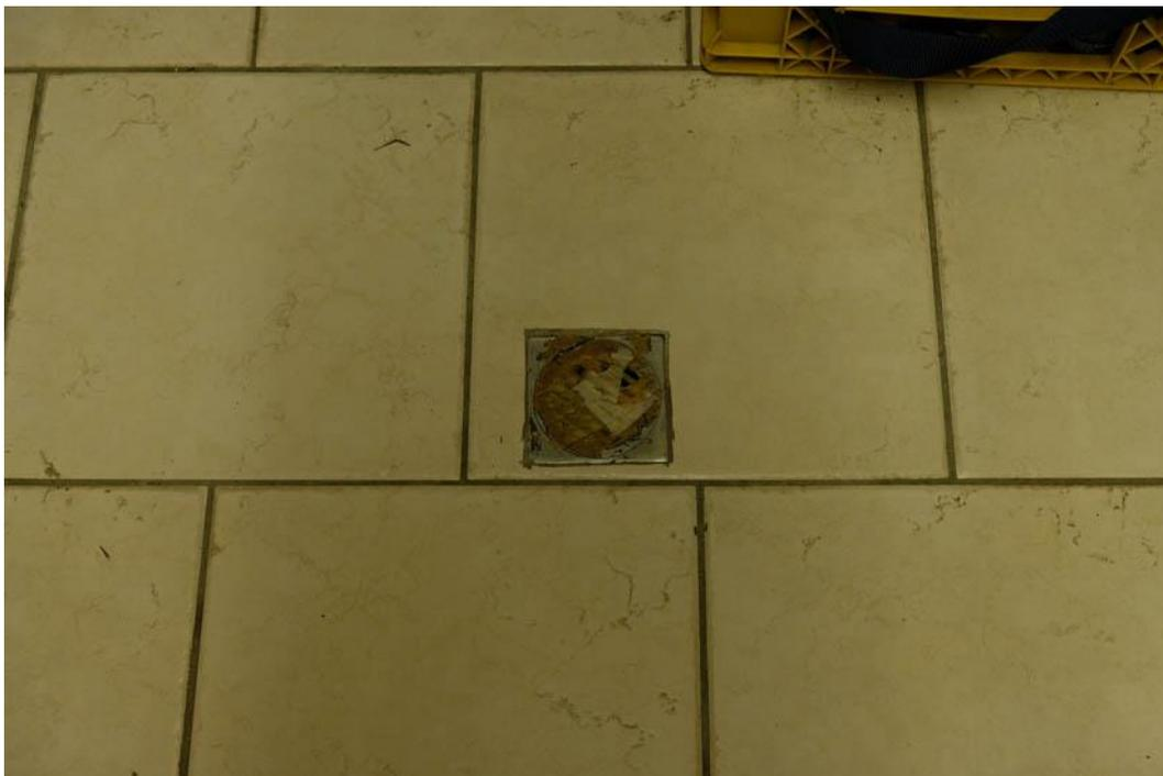
Foto n.86 – particolare piletta nell'autorimessa posta al piano interrato
