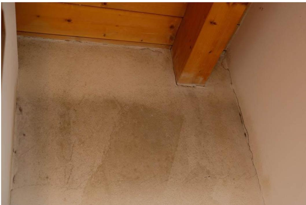
Foto n.62 – particolare parete del vano servizio con manifestazione di “muffa” al piano secondo (sottotetto)
