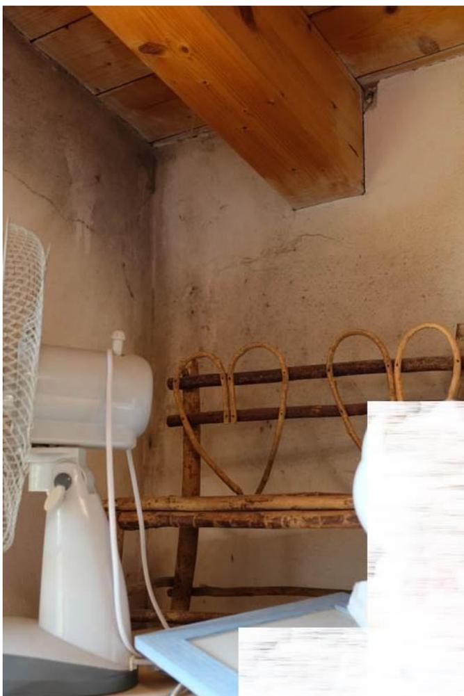
Foto n.65 – particolare parete Sud ed Ovest del vano servizio con manifestazione di “muffa” al piano secondo (sottotetto)
