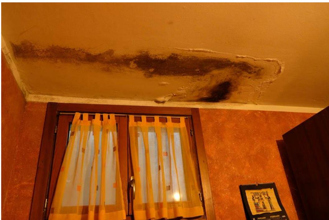
Foto n.72 – particolare dei segni di “muffa” nel locale di servizio, utilizzato ed attrezzato a cucina-pranzo, posto al piano interrato
