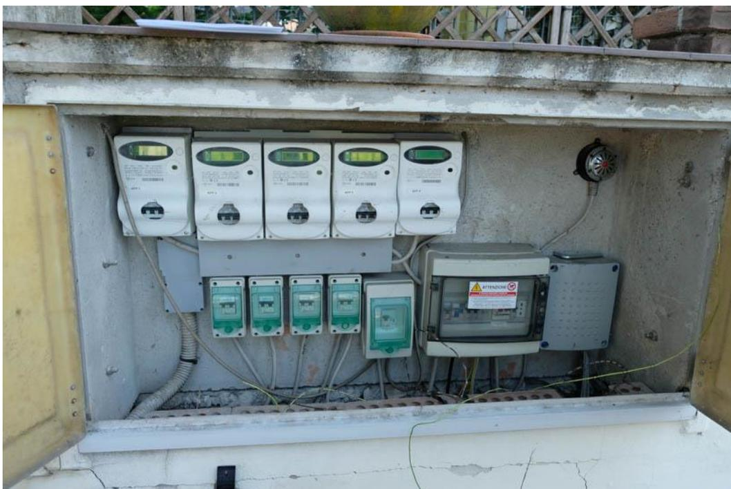
Foto n.101– particolare dei contatori luce elettrica
