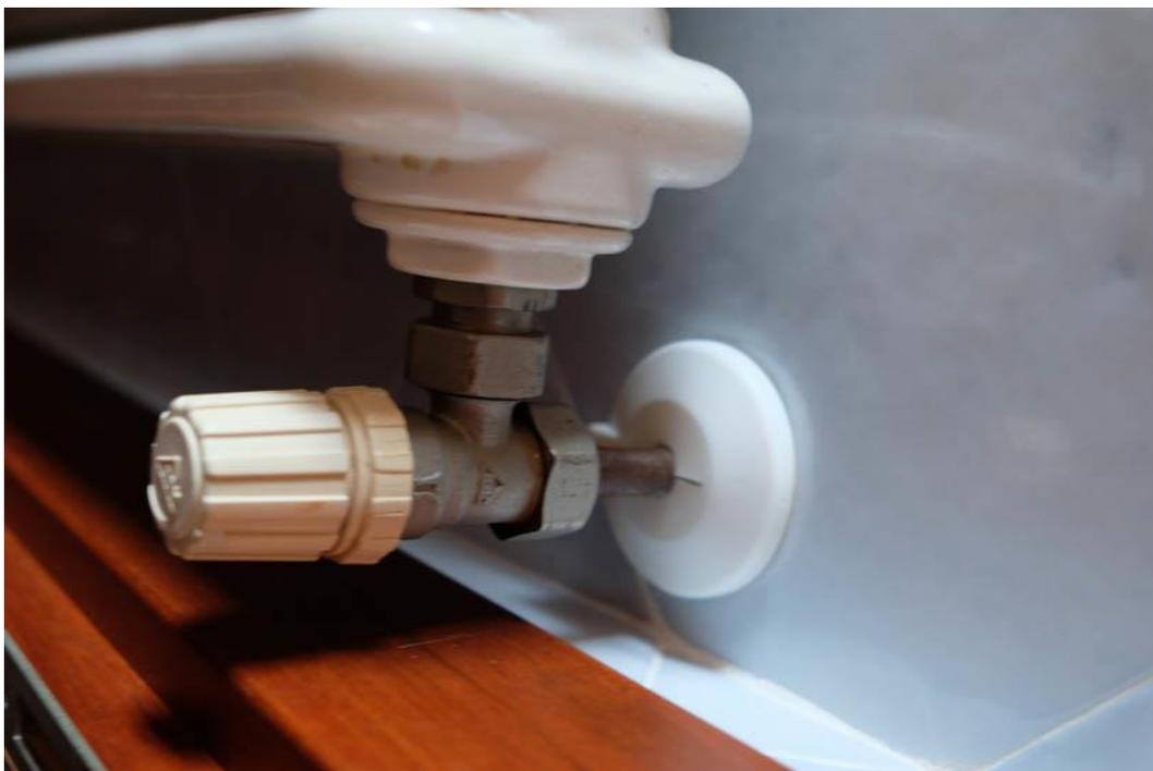
Foto n.55 – particolare attacco e tubazioni impianto di riscaldamento
