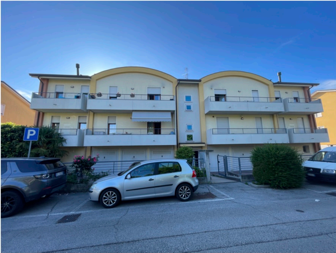
13 - Vista fabbricato lato est
