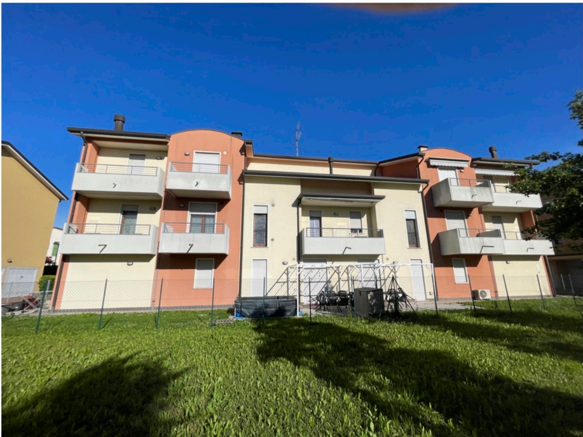
14 - Vista fabbricato lato ovest
