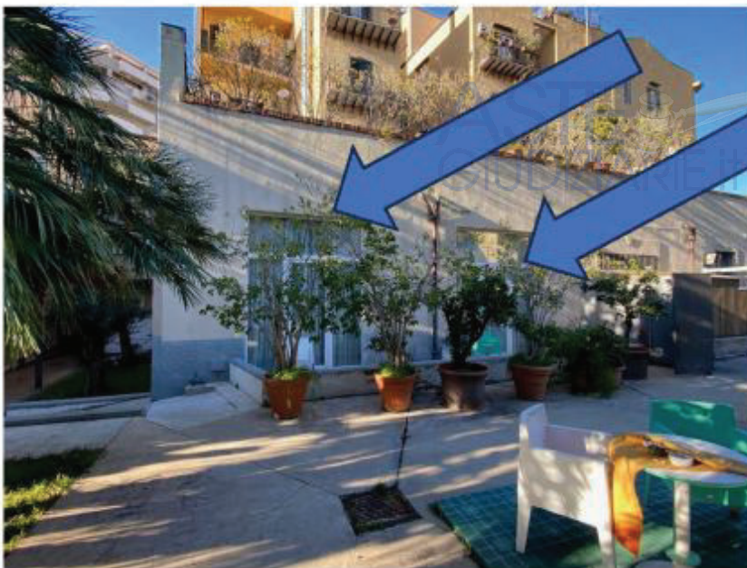
Figura 3: Ingresso Via delle Prigioni n 52 interni 3 e 4
