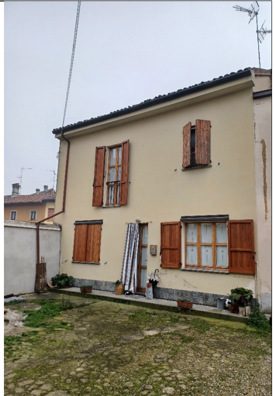
Immagine 18 - Vista del prospetto secondario dell'abitazione dal deposito
