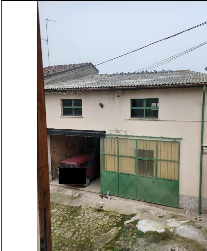
Immagine 17 - Vista del deposito dal pian primo dell'abitazione
