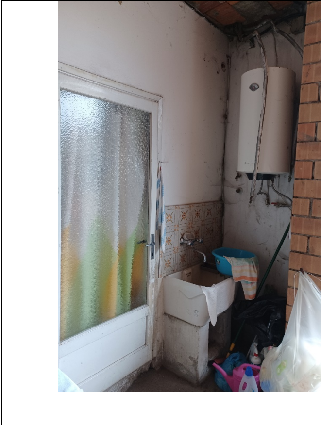
Immagine 21 - Porta del bagno di servizio con lavandino e boiler
