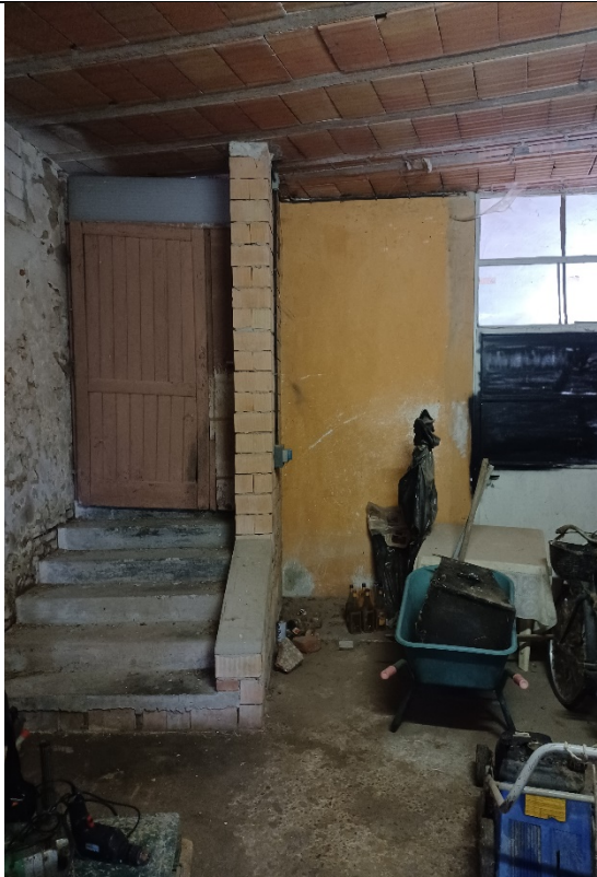
Immagine 25 - Vista interna al piano terra
