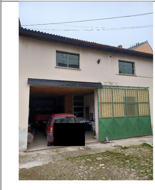
Immagine 19 - Ingresso del fabbricato accessorio
