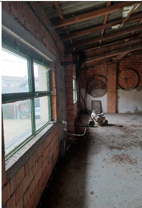
Immagine 31 – Vista interna del piano primo
