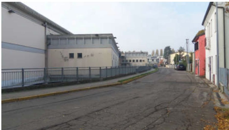
Vista particella 1636 verso ovest
