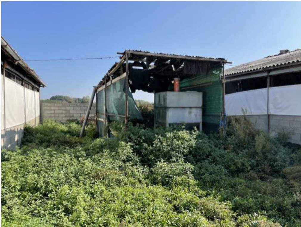
Tettoia n. 3 (Foto 2)
