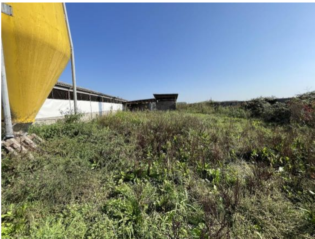
Tettoia n. 5 (Foto 1)
