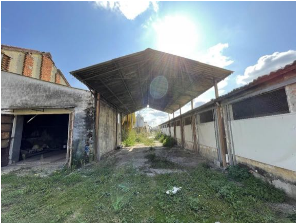
Tettoia n. 1 (Foto 1)
