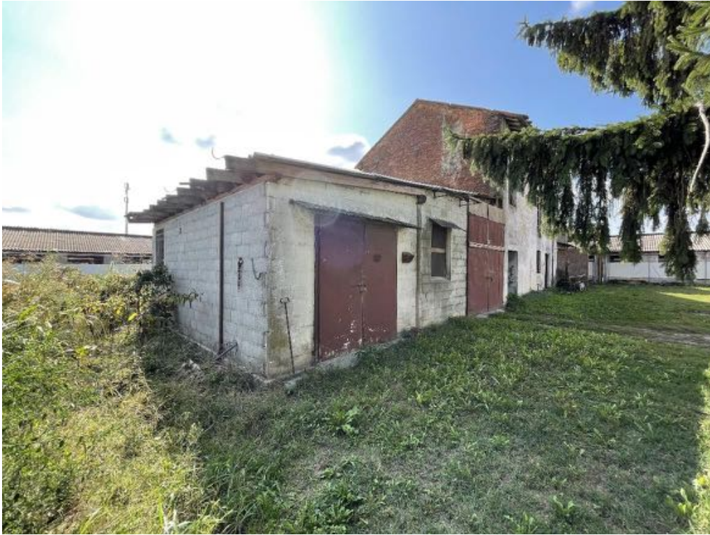
Fabbricati uso deposito/ripostiglio n. 1, 2, 3, 4 e 5 (Foto 1)
