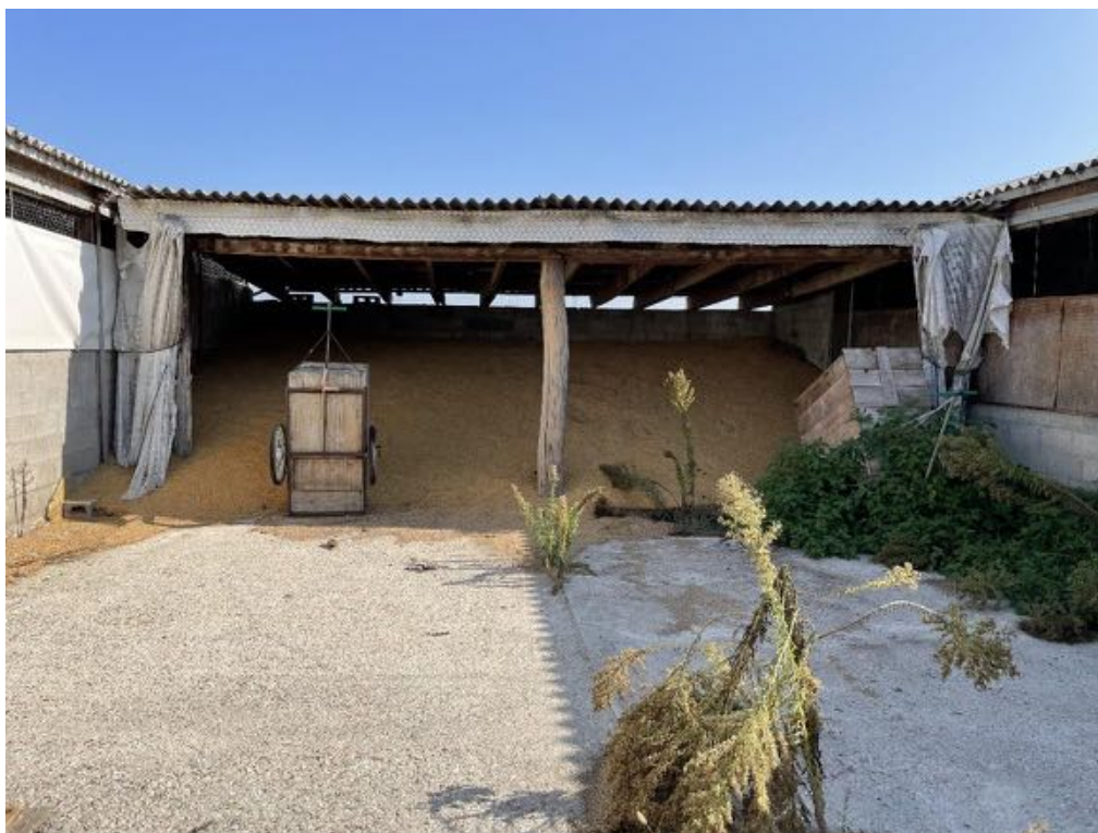
Tettoia n. 4 (Foto 2)
