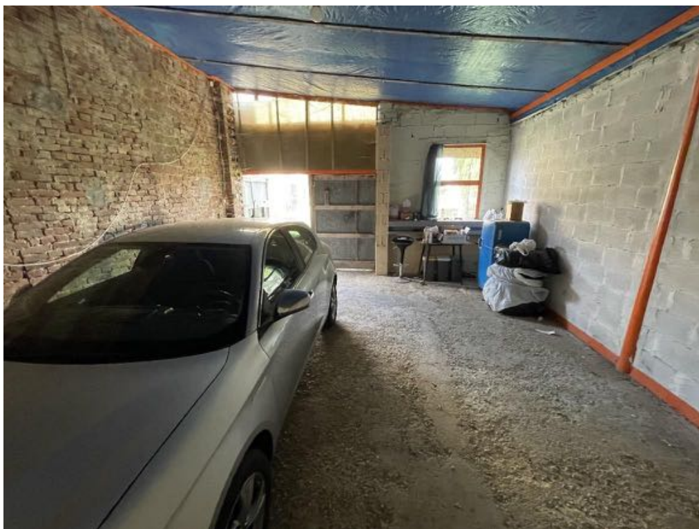
Fabbricato uso deposito/ripostiglio n. 4 - Vista interna (Foto 2)
