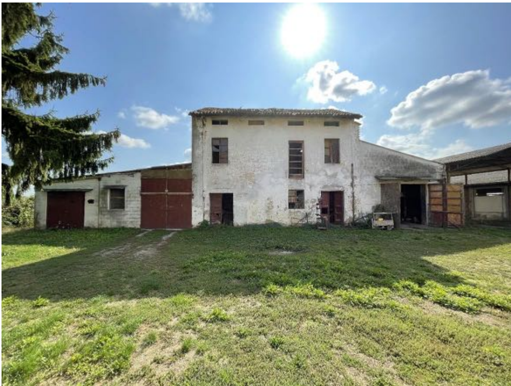
Fabbricati uso deposito/ripostiglio n. 1, 2, 3, 4 e 5 (Foto 2)
