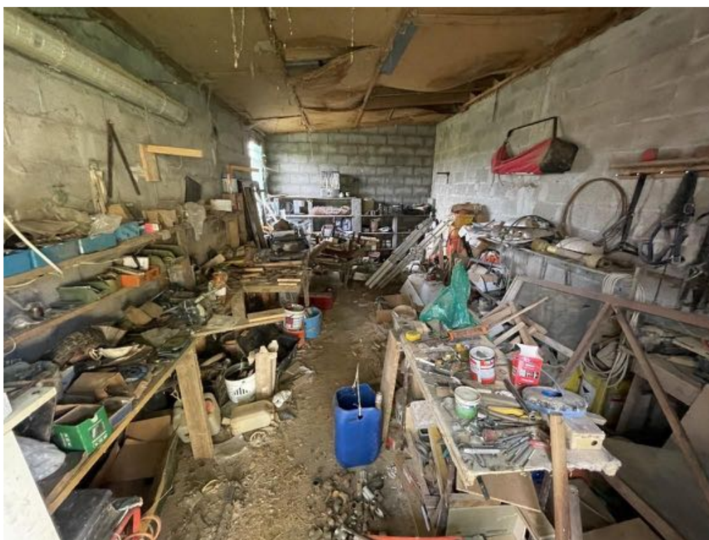
Fabbricato uso deposito/ripostiglio n. 5 - Vista interna
