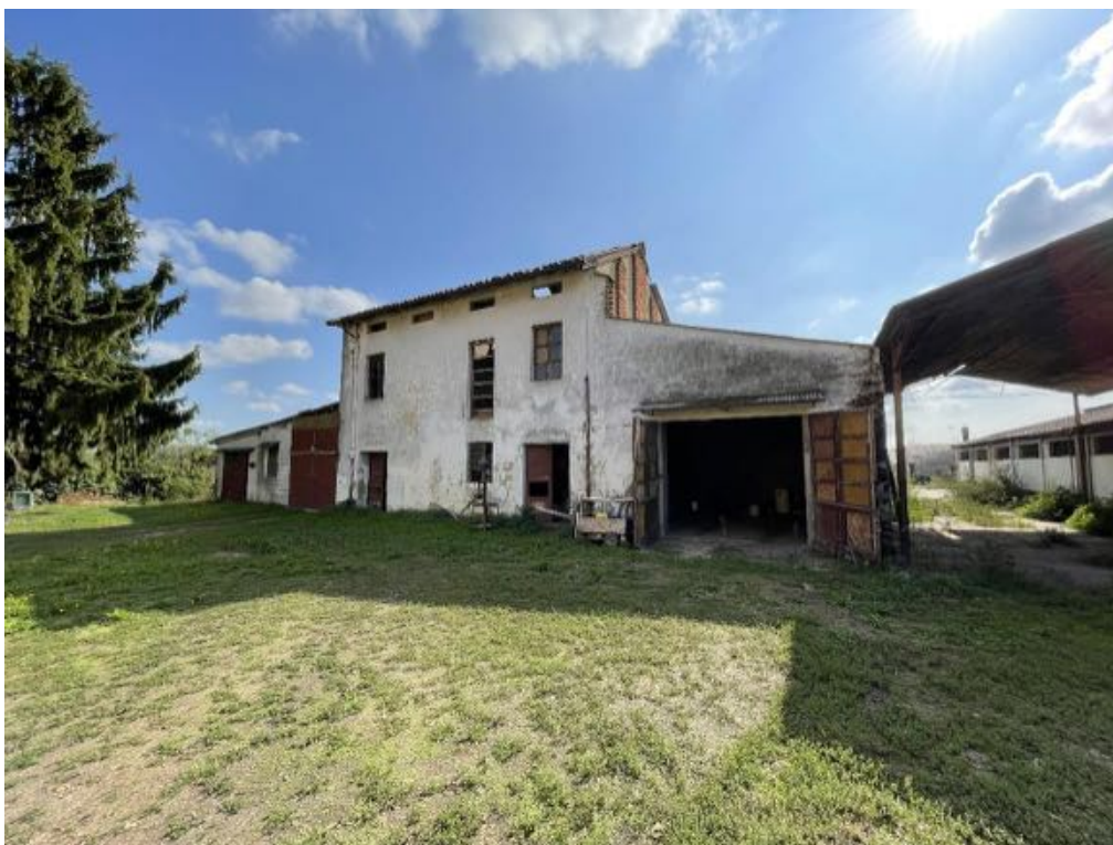
Fabbricati uso deposito/ripostiglio n. 1, 2, 3, 4 e 5 (Foto 3)
