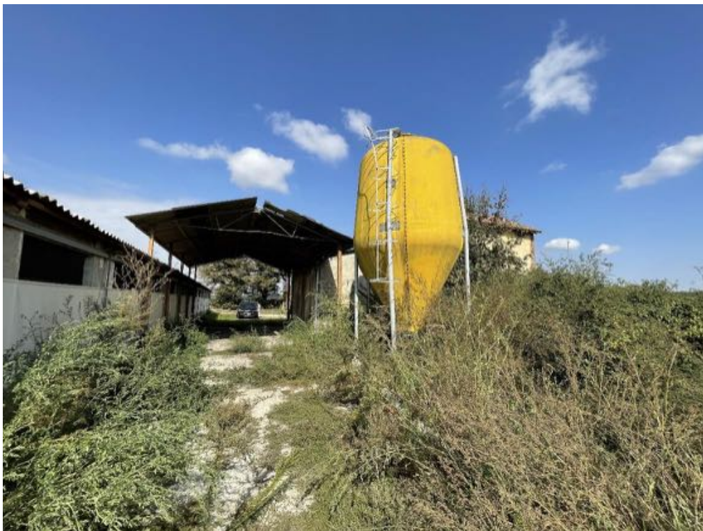
Tettoia n. 1 (Foto 2)
