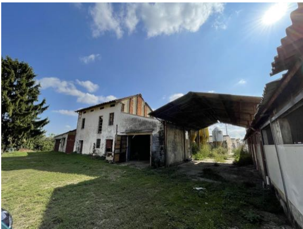
Fabbricati uso deposito/ripostiglio n. 1, 2, 3, 4 e 5 (Foto 4)
