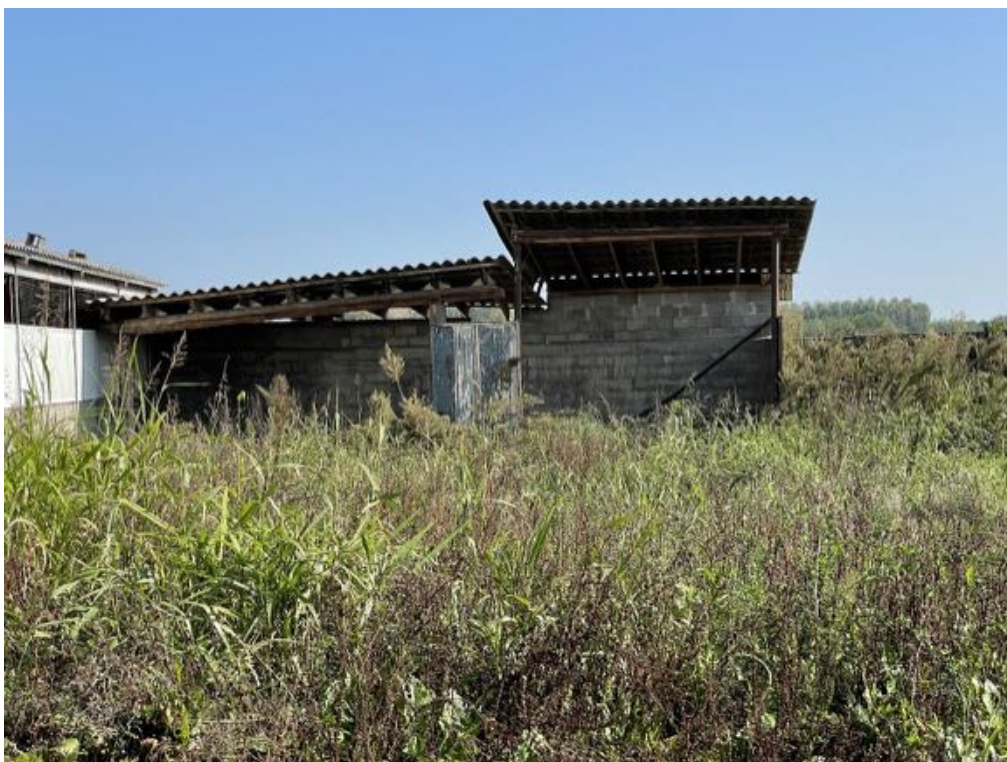
Tettoia n. 5 (Foto 2)
