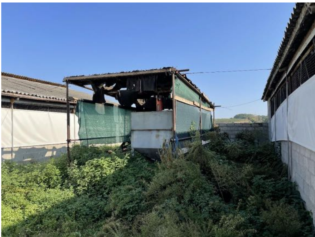
Tettoia n. 3 (Foto 2)
