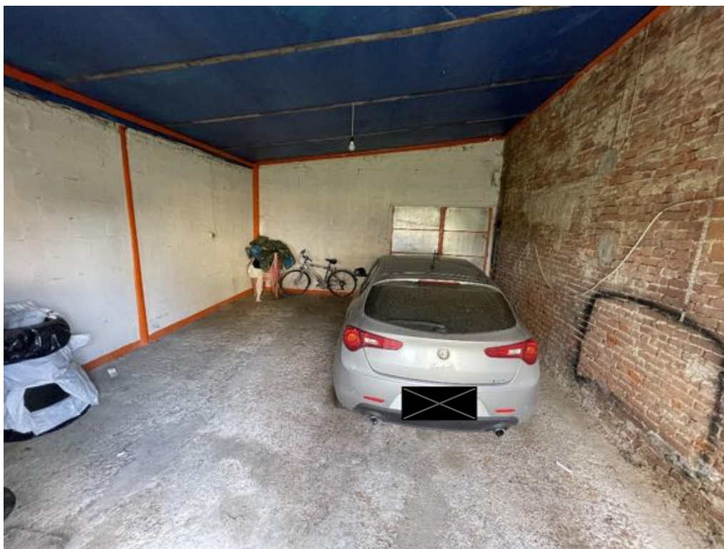
Fabbricato uso deposito/ripostiglio n. 4 - Vista interna (Foto 3)
