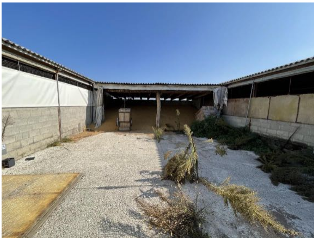
Tettoia n. 4 (Foto 1)
