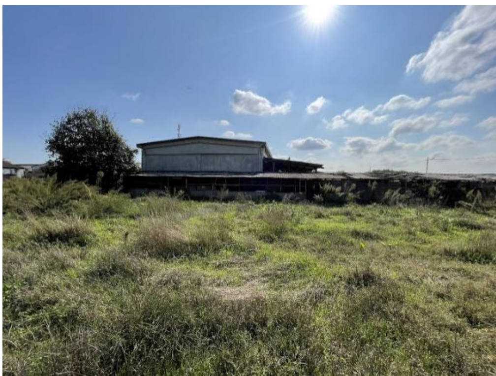
Tettoia n. 6 (Foto 1)
