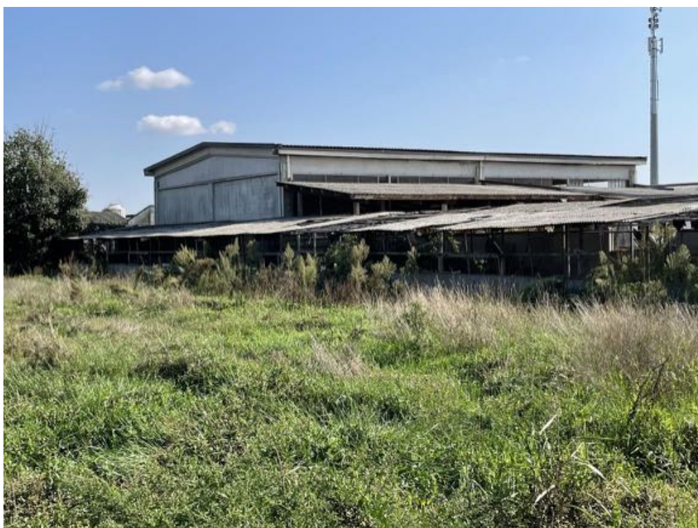
Tettoia n. 6 (Foto 2)
