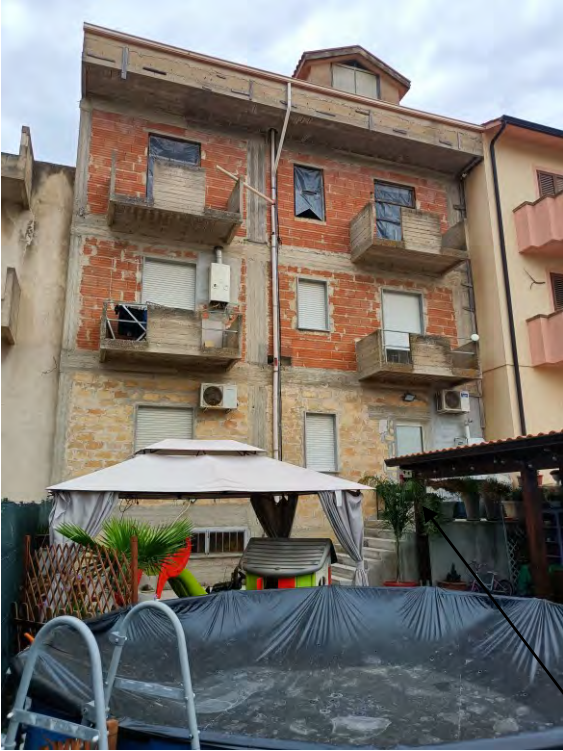
FOTO N° 2 - PROSPETTO SUL TERRENO RETROSTANTE
