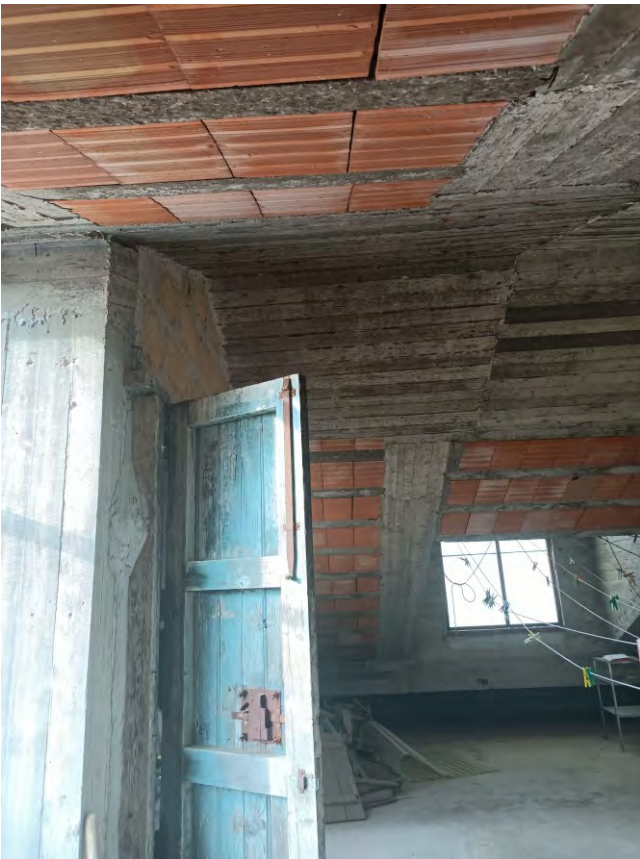
FOTO N° 2-2 – SOTTOTETTO IN CORSO DI COSTRUZIONE
