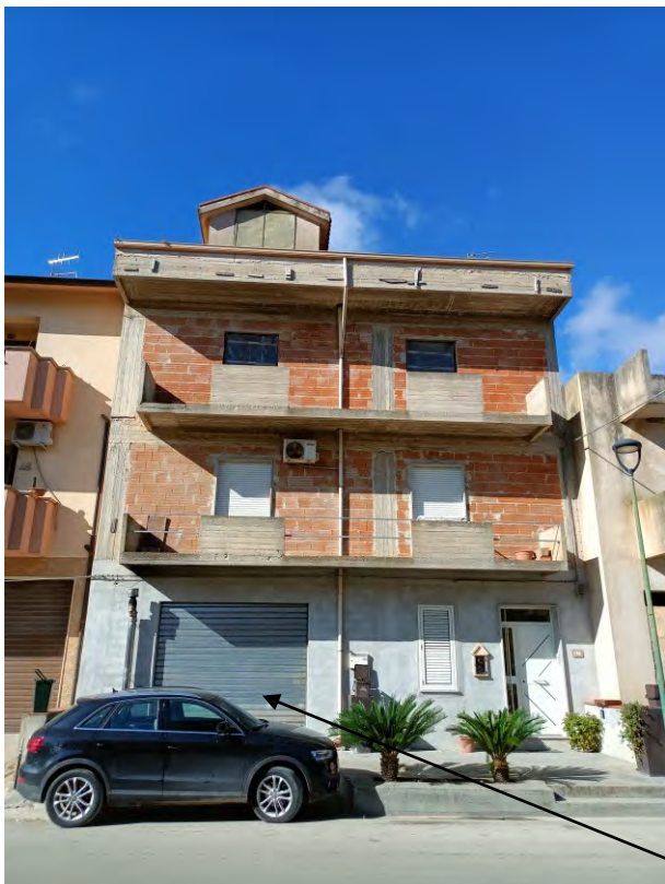
FOTO N° 14- ACCESSO APPARTAMENTO PIANO TERRA DA SP 29
