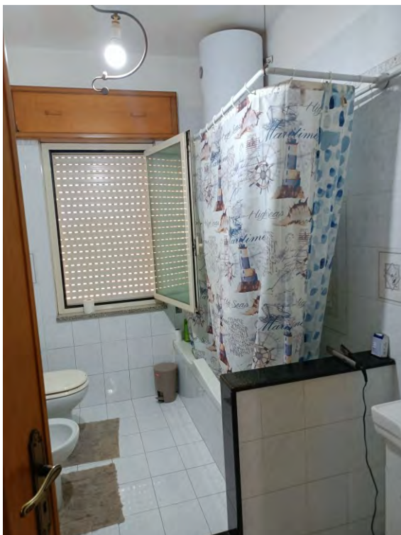
FOTO N° 17 -APPARTAMENTO PIANO PRIMO- BAGNO
