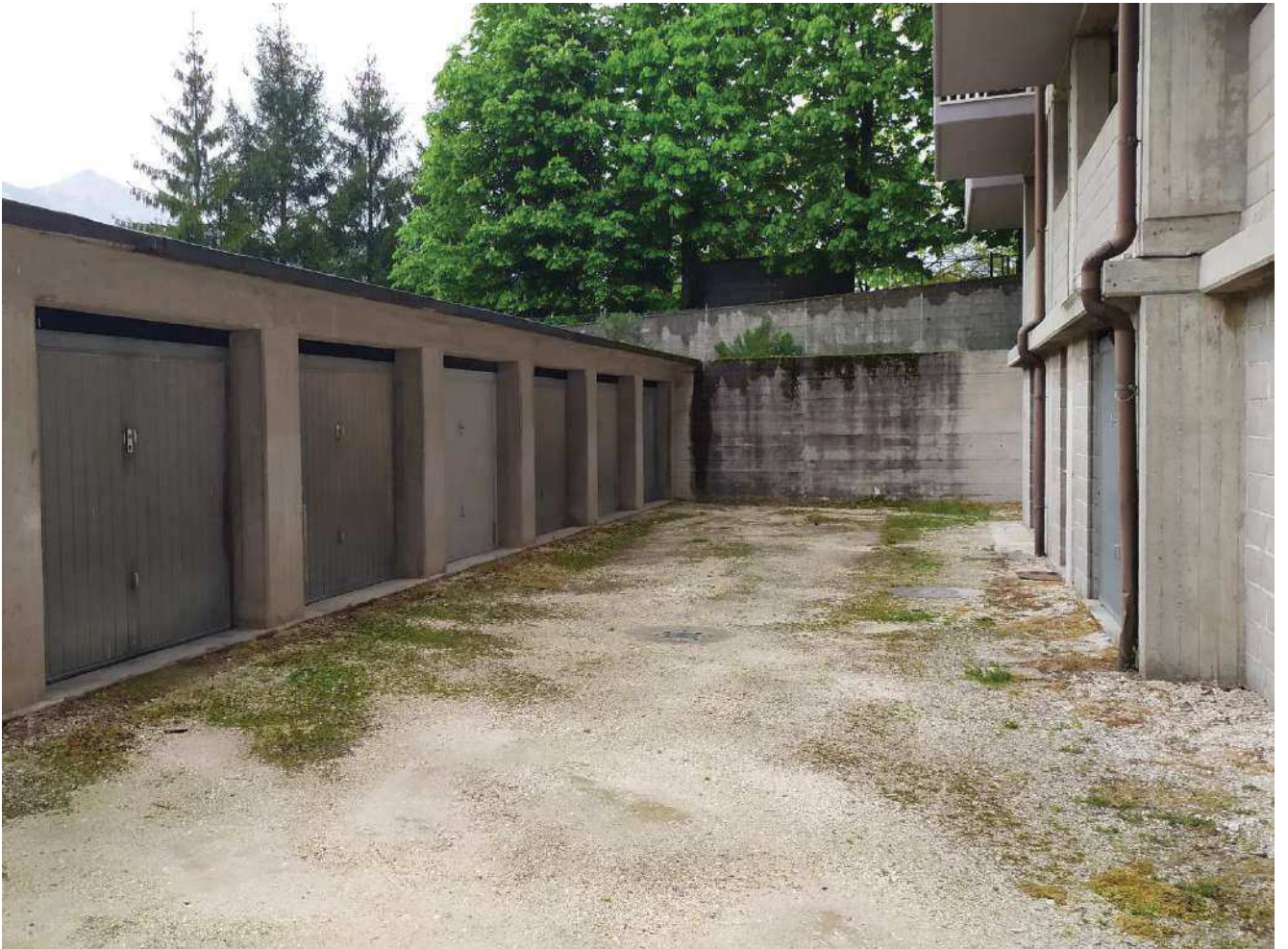
Area di manovra condominiale
