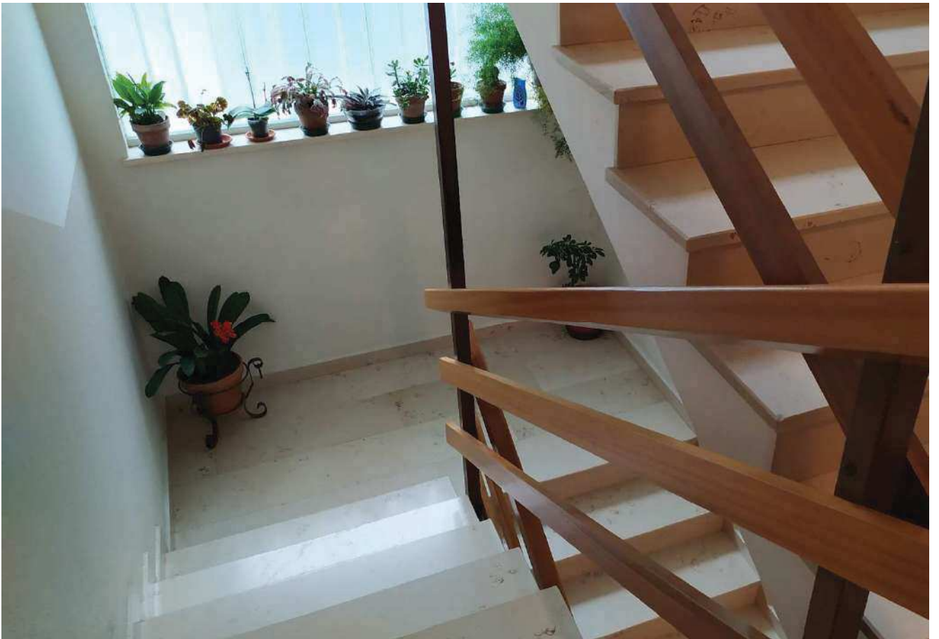
Vano scala condominiale
