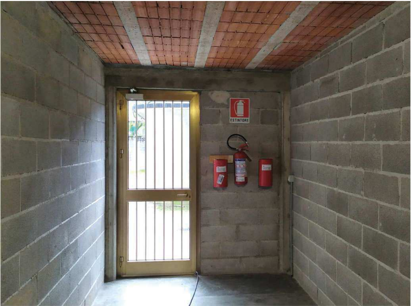
Corridoio condominiale al piano seminterrato
