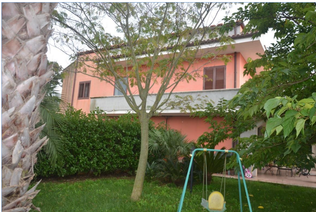
Fot. 17 Vista generale, prospetto nord
