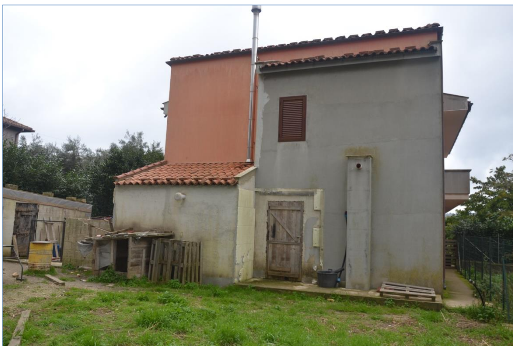
Fot. 18 Vista generale, prospetto est
