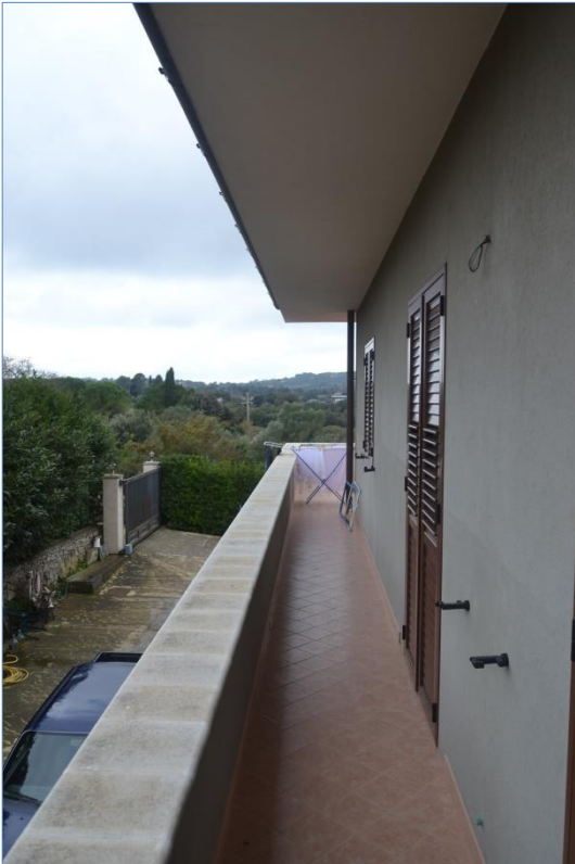
Fot. 13 Piano primo, balcone prospetto sud
