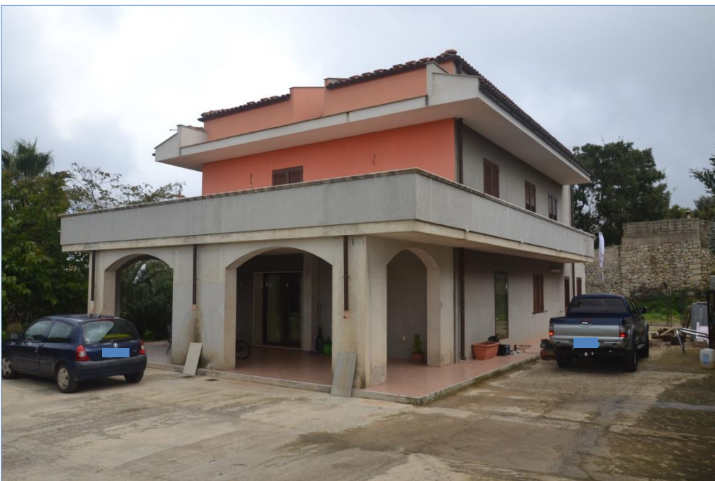
Fot. 16 Vista generale, prospetti ovest e sud
