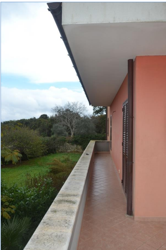
Fot. 14 Piano primo, balcone prospetto nord
