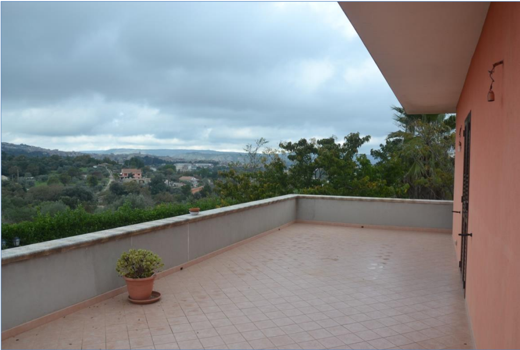
Fot. 15 Piano primo, terrazza ovest
