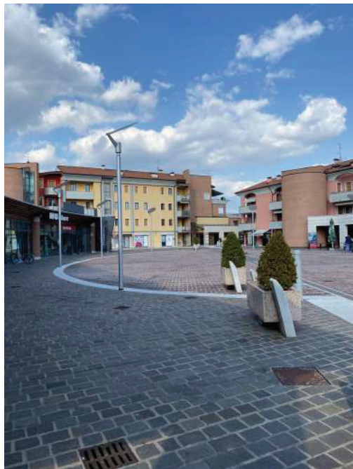
Foto 1 – Facciata esterna condominio
