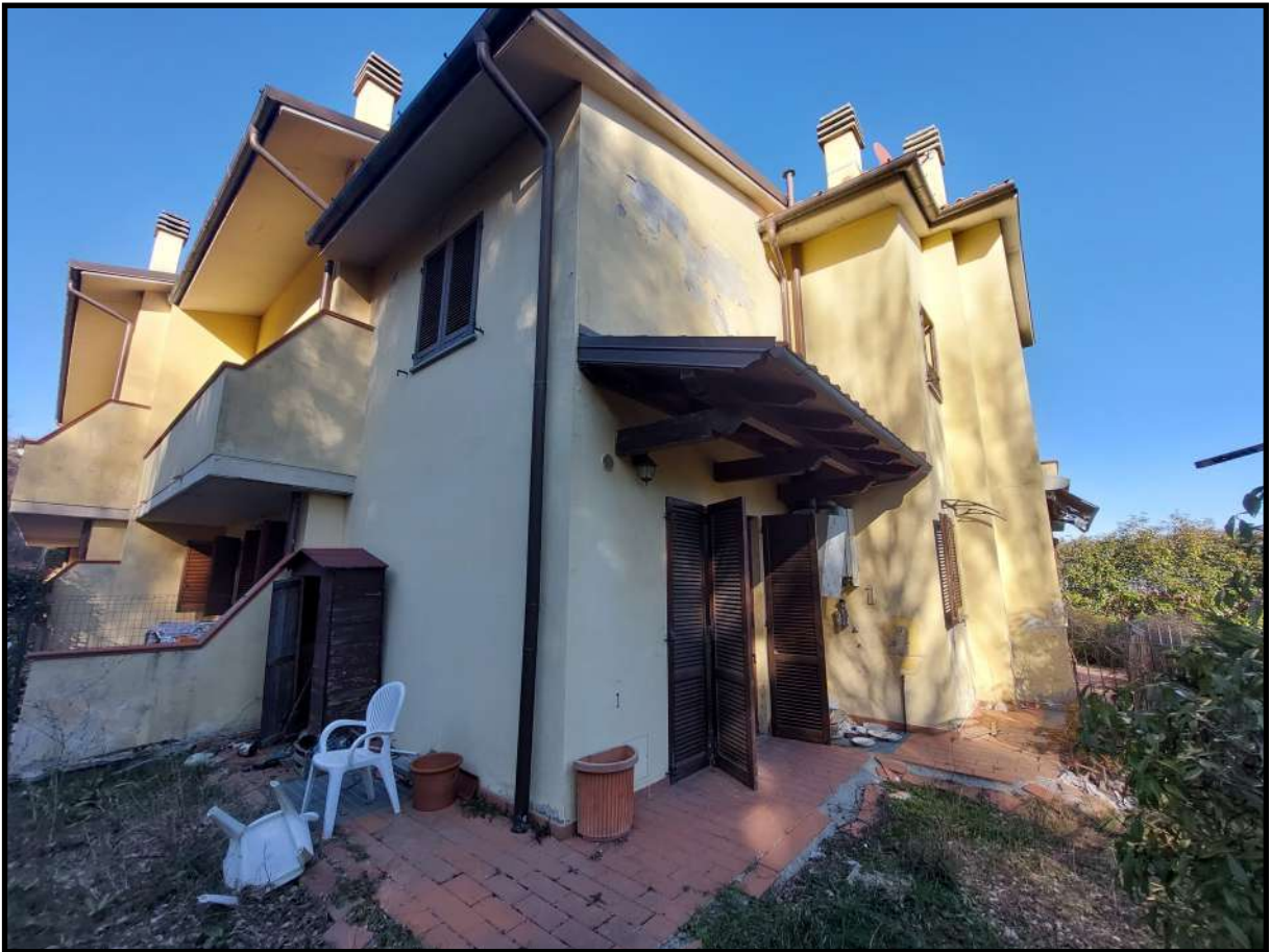
Vista dal resede esclusivo del fabbricato abitativo oggetto di pignoramento
