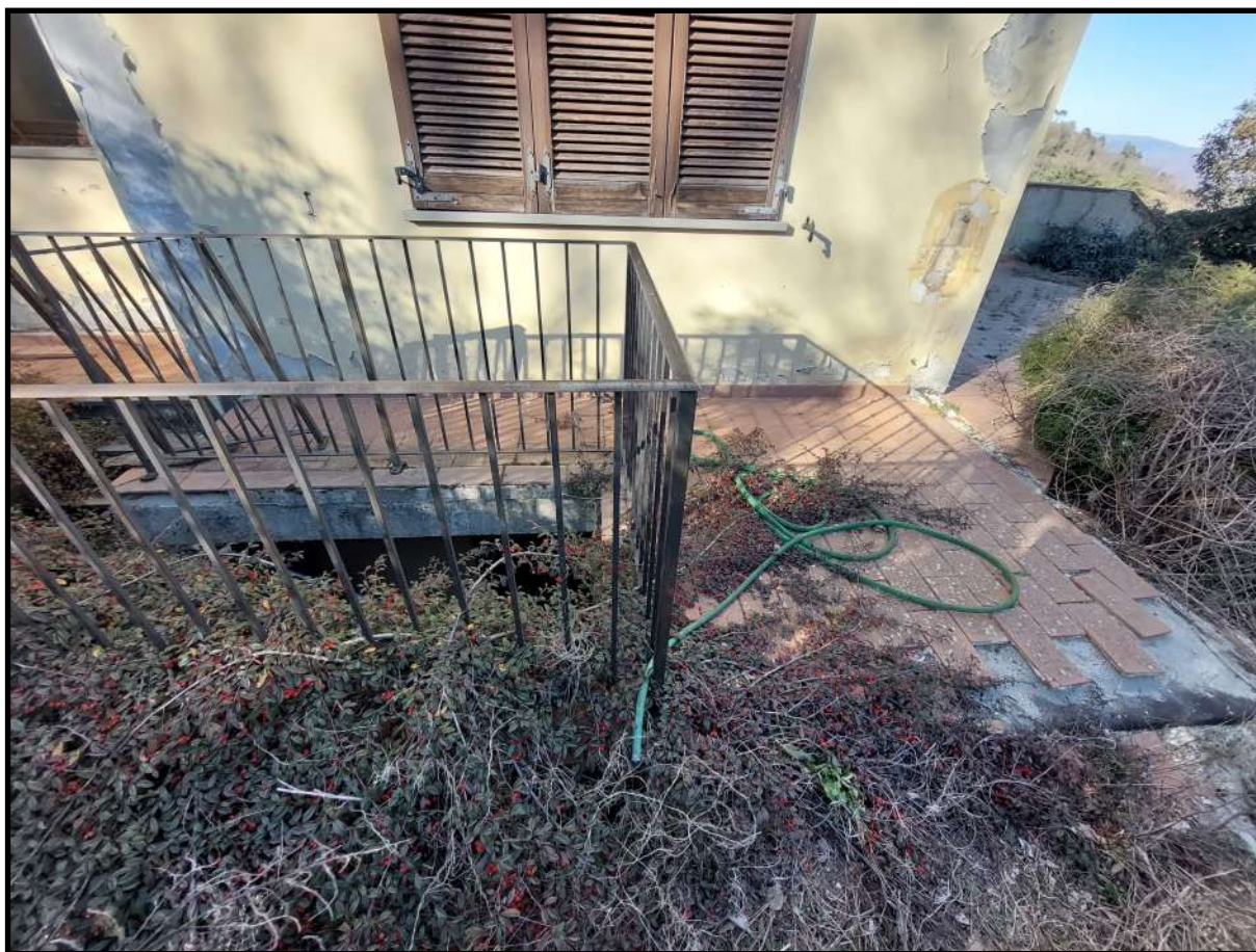
Particolare del camminamento esterno a copertura del sottostante scannafosso
