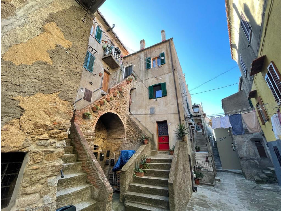
Foto : Facciata esterna
