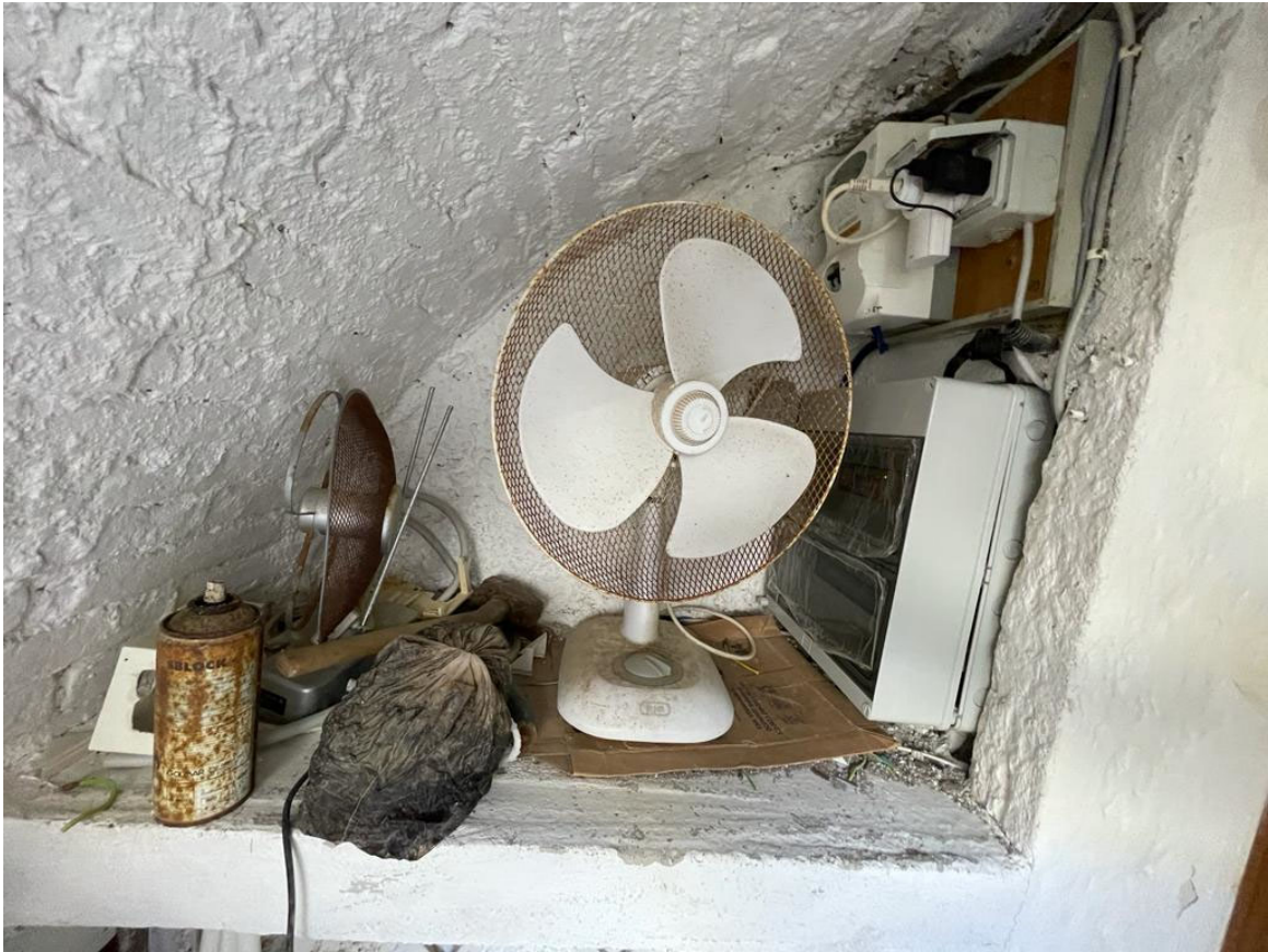
Foto 9: Finestrella tamponata in assenza di autorizzazione
