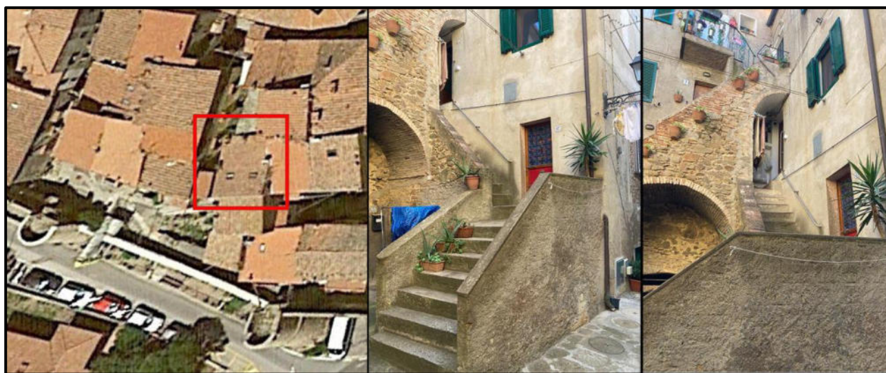
Accesso all'immobile: foto aerea e vista dalla piazzetta antistante
