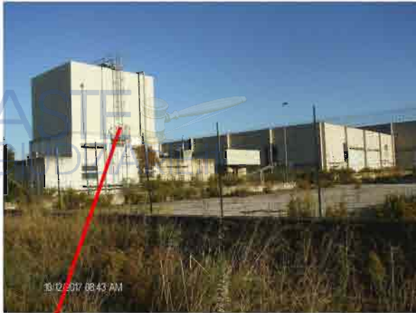
Stazione di pompaggio antincendio
