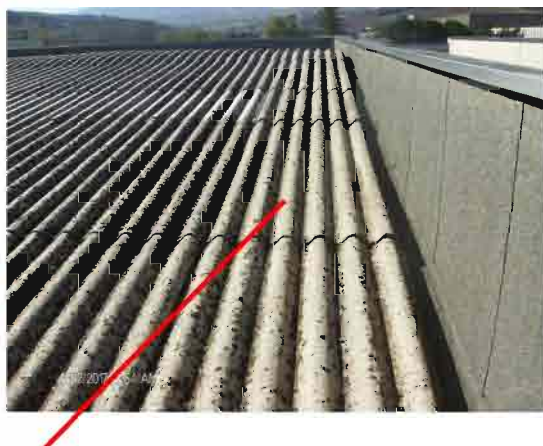
Onduline in fibra di cemento (amianto)
