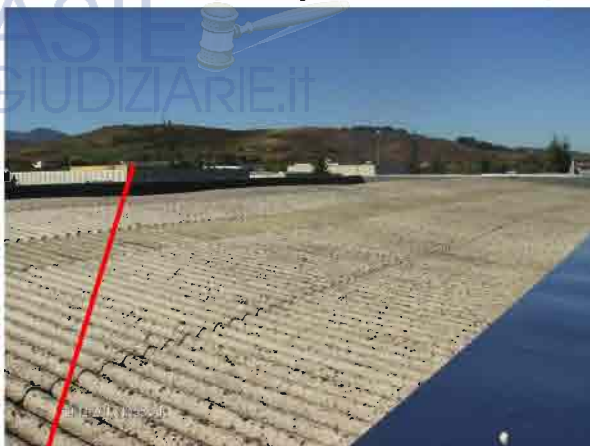
Onduline in fibra di cemento (amianto)
