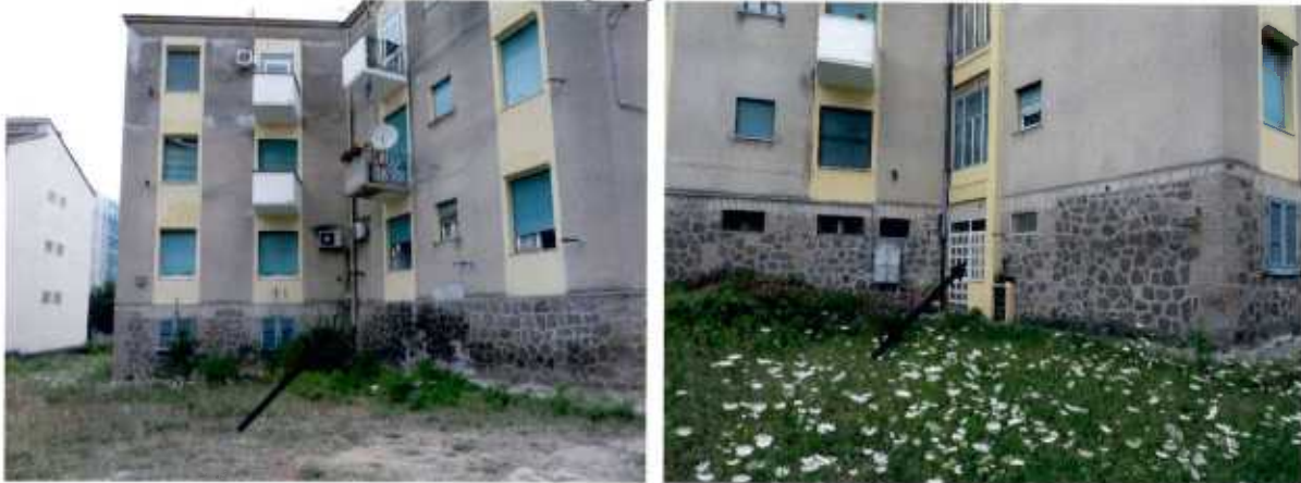
Foto n.10-11 – prospetto su cortile interno
