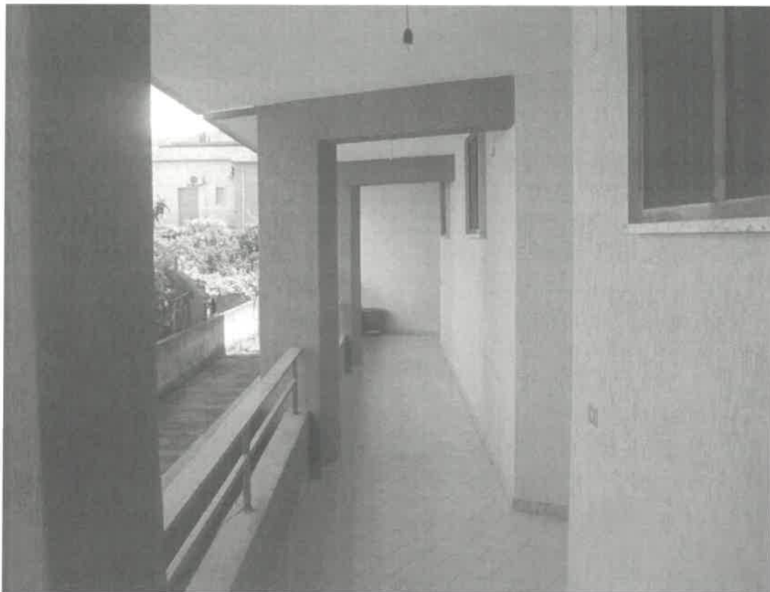
Foto n. 5 – ballatoio accesso appartamenti al piano terra
