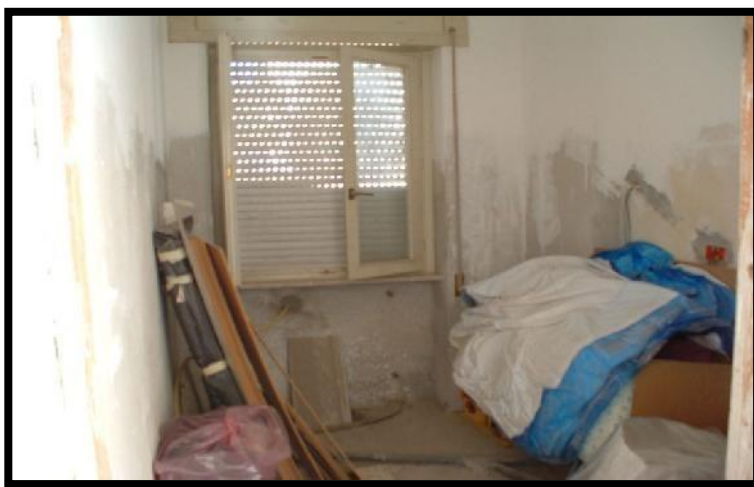
FOTO 37 - Ambienti in corso di ultimazione sub 5
