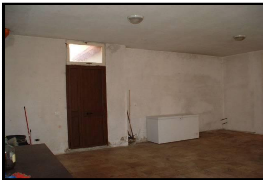
FOTO 28- la porta che conduce al giardino sul retro
