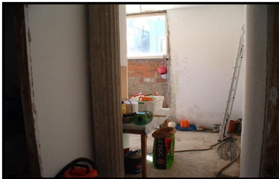
FOTO 36 - Ambienti in corso di ultimazione
