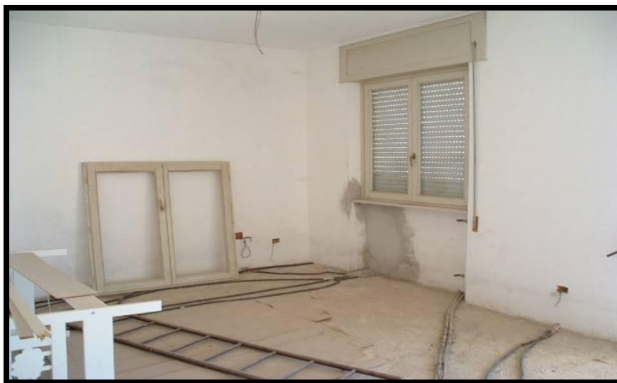
FOTO 35- Ambienti in corso di ultimazione (sub 5)
