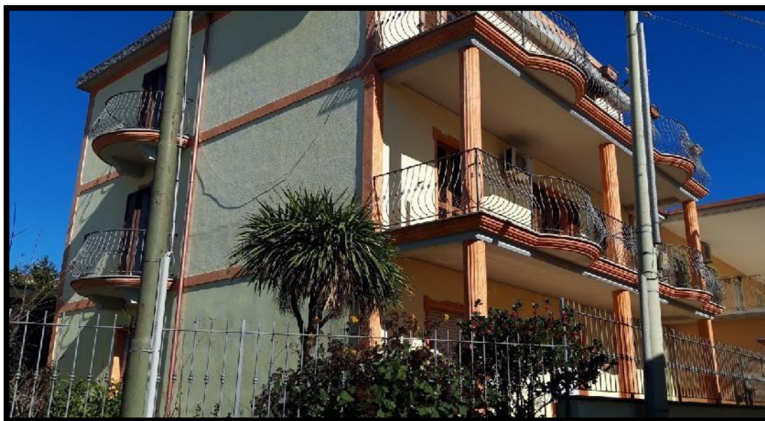
FOTO 1-Vista dell'edificio, da Via Marche
