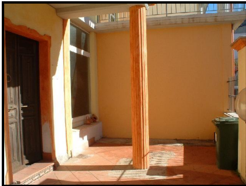
FOTO 7. Ingresso all'edificio su Via Marche al n°12
