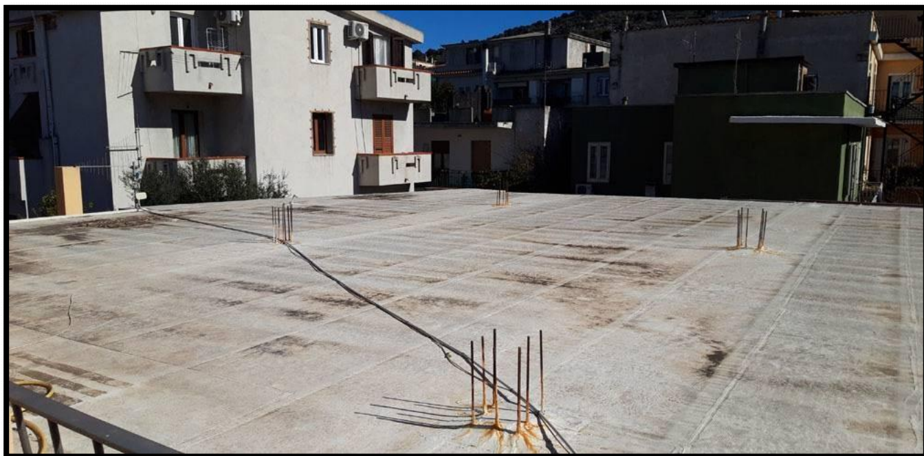
FOTO 38 – Il lastrico solare , (solaio superiore del sub 5)
