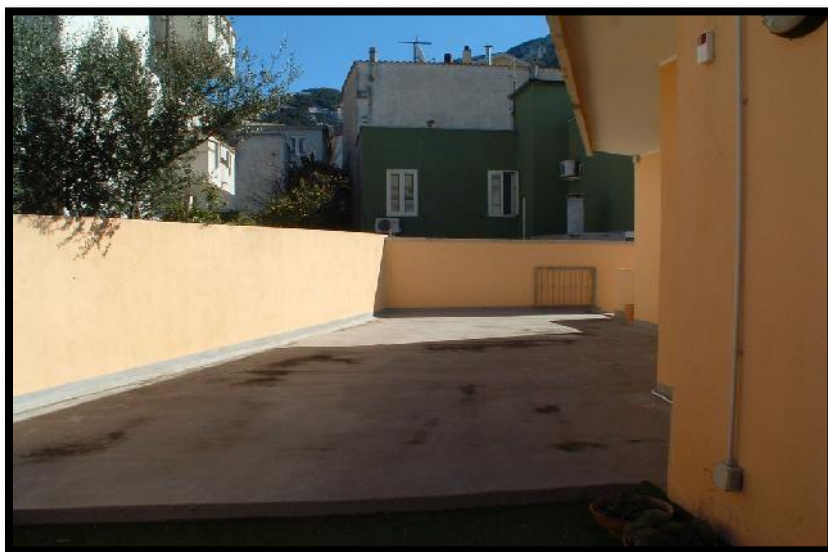
FOTO 30 -Terrazza in adiacenza all'ingresso dell'appartamento (Sub 5).
