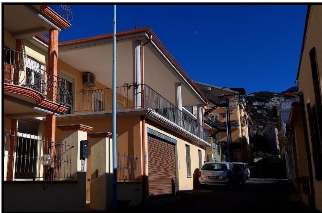
FOTO 2- Vista dell'ampliamento da via Marche.
