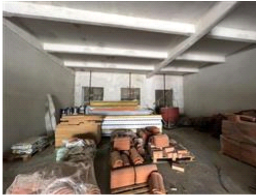
vista generale dell'interno del vano principale verso la parete di fondo
