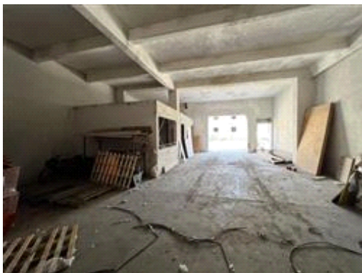
vista dell'interno del vano principale verso l'ingresso dal cortile
