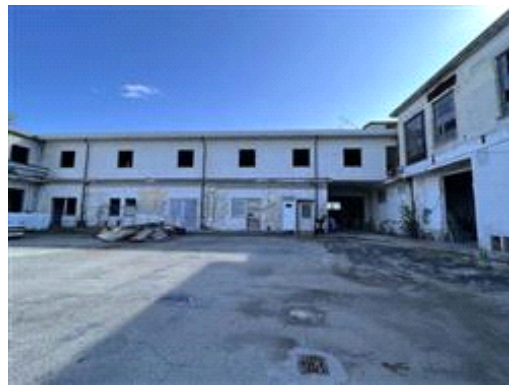
vista del prospetto interno sud con affaccio sul cortile di proprietà
