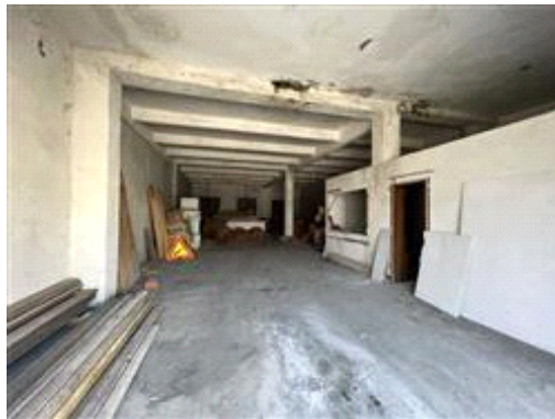
vista dell'interno dell'immobile in corrispondenza dell'ingresso
