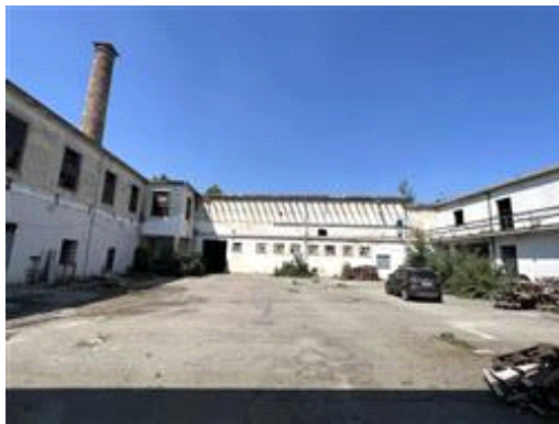
vista dei prospetti interni nord, ovest ed est con affaccio sul cortile di proprietà
