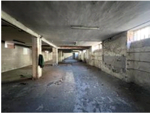
vista del locale posto al piano interrato nella manica lato interno via Calabria
