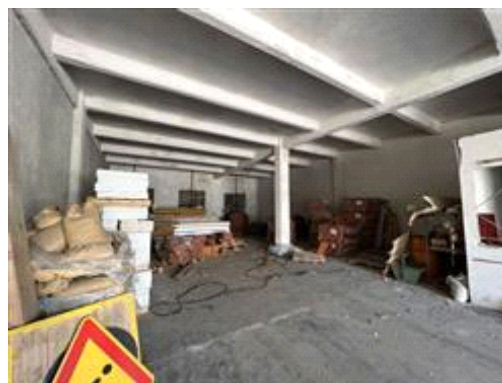
vista generale dell'interno del vano principale
