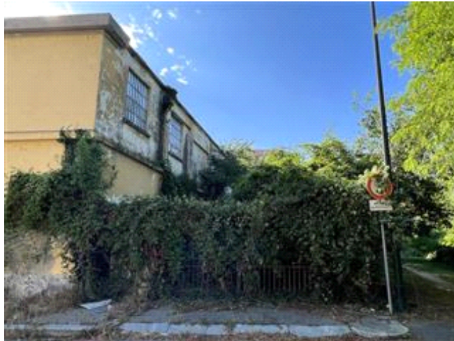
prospetto nord con affaccio sul verde del mappale 260 di altra proprietà
