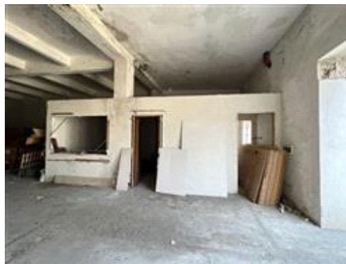
vista del vano secondario in costruzione, posto sulla destra dell'ingresso
