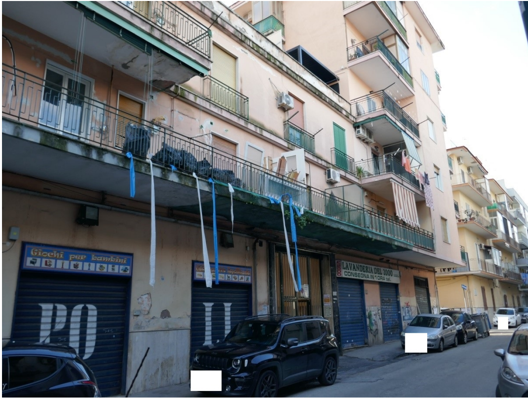
FOTO 1 – FRONTE FABBRICATO SU VIA ALFANO I
