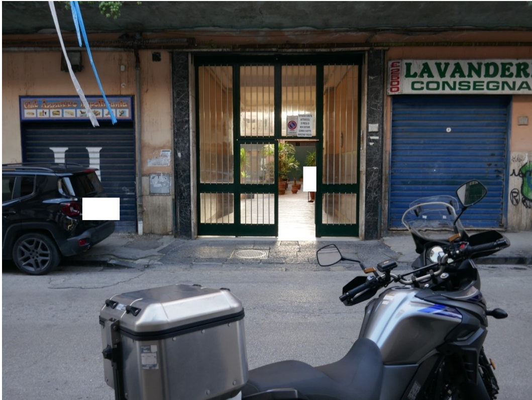
FOTO 3 – PORTONE INGRESSO FABBRICATO CIVICO 19/E
