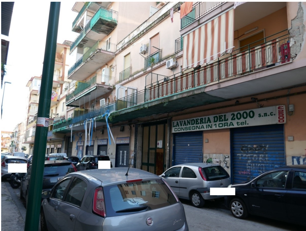
FOTO 2 – FRONTE FABBRICATO SU VIA ALFANO I
