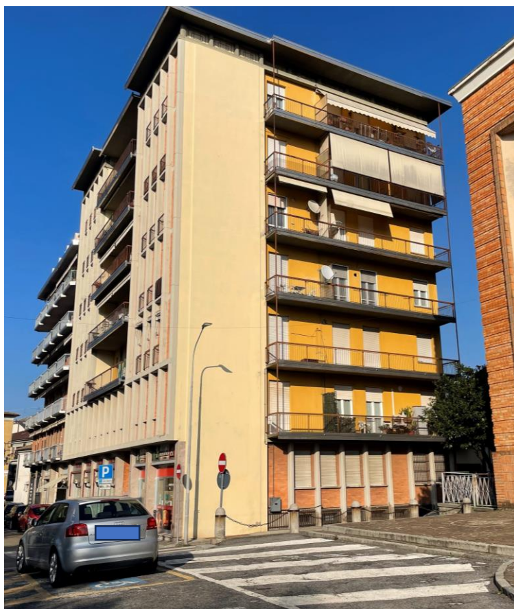
Foto 1. Fabbricato di cui fa parte l'immobile oggetto di stima
