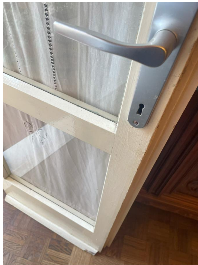
Foto 22. Particolare infissi esterni
