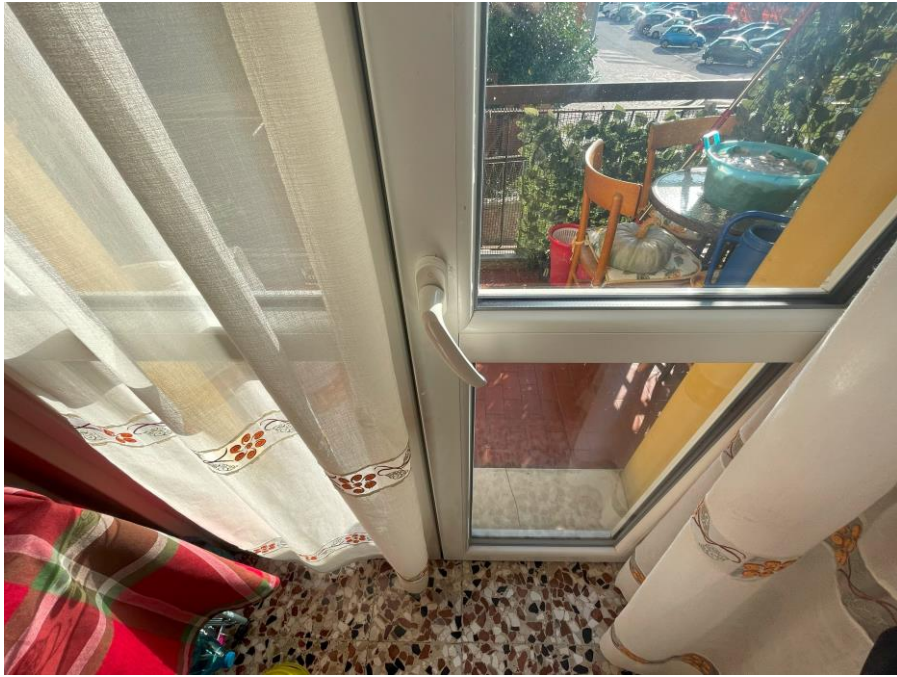
Foto 21. Particolare infissi esterni
