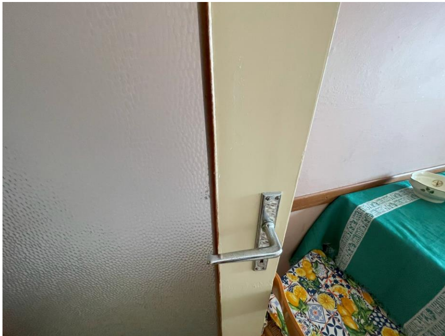
Foto 20. Particolare infissi interni
