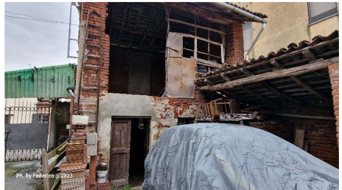
6. Esterno rustico e fienile al piano primo
