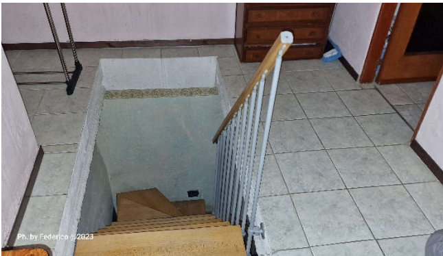
19. P. primo: forometria del solaio con corpo scala
