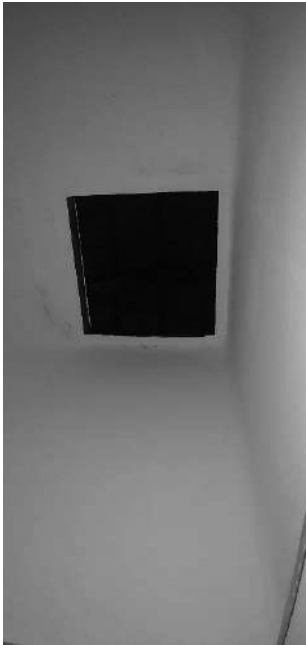
24- Appartamento al Piano 1: botola per sottotetto
