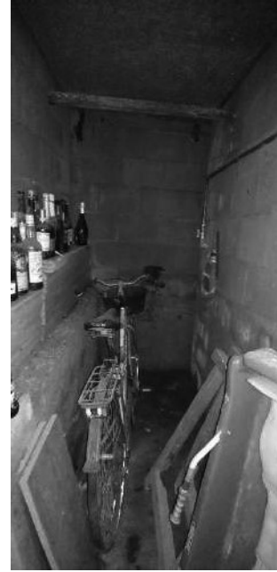
13- Piano Terra: Centrale Termica
