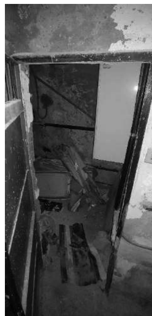
09- Piano Terra: Ripostiglio
