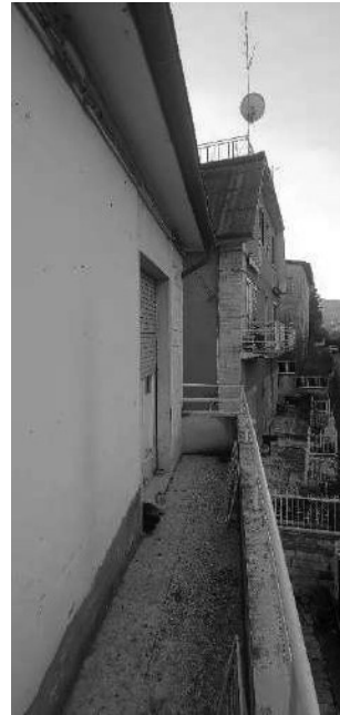
25- Appartamento al Piano 1: Balcone
