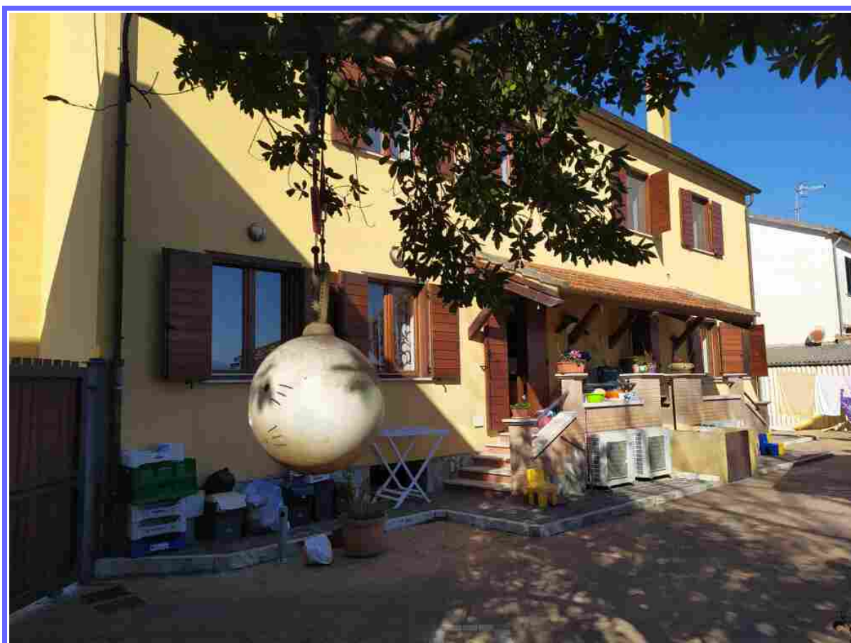
FOTO 9 - PROSPETTO SU CORTILE INTERNO
