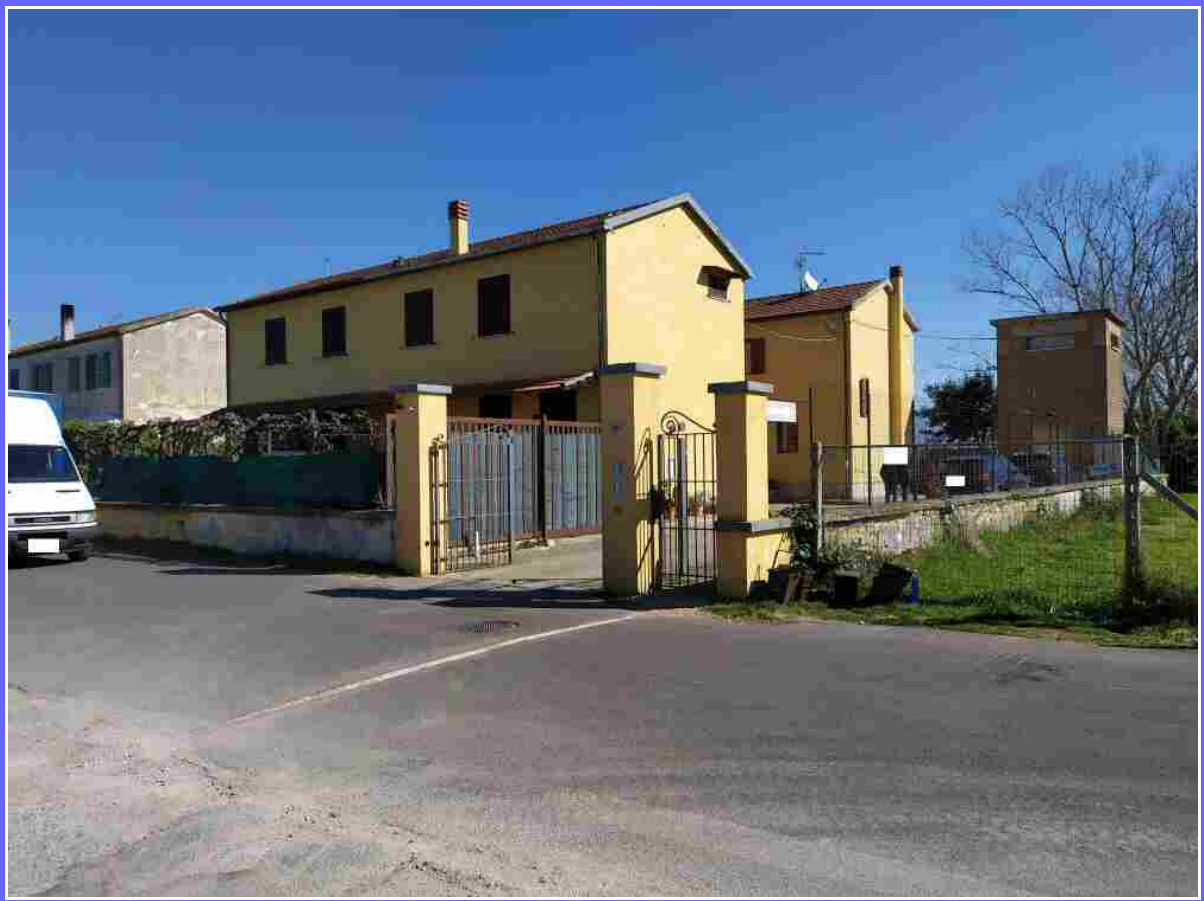
FOTO 3 - VIA COVINO - INGRESSO AL LOTTO
