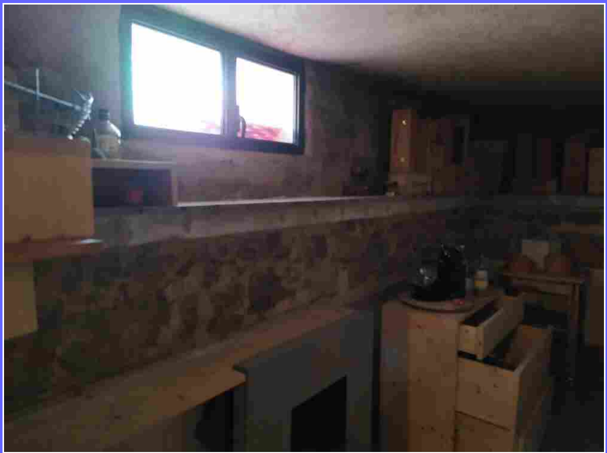
FOTO 41 - CANTINA - DEPOSITO LOCALE 3 VISTA 2
