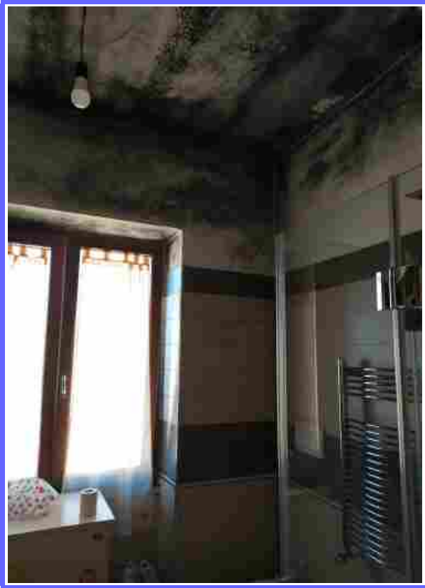
FOTO 27 - BAGNO PIANO PRIMO - VISTA 2
