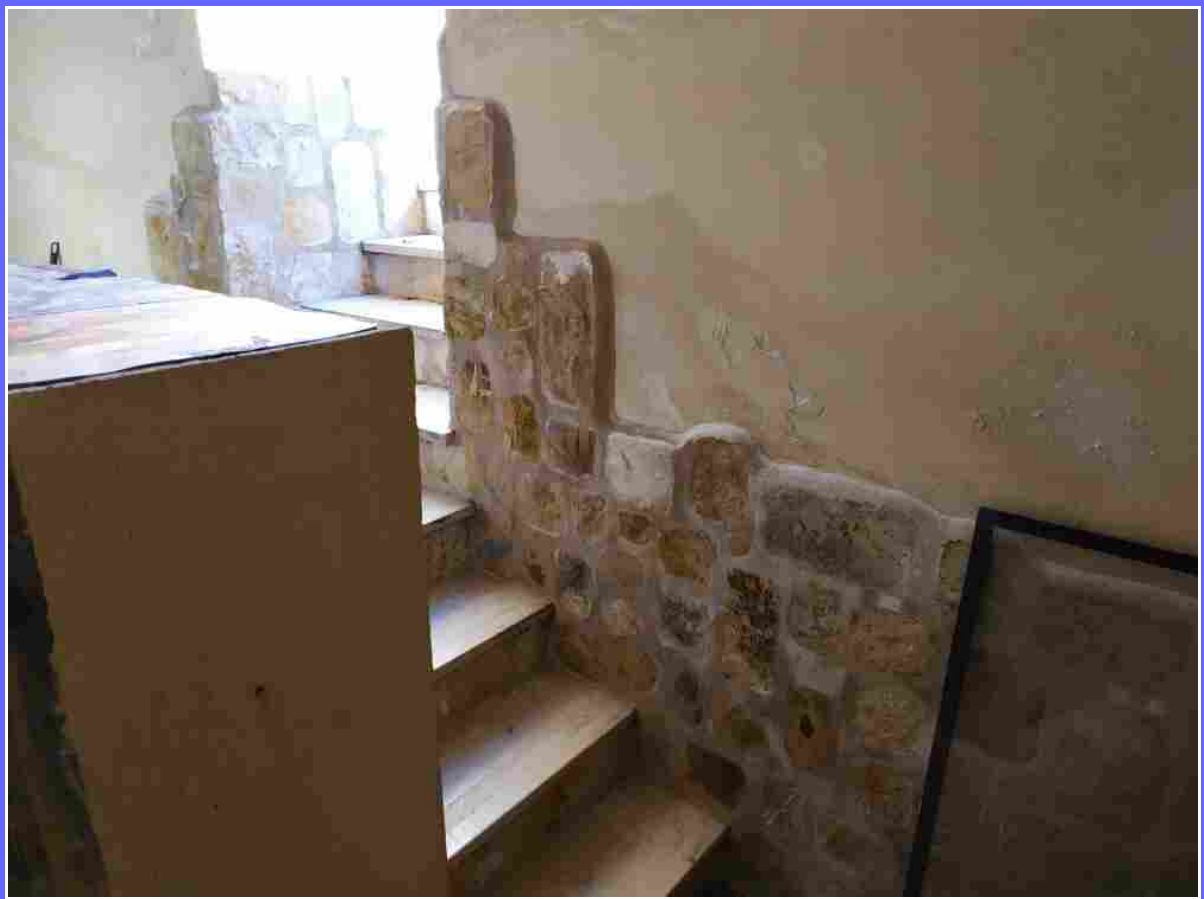
FOTO 35 - INGRESSO CANTINA - DEPOSITO VISTA 2
