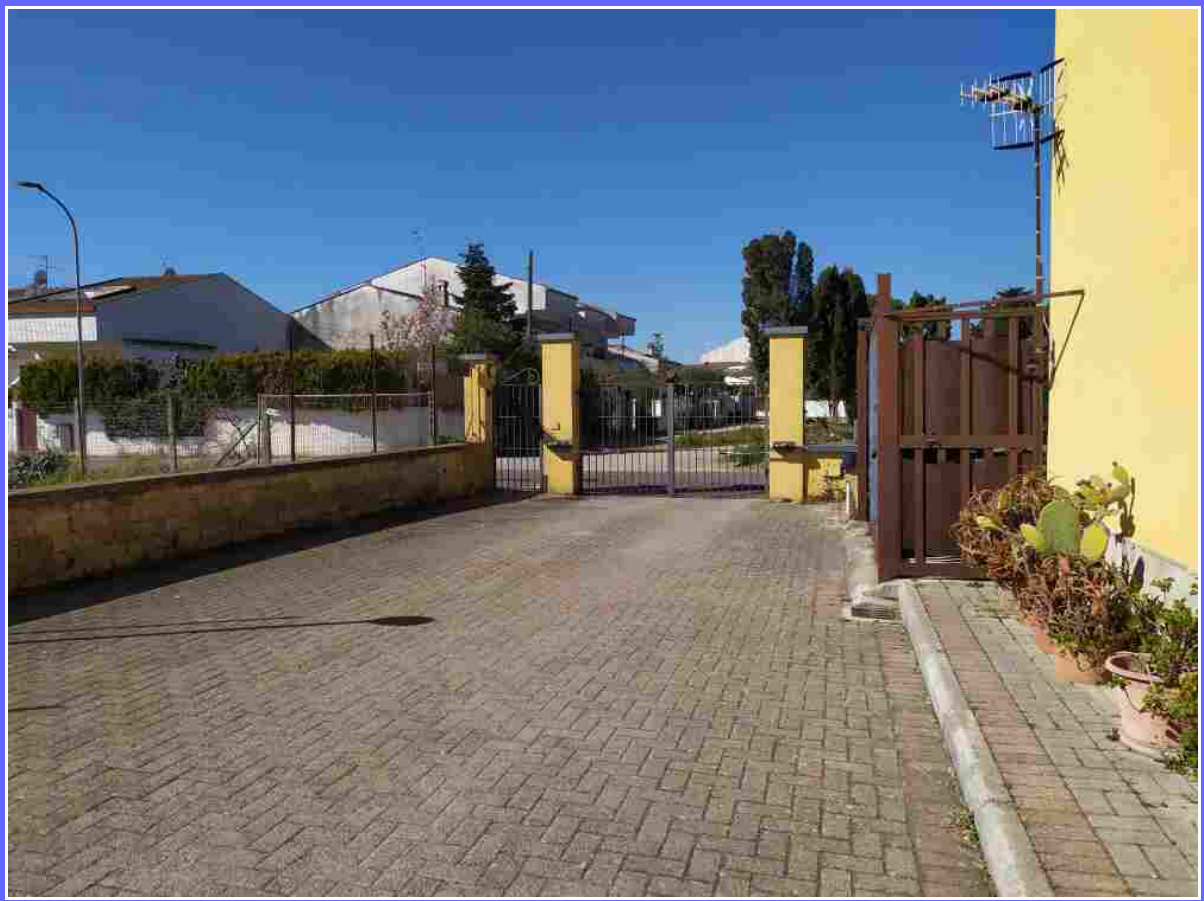
FOTO 5 - VISTA INGRESSO DALL'INTERNO DEL LOTTO
