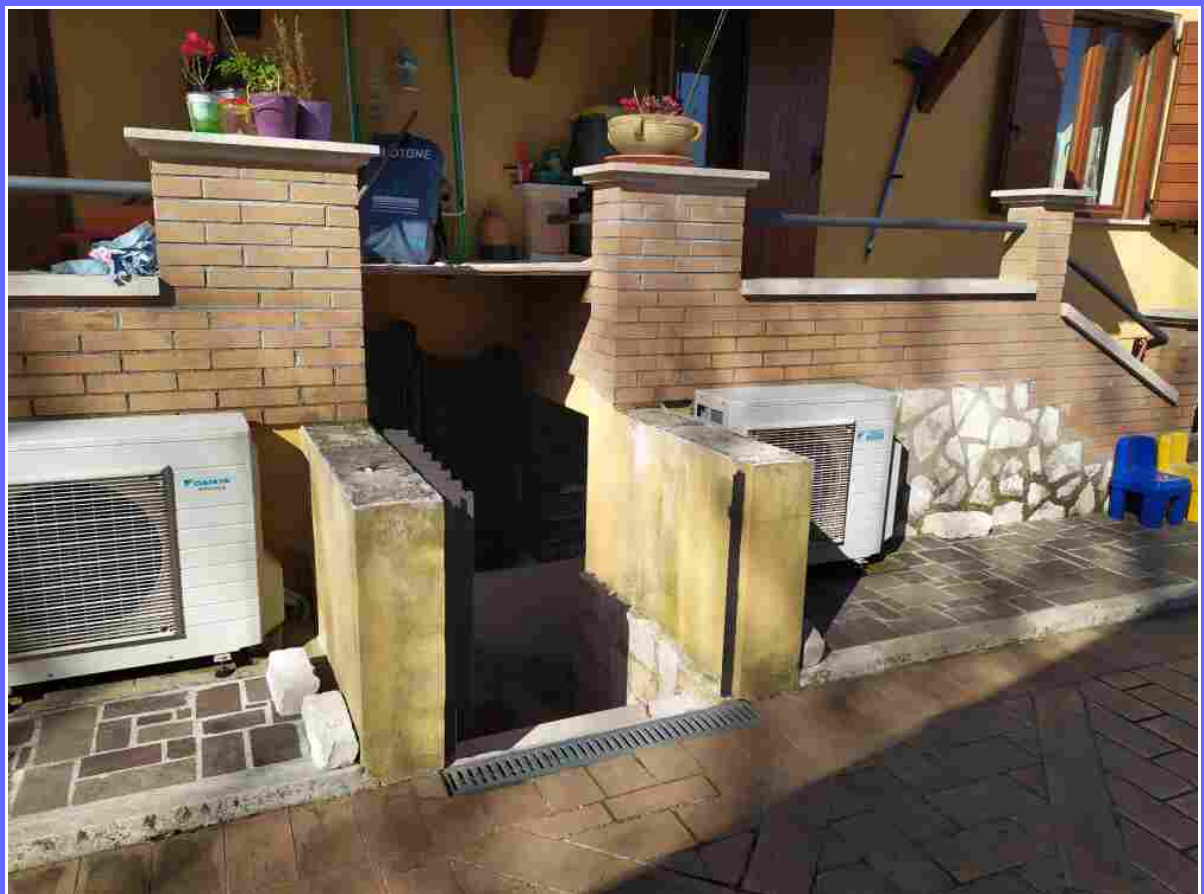
FOTO 11 - CORTILE INTERNO - ACCESSO CANTINA
