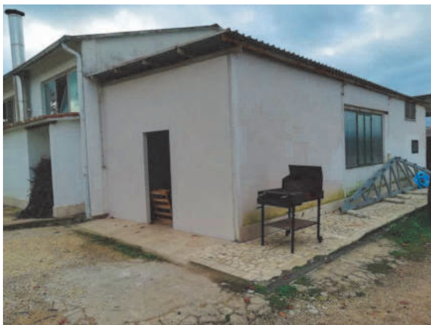
Foto 4 – Vista esterna – Prospetto sud/est
