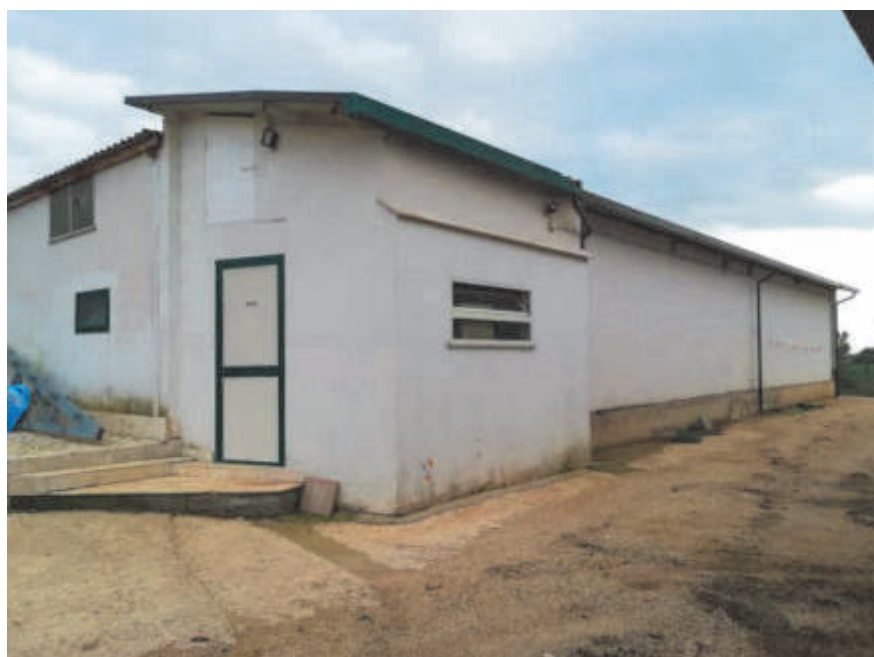
Foto 5 – Vista esterna – Prospetto nord
