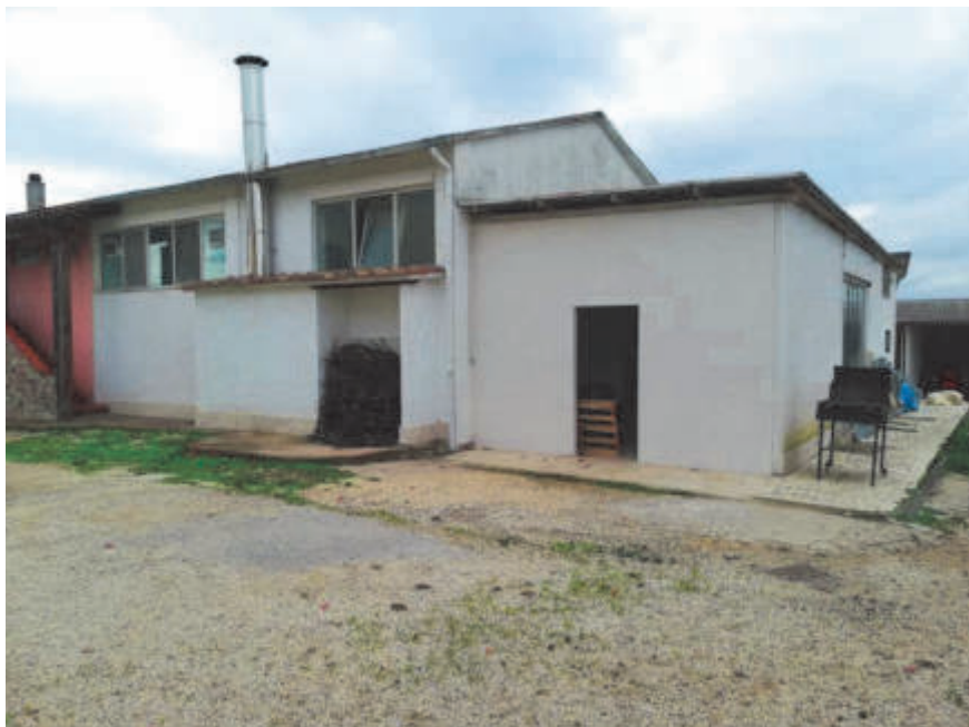
Foto 3 – Vista esterna – Prospetto sud
