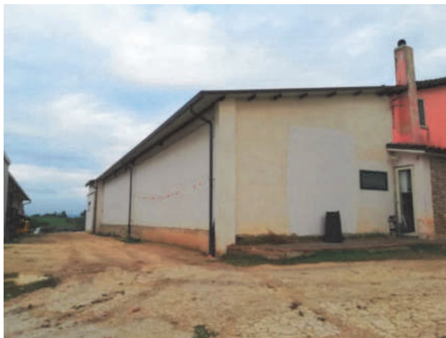
Foto 6, 7 e 8 – Vista esterna – Prospetto ovest
