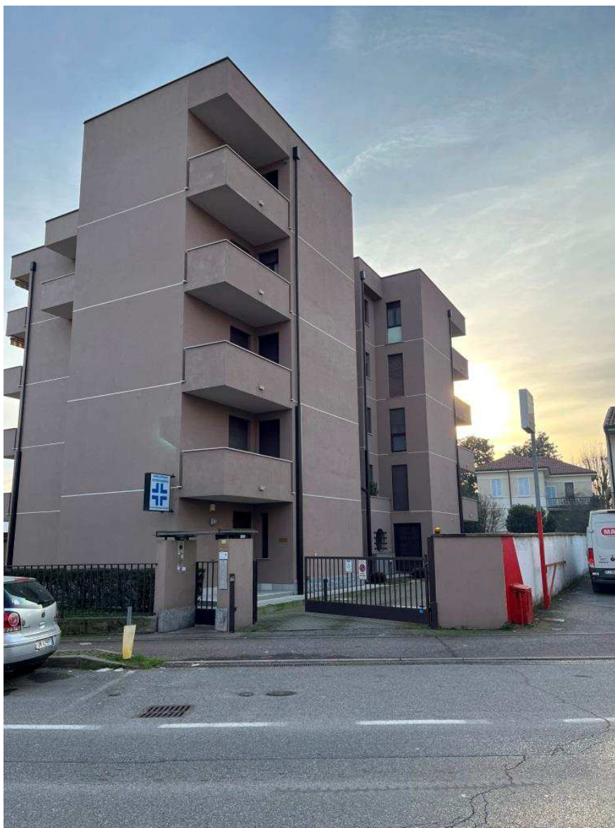
1 – esterni accesso da Viale Zara, n. 26/A
