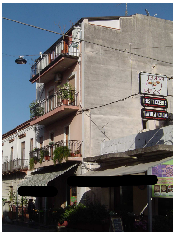
FOTO 2 – Prospetto intero edificio su via Medici lato Palermo;
