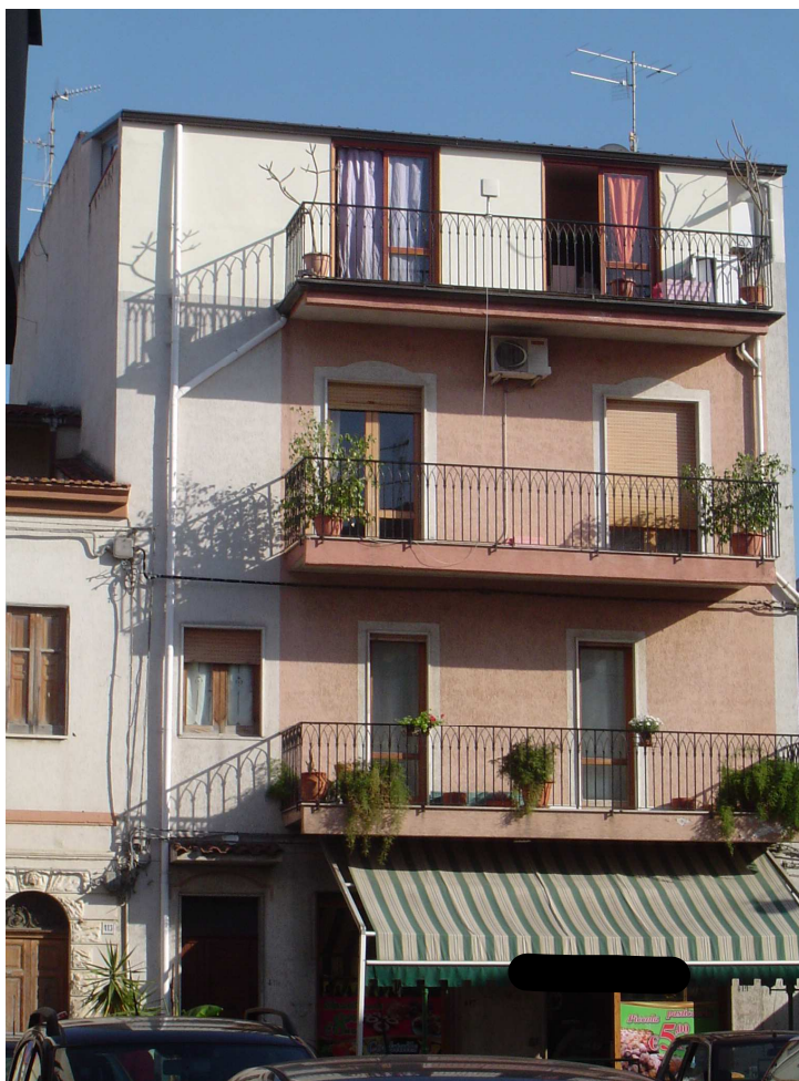
FOTO 1 – Prospetto intero edificio su via Medici;
