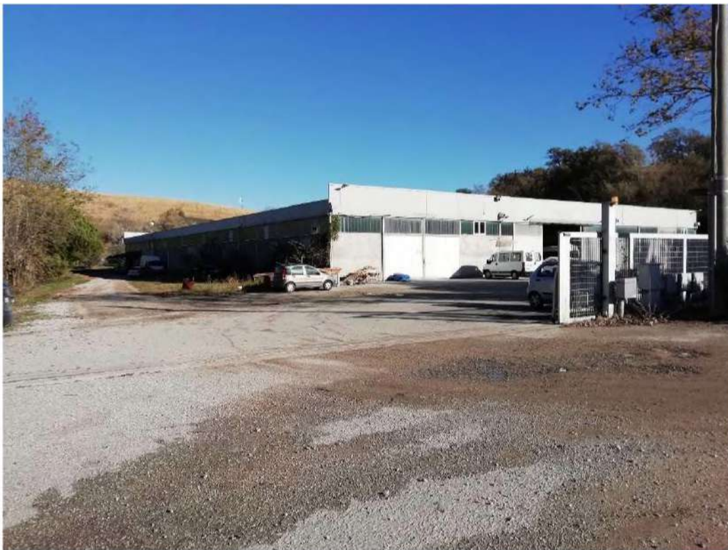
Ingresso principale all'intero fabbricato
