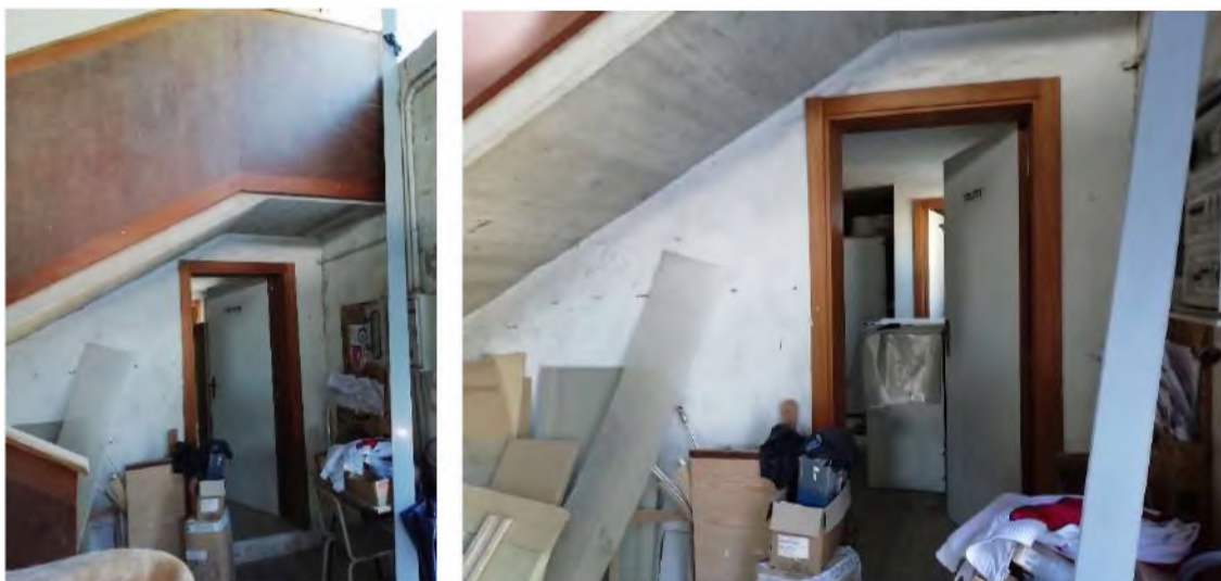
PIANO TERRA: accesso locali di servizio
