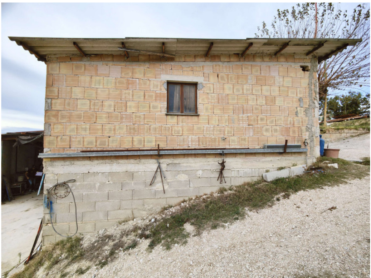
02) Deposito attrezzi - Fianco sinistro
