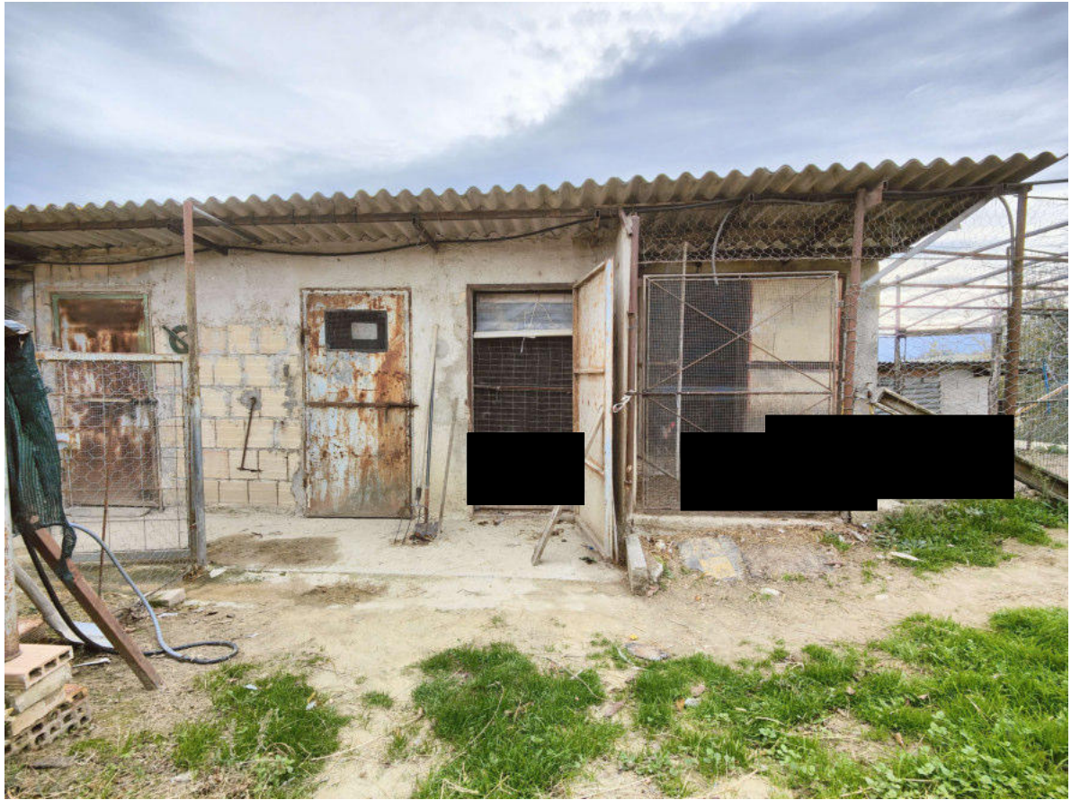
05) Ripostiglio, porcilaia e pollaio
