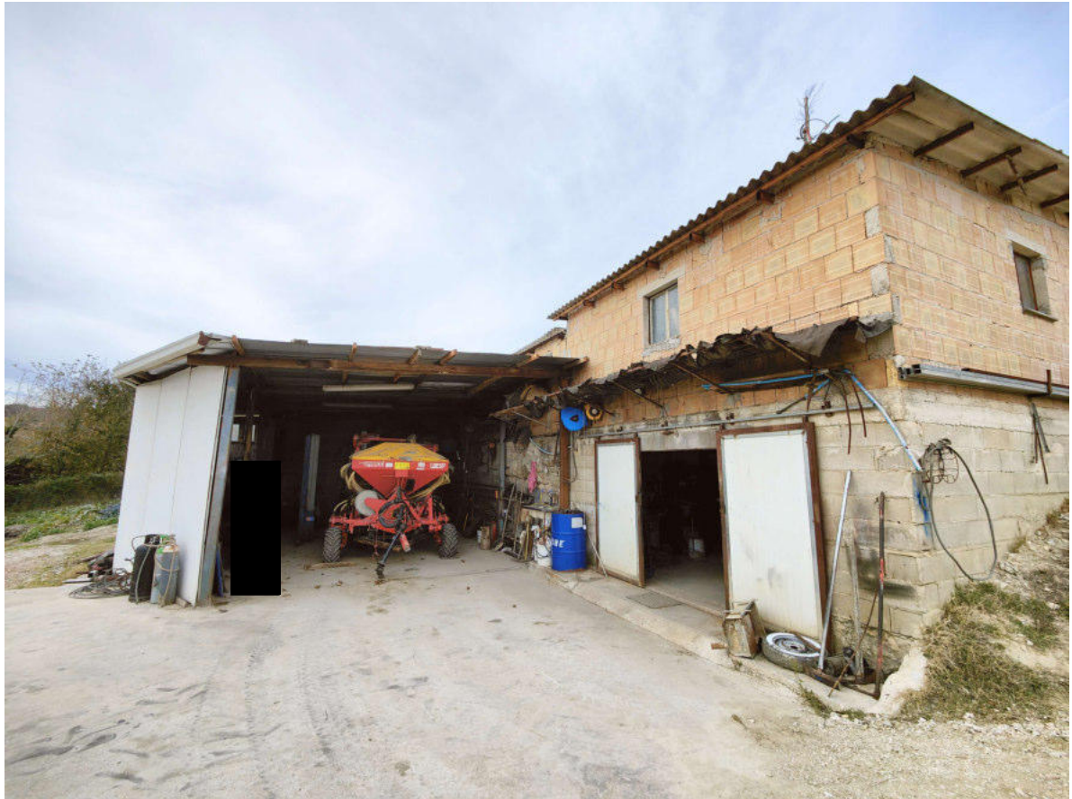
03) Deposito attrezzi - Retro e vista su struttura precaria per ricovero attrezzi
