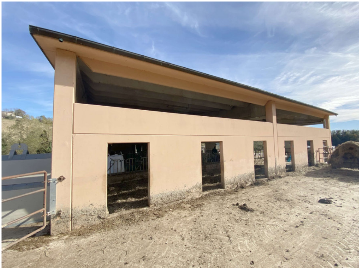
04) Stallone - Fabb. a) Dettaglio Fianco sinistro
