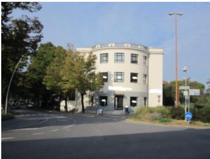
PROSPETTO FRONTE – Ingresso clienti
