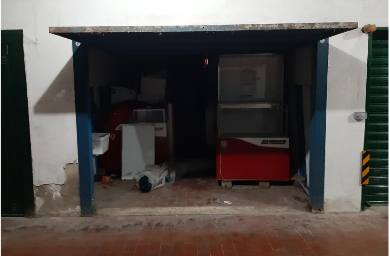
Figura 3 – Garage Piano S1 Via Domenico di Giura, n. 101, foglio 29, p.lla 1255, sub 31.
