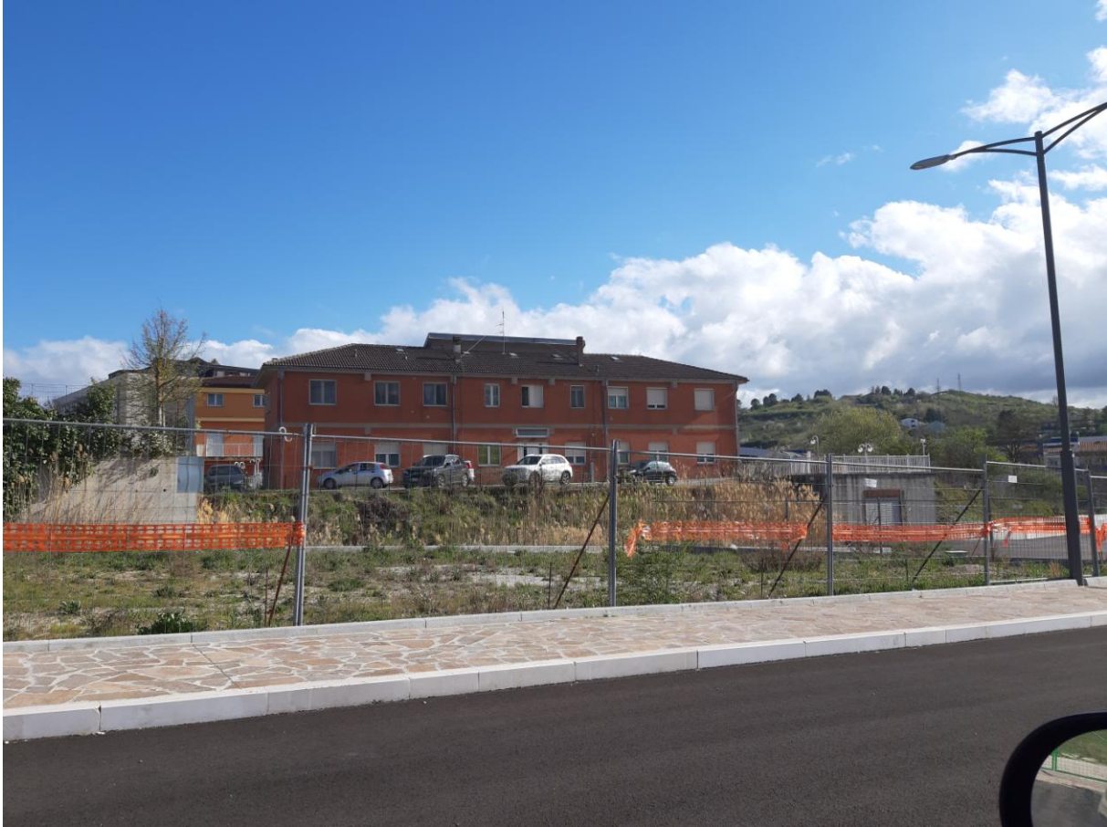
Figura 4 – Appartamento Via del Gallitello, n. 130.
