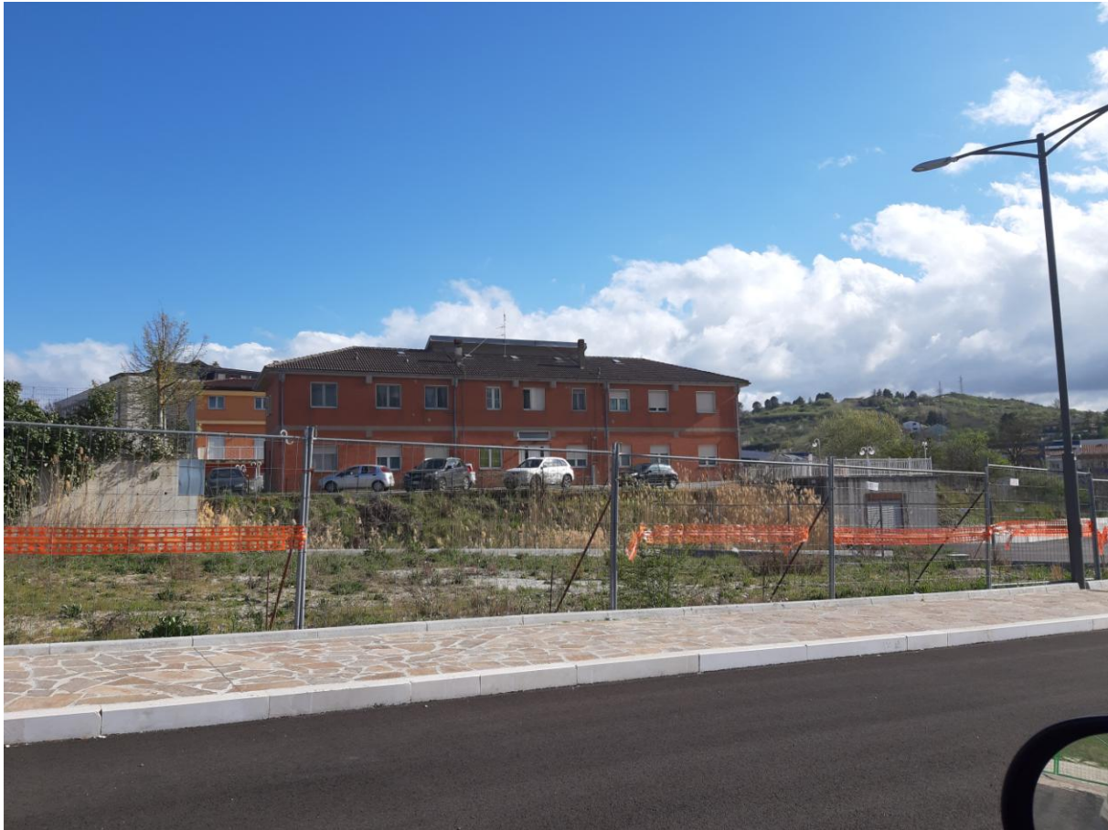
Figura 4 – Appartamento Via del Gallitello, n. 130.
