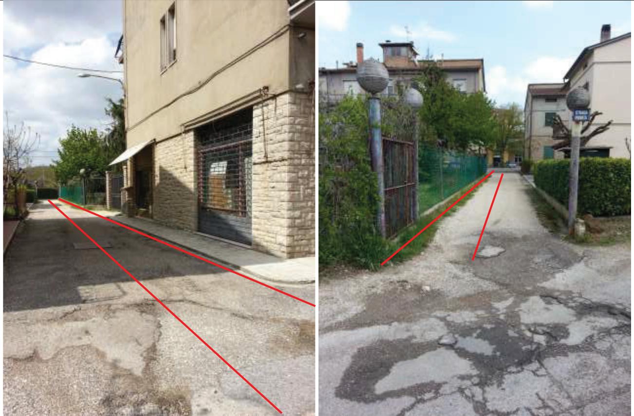
Foto 1-2 – Strada privata ad uso pubblico che delimita il confine sud dei Lotti 1-2-3. La Part. 518 corrisponde a circa metà della sede stradale (area compresa tra le righe in ROSSO). Si suggerisce la variazione catastale dal C.T. al C.F. come area urbana BCNC ai Lotti 1-2-3.
