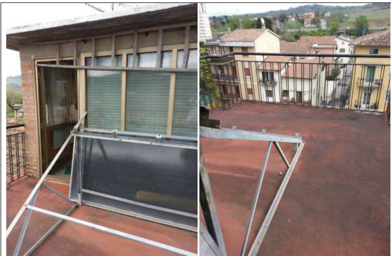
Foto 72-73 – Lastrico solare in copertura accessibile dalla torretta.
