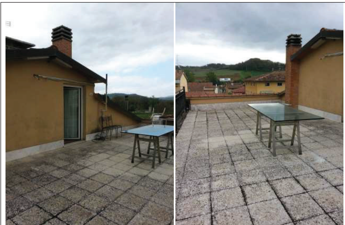
Foto 60-61 – Terrazzo (lastrico solare).
