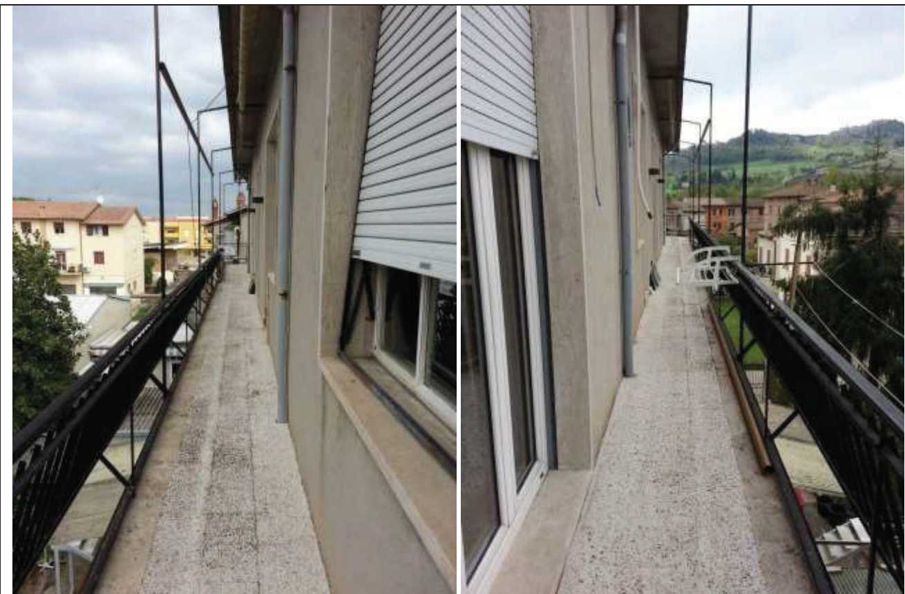
Foto 44-45 – Balcone sul retro della palazzina.
