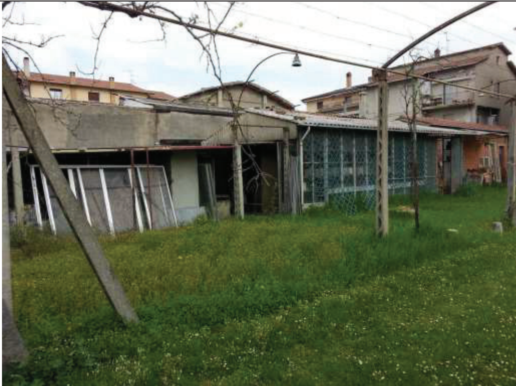
Foto 1 – Fabbricato destinato a garage (Sub. 2) e magazzini (Sub. 3). Area esterna edificabile (Sub. 1 BCNC).
