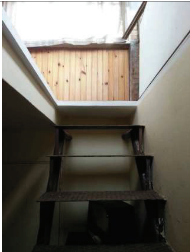
Foto 66-67 – Scala metallica di accesso alla torretta in copertura.
