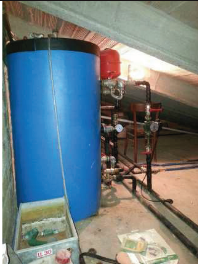
Foto 64-65 – Soffitta 3. Si osserva la cisterna di supporto all'impianto termosanitario dell'appartamento.
