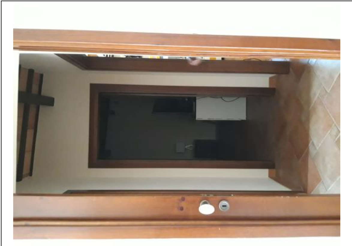
Foto 25 – Vista interna vano 12.-
