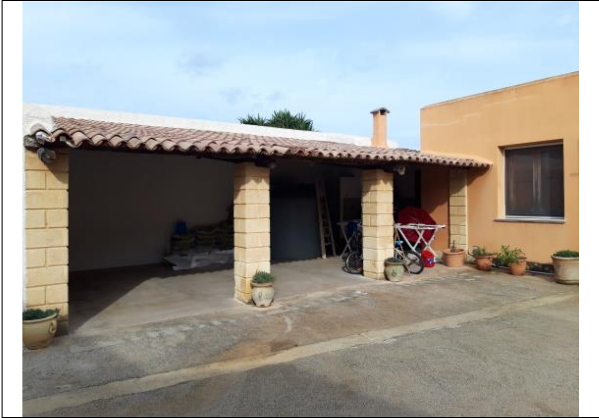
Foto 31 – Vista esterna (copertura 16).-
