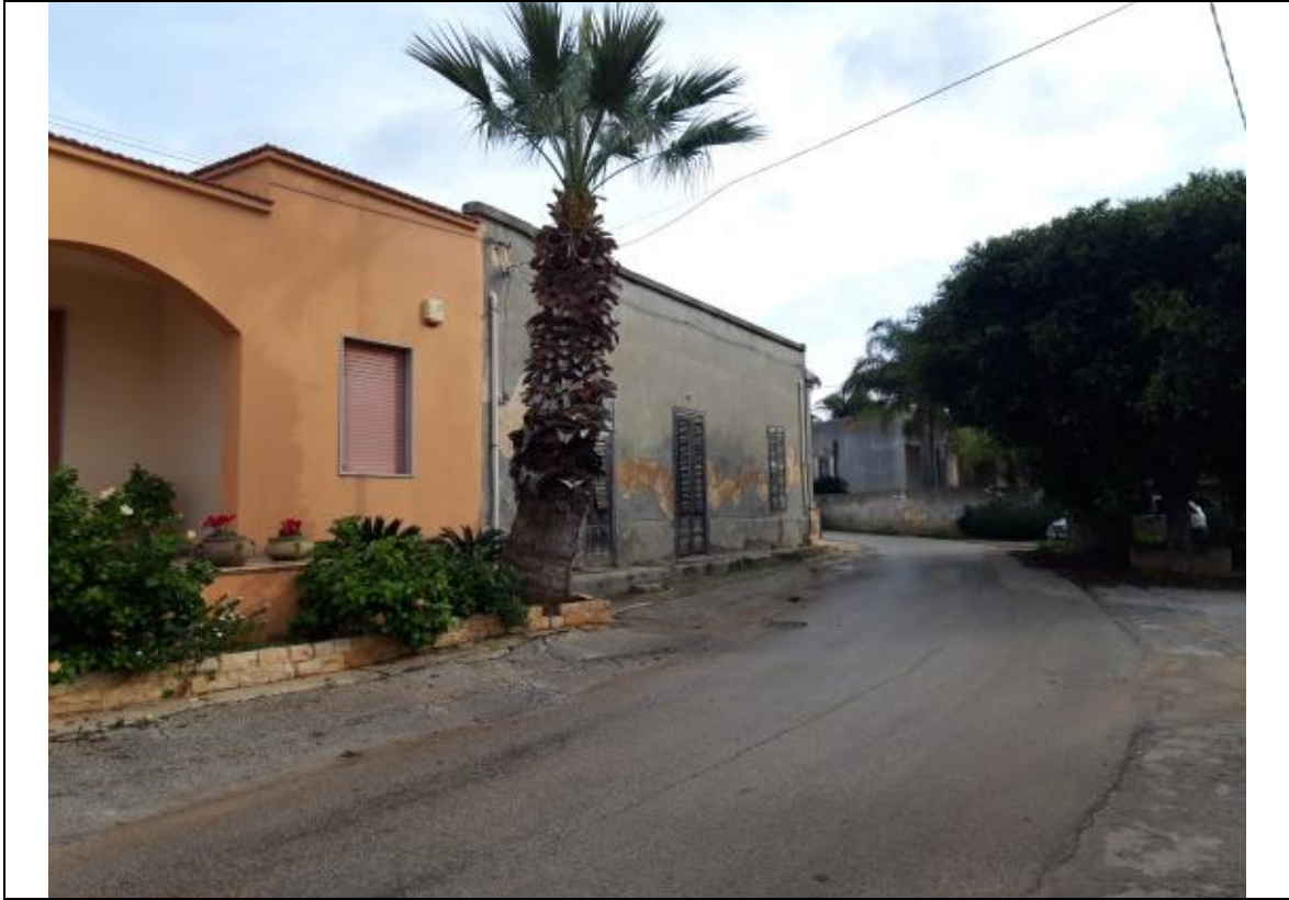
Foto 51 – Vista esterna – Prospetto principale (Fabbricato principale).-
