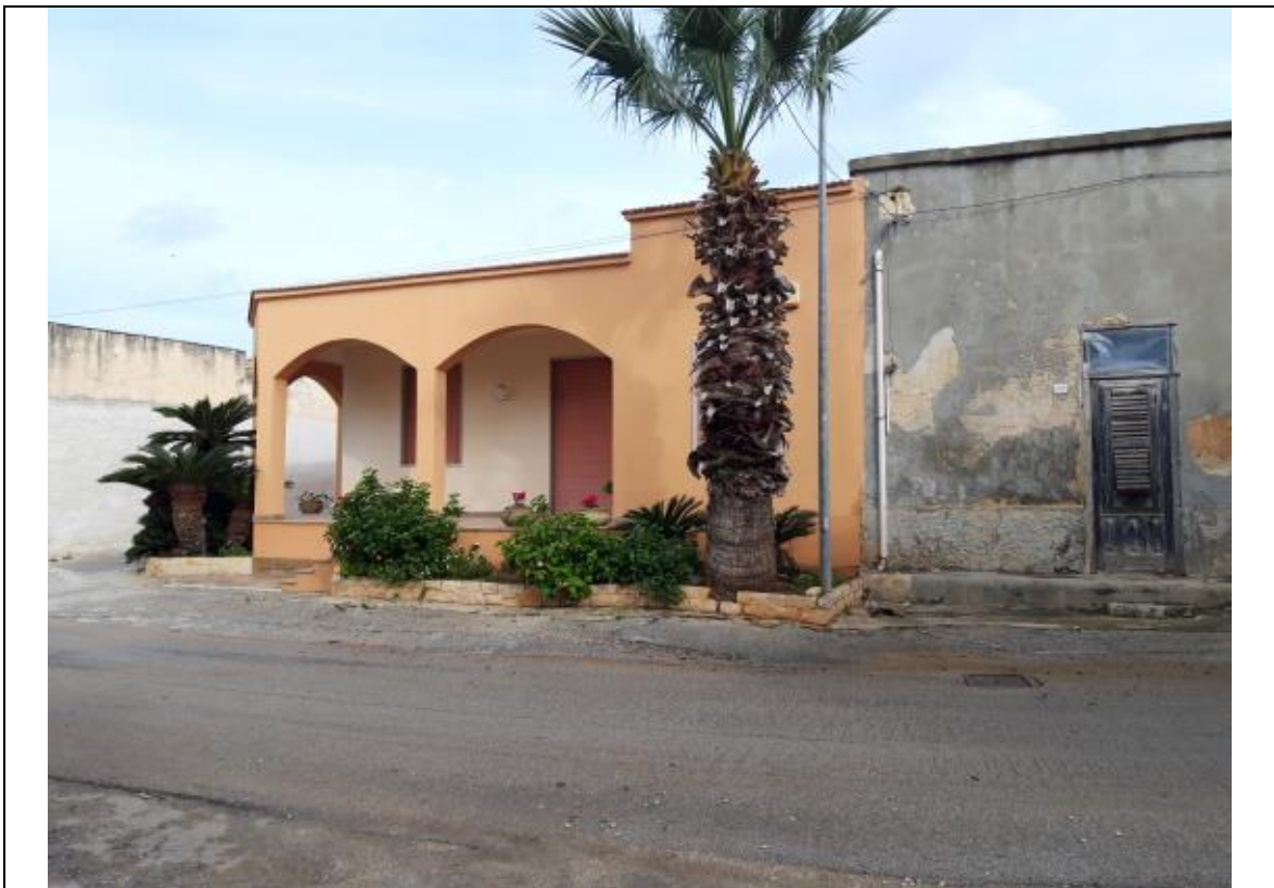
Foto 52 – Vista esterna – Prospetto principale (Fabbricato principale).-
