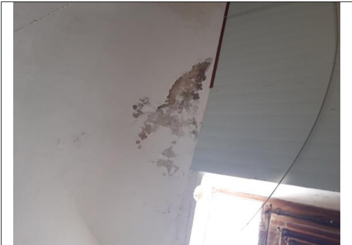
Foto 08 – Vista interna vano 3.-
