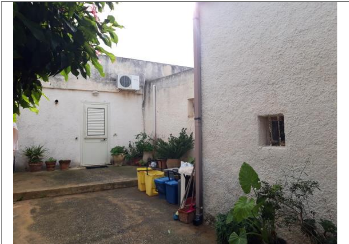
Foto 48 – Vista esterna – Retrospetto (Fabbricato principale – porzione non ristrutturata).-
