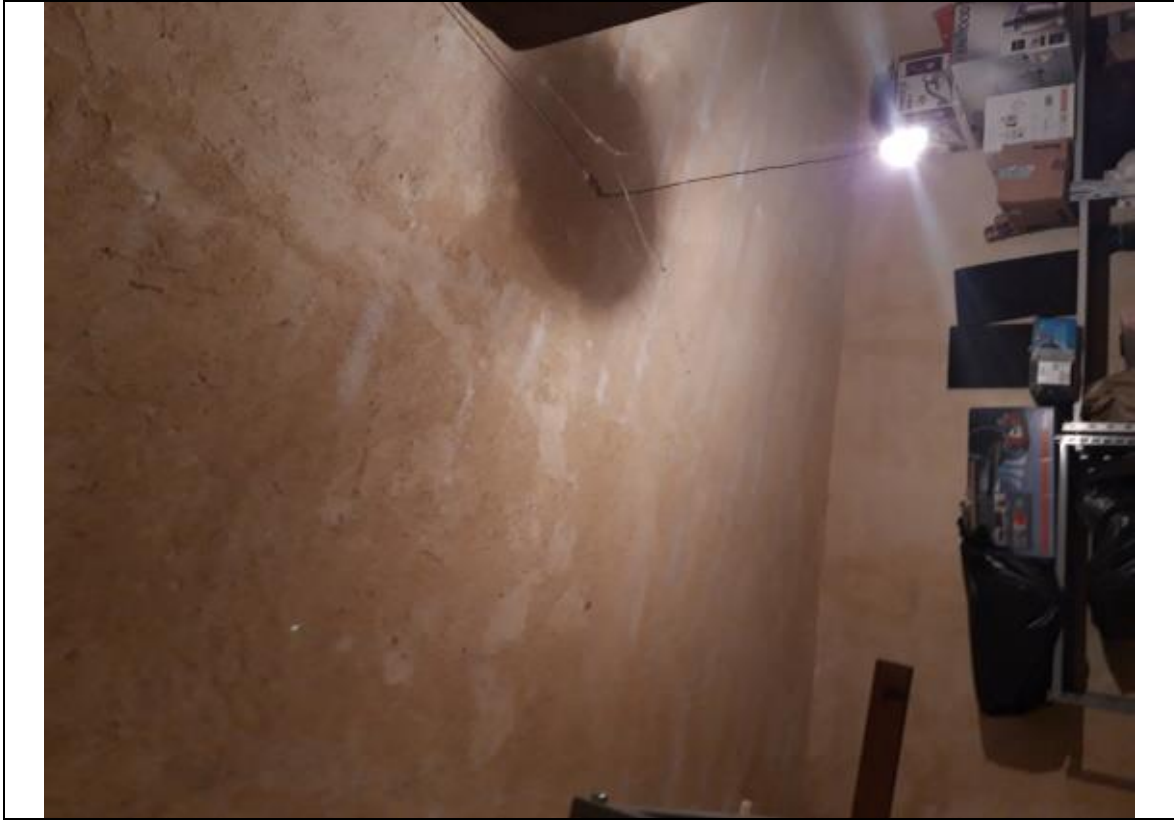
Foto 17 – Vista interna vano 7.-
