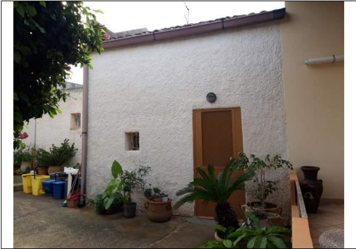
Foto 47 – Vista esterna – Retrospetto (Fabbricato principale – porzione non ristrutturata).-
