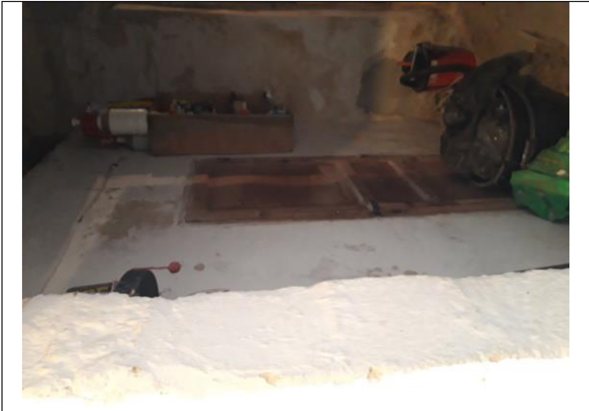
Foto 15 – Vista interna vano 6.-
