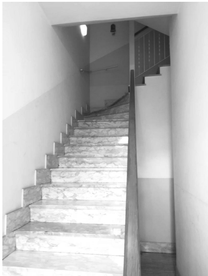
Scala d'ingresso Via Piagge foglio 12 part.750 sub 3-4
