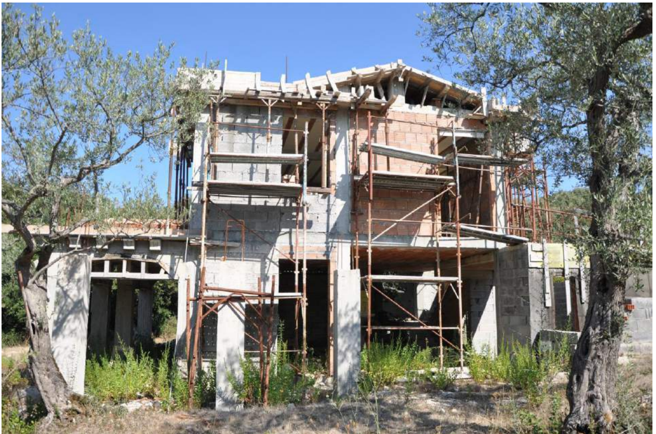
fabbricato in corso di costruzione foglio 141 mappale 281
