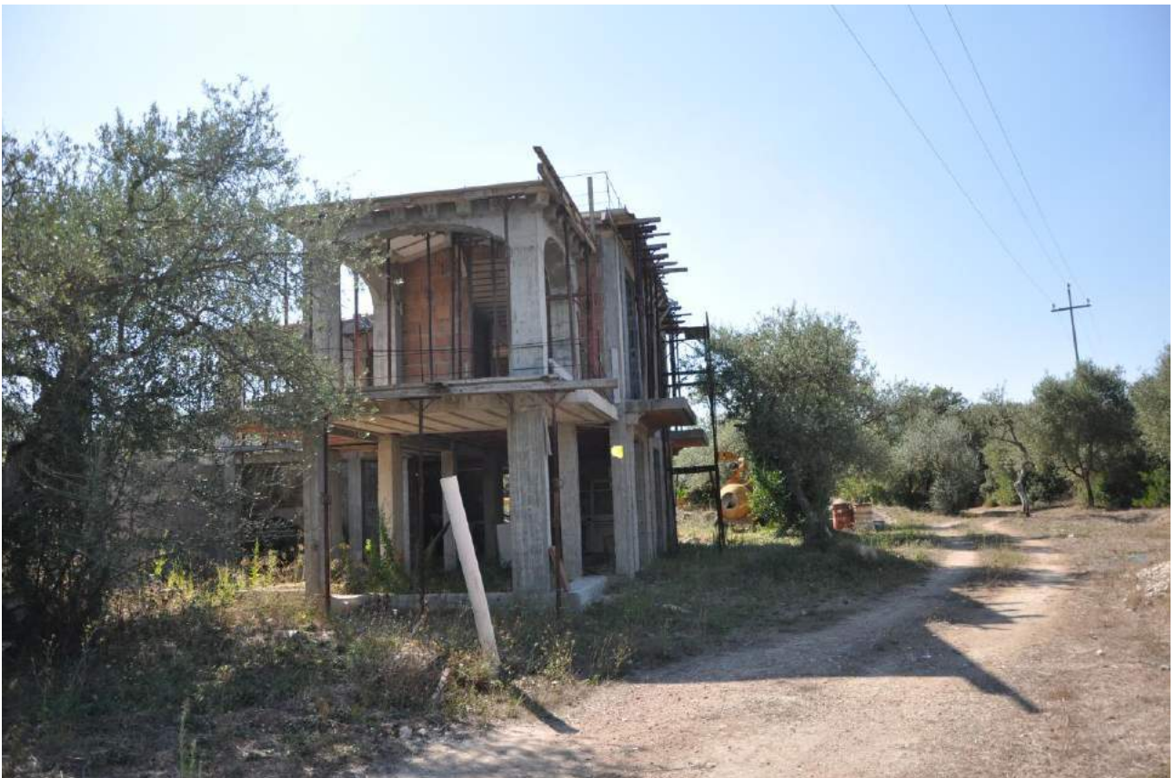
fabbricato in corso di costruzione foglio 141 mappale 438
