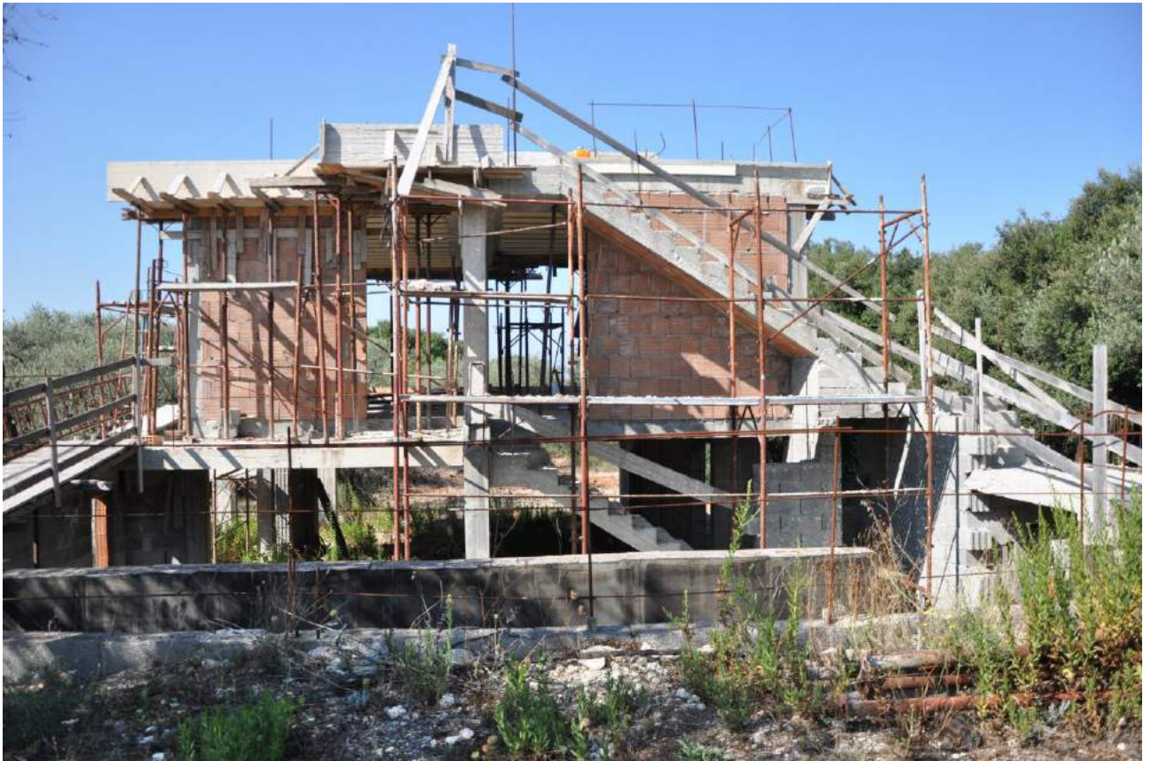
fabbricato in corso di costruzione foglio 141 mappale 281
