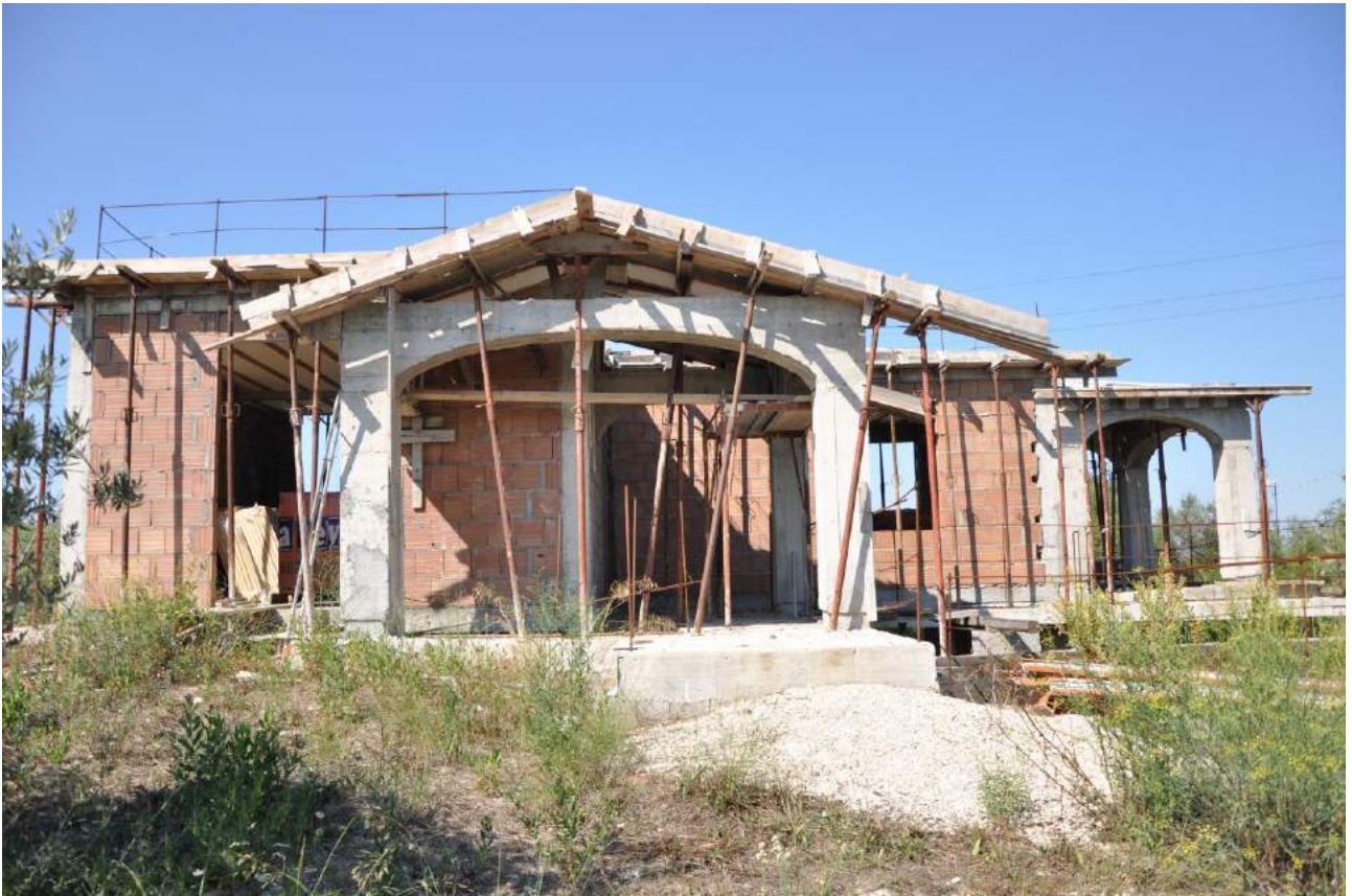
fabbricato in corso di costruzione foglio 141 mappale 438
