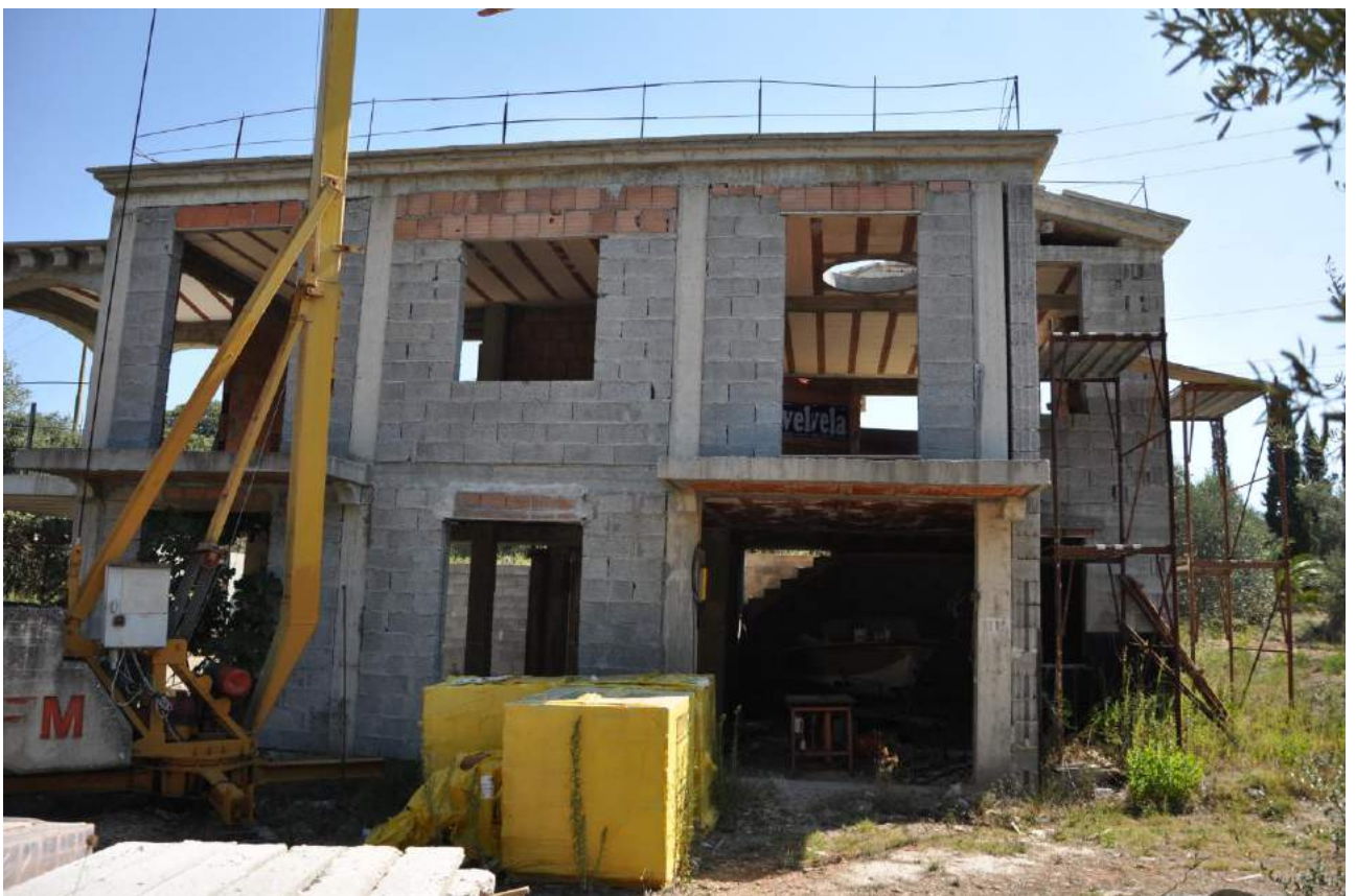
fabbricato in corso di costruzione foglio 141 mappale 437
