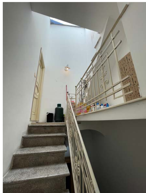
Vista del vano scala
