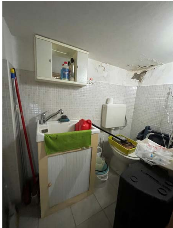
Vista del servizio igienico Wc 01 al piano ammezzato
