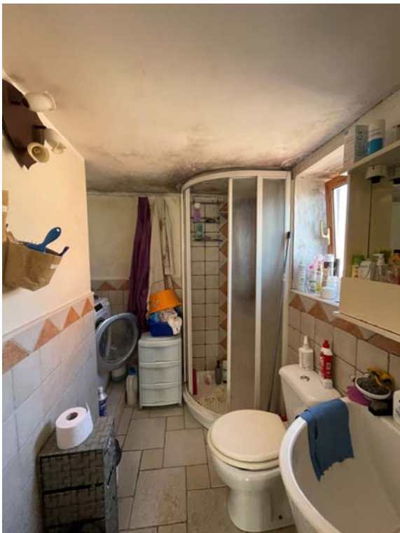
Vista del servizio igienico Wc 03 al piano secondo
