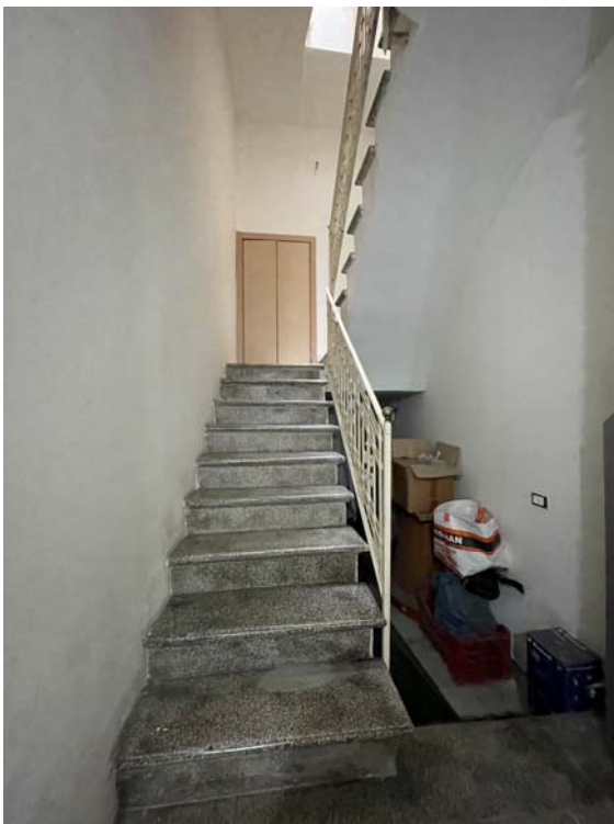
Vista del vano scala
