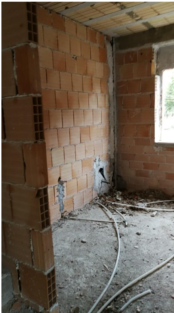
Foto 09 - Vano 02 (Piano Terra)
