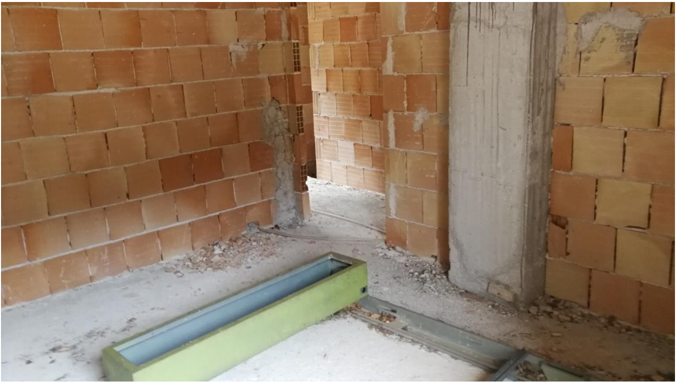
Foto 05 – Vano 05 (Piano Primo)
