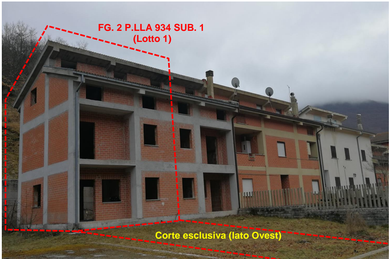
Foto 01 – Vista Esterna lato Ovest (Ingresso)
