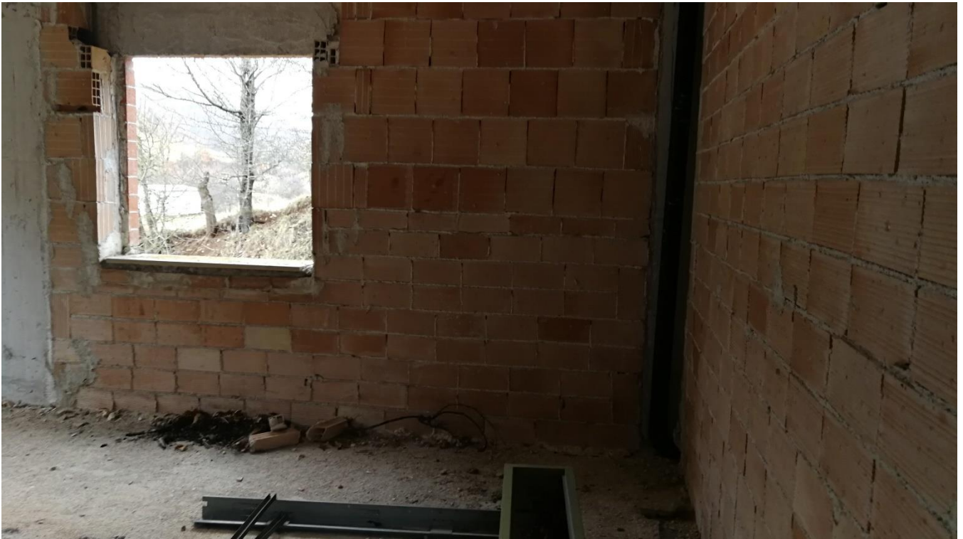
Foto 08 – Vano 01 (Piano Terra)
