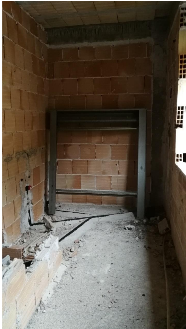
Foto 06 – Vano 04 (Piano Primo)
