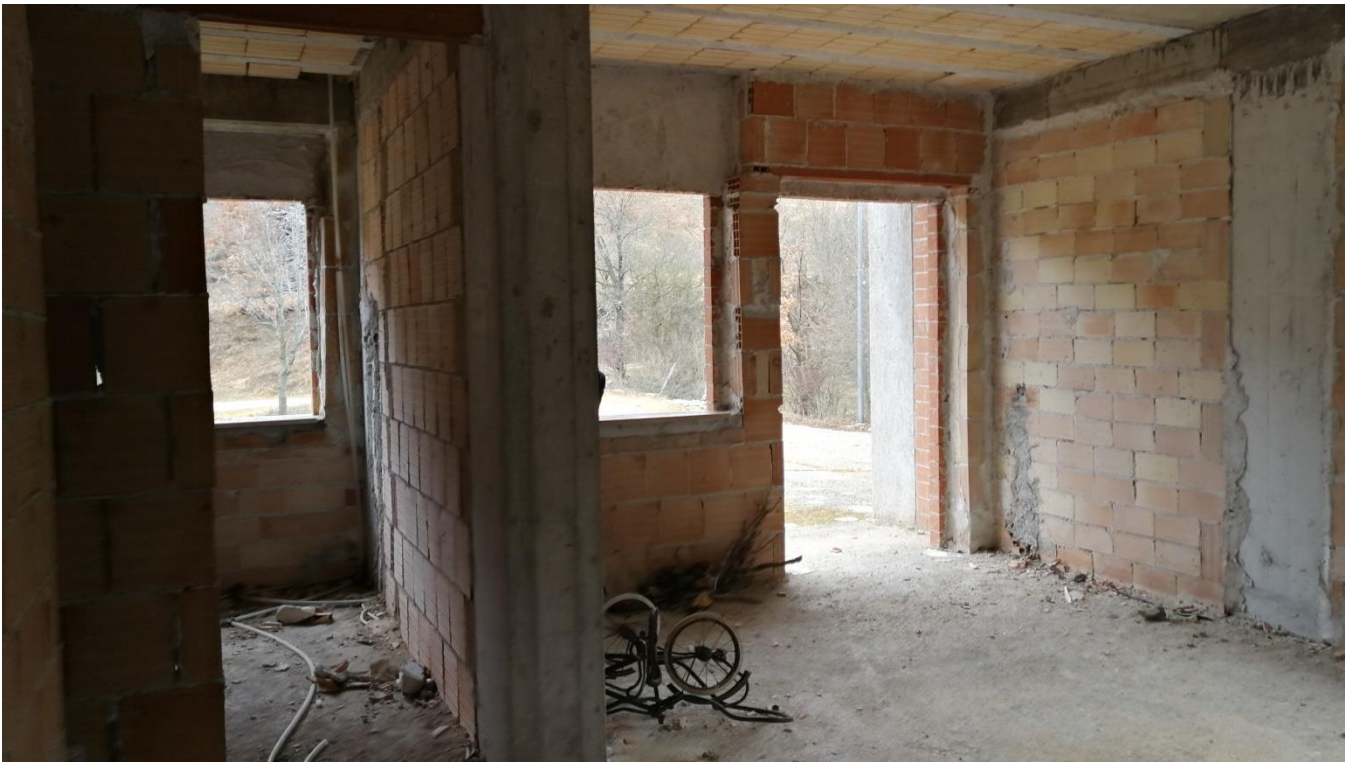
Foto 07 – Vano 01 (Piano Terra)
