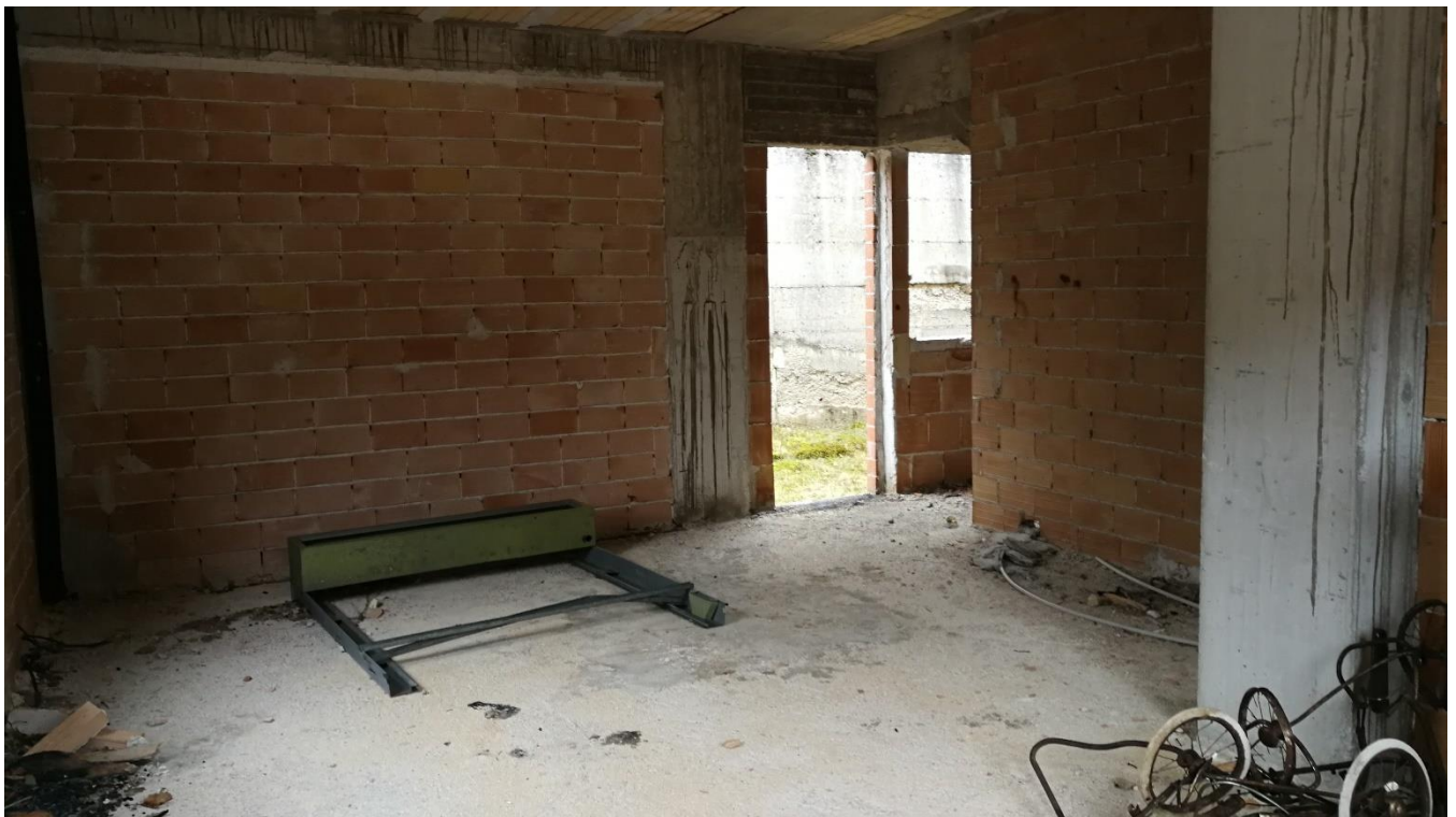
Foto 10 - Vano 01 (Piano Terra)
