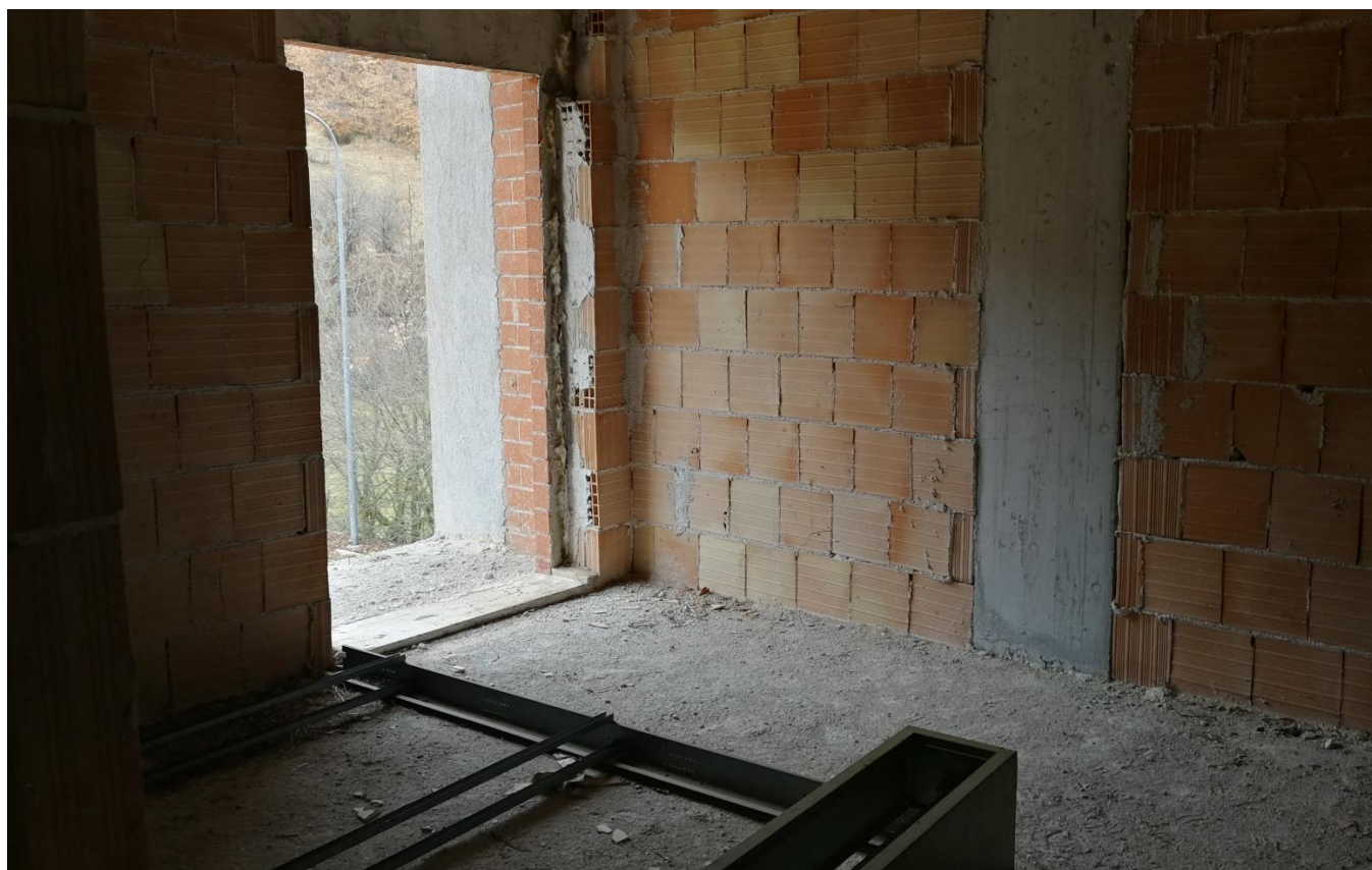
Foto 04 – Vano 05 (Piano Primo)
