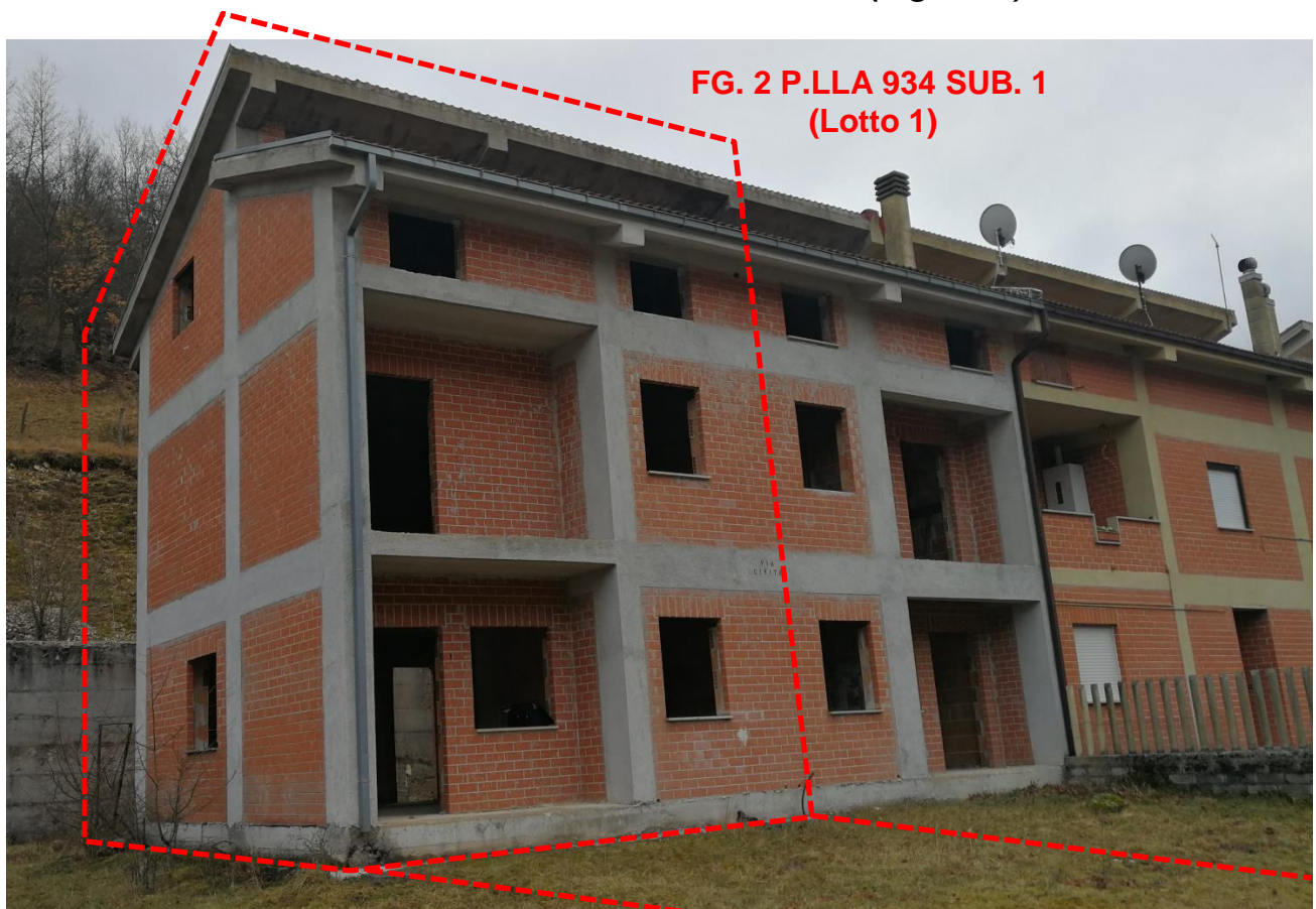
Foto 02 – Vista Esterna lato Ovest (Ingresso)
