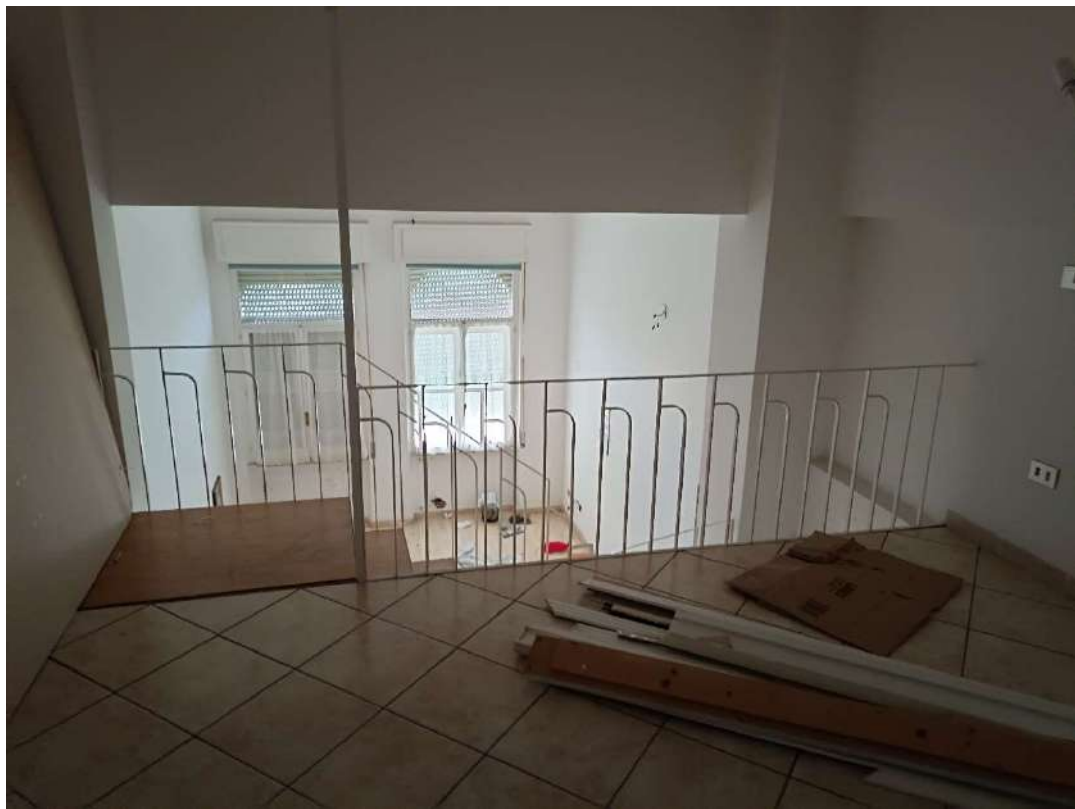
Foto n. 13 –piano ammezzato Sub 100
