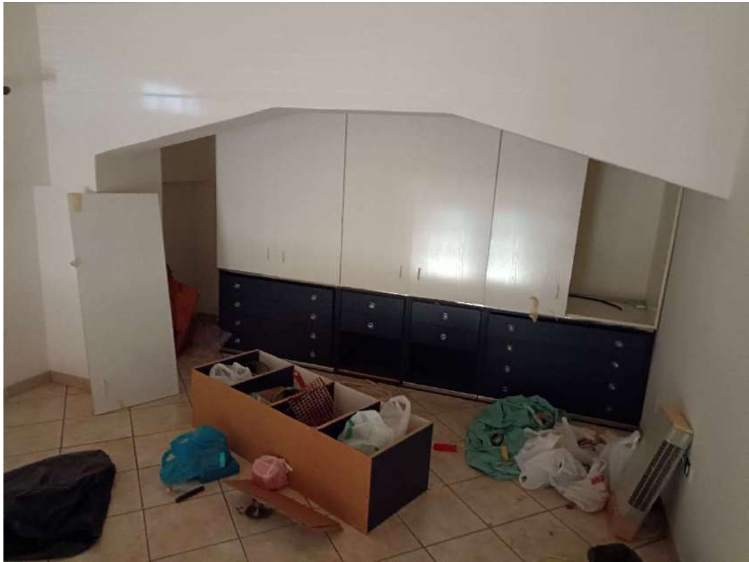
Foto n. 12 –piano ammezzato Sub 100
