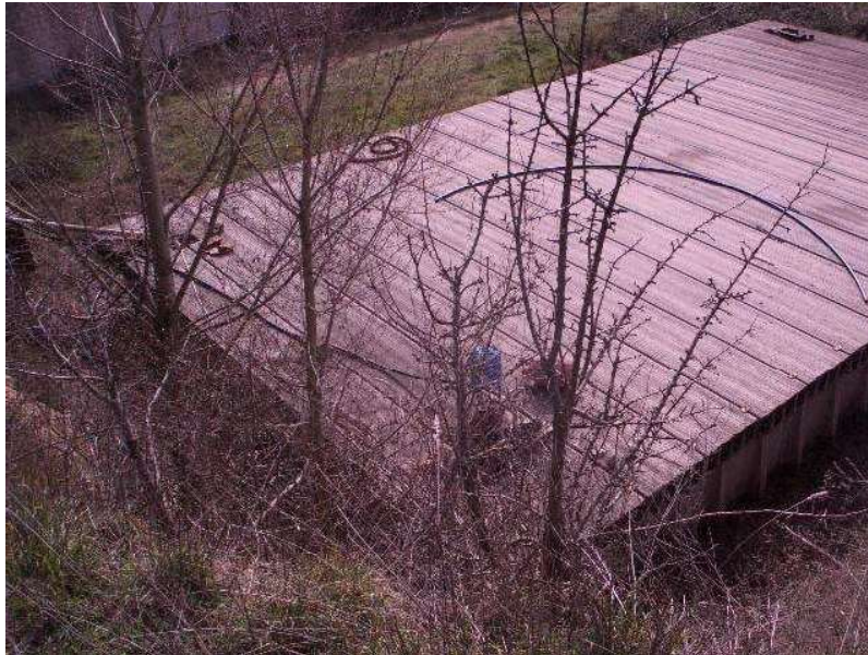
(Foto vasca irrigazione coperta)
