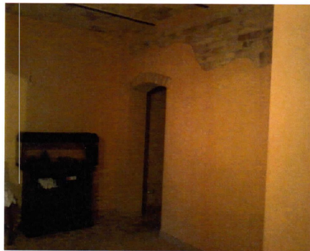
FOTO "B" Zona demolizione scala
