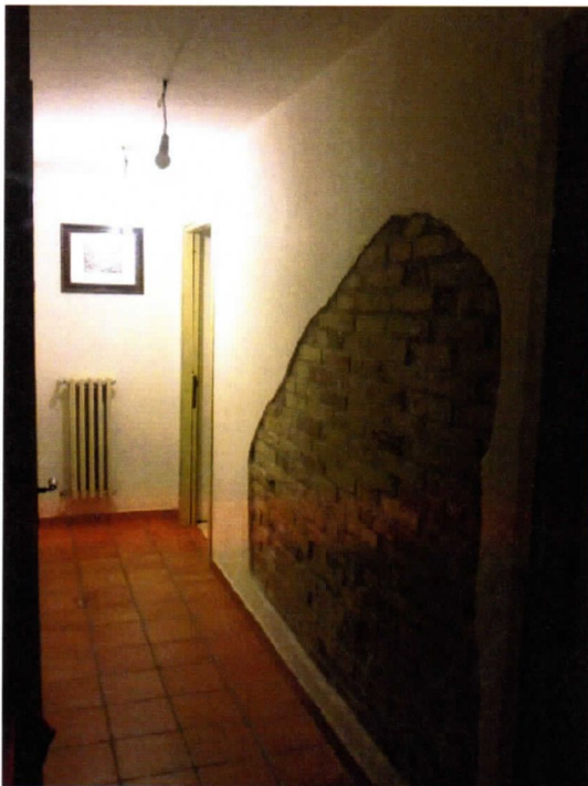
FOTO "A" Zona di demolizione scala interna
