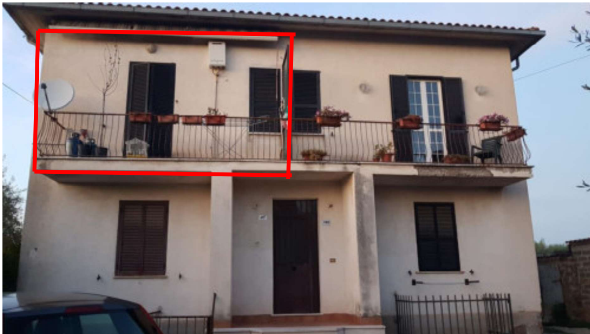
Vista 1- Prospetto Sud
