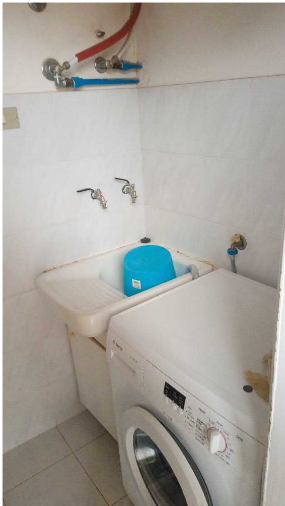
FOTO 29_WC LAVANDERIA P2
