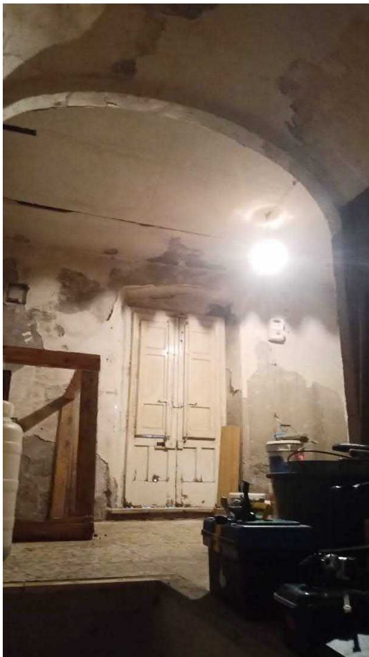
FOTO 11_LOCALE DI SGOMBRO PT
