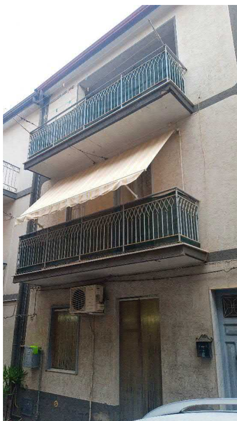
PROSPETTO VIA BARBAGALLO 12
