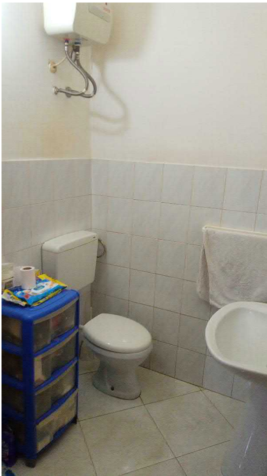
FOTO 7_WC ANNESSO ALLA CUCINA PT
