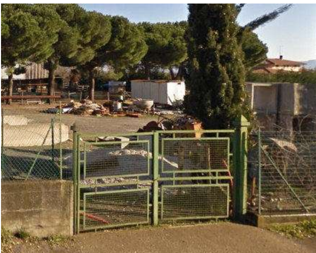
5 - Ingresso 3 da Via G. Contadini (p.lla 1217)
