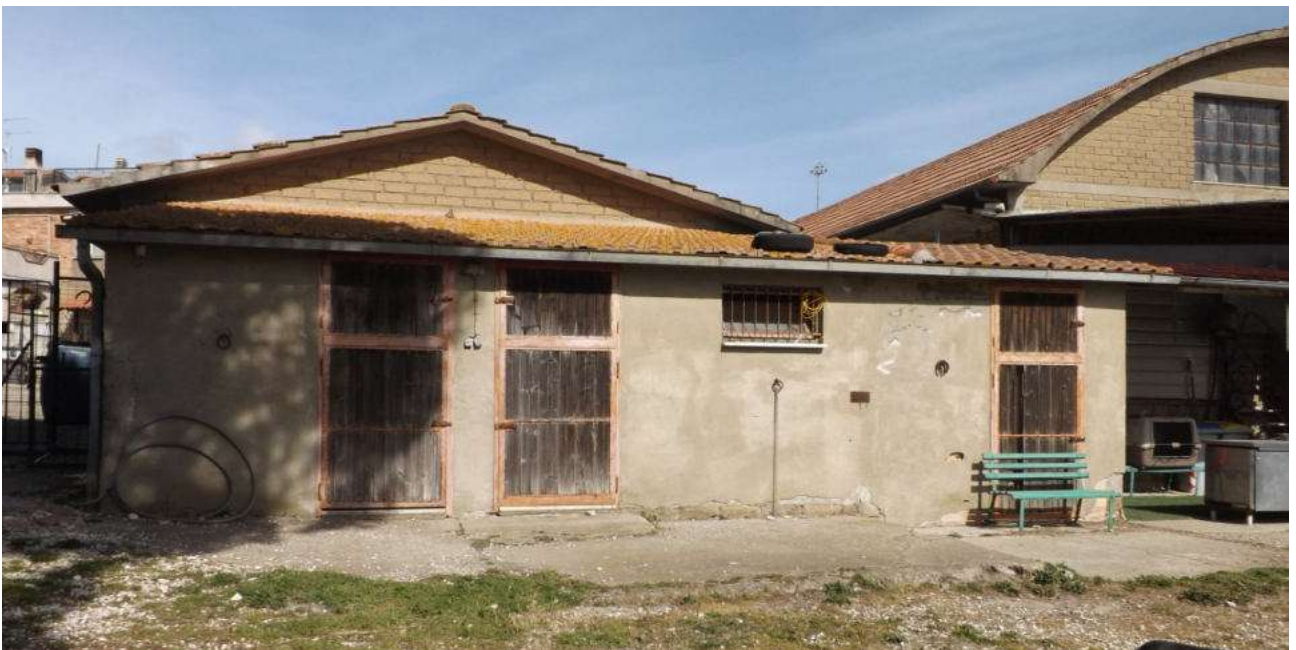
42 - Magazzino (prospetto sud)
