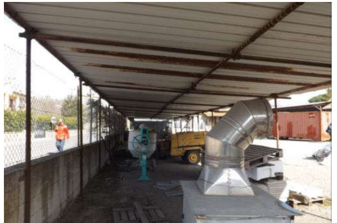
58 - Tettoia p.lla 715 su Via G. Contadini
