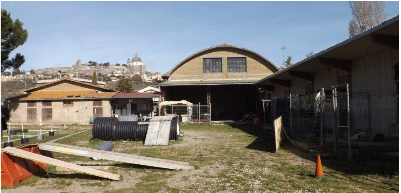
34 - Vista dalla p.lla 16 sulla 174 del magazzino (prospetto sud), della tetteria, del fienile e della selleria.
