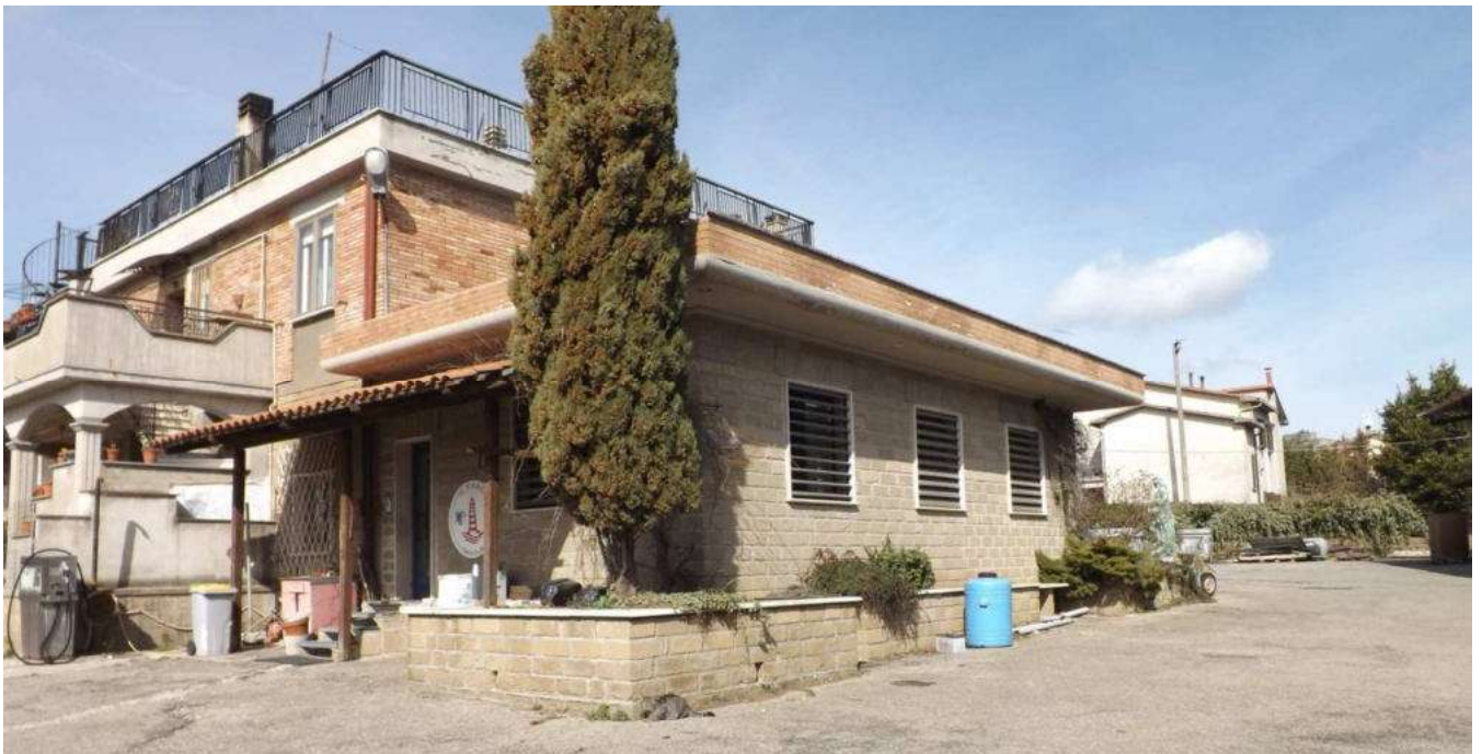
9 - Prospetti est e sud del fabbricato pignorato con vista sul piazzale (p.lla 596)
