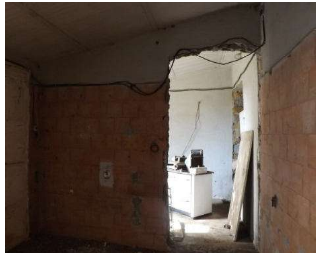
47 - Locale di maggiore superficie (collegamento con quello di minore superficie)
