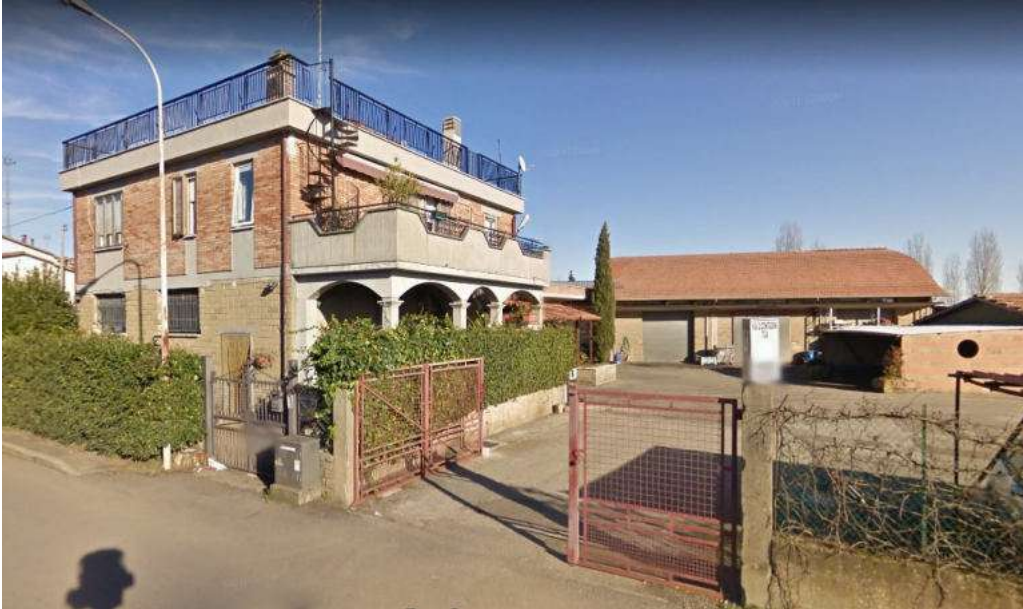
3 - Vista dell'ingresso 2 da Via G. Contadini
