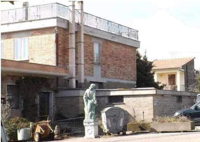
7 - Prospetto nord fabbricato uffici
