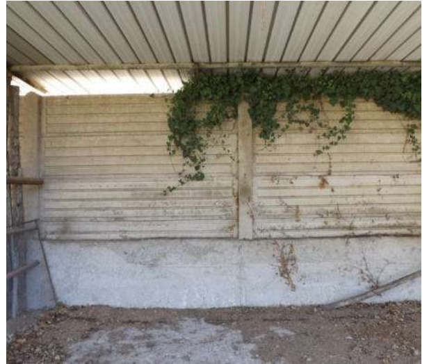
40 - Muro di confine su cui poggia la tettoia
