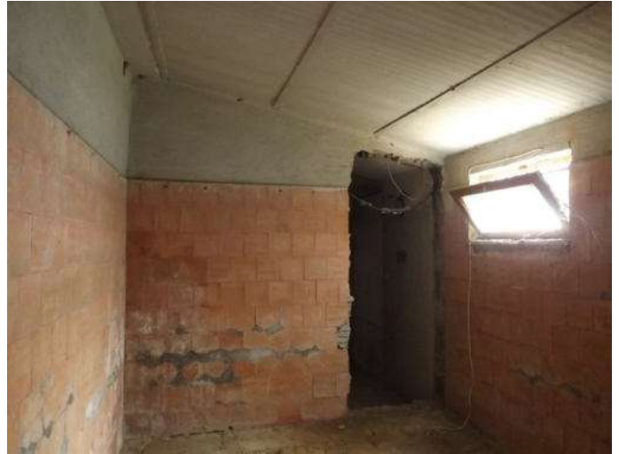
49 - Vista verso il corridoio
