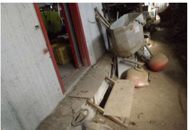
76 - Collegamento tra i due corpi di fabbrica
