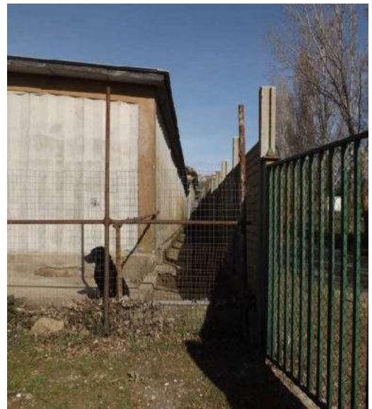
33 - Vista sul confine con strada Pennacchietto
