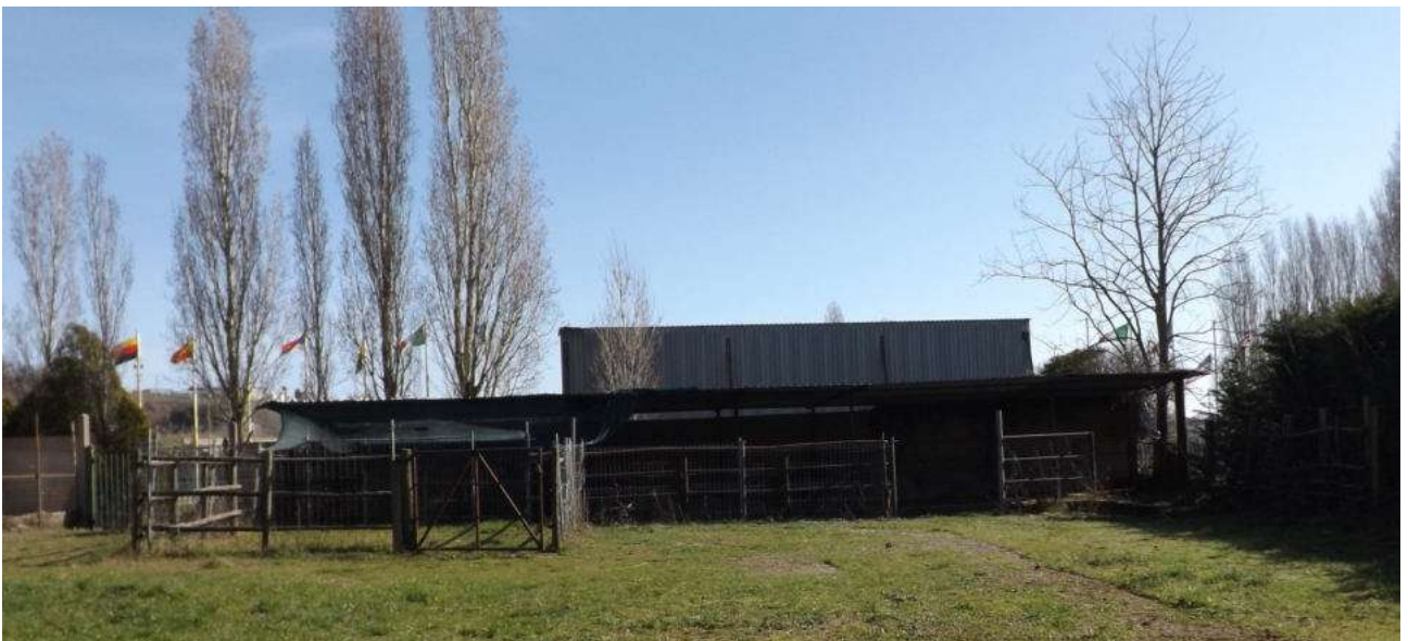
38 - Tettoia lungo il confine con strada del Pennacchietto
