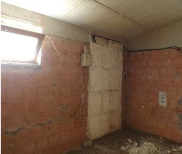
48 - Vista interna dell'ingresso tamponato
