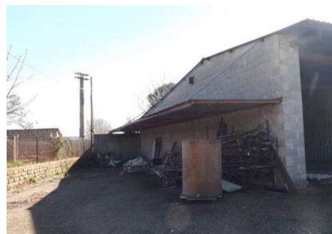
69 - Tettoia sul confine nord del portico dell'officina
