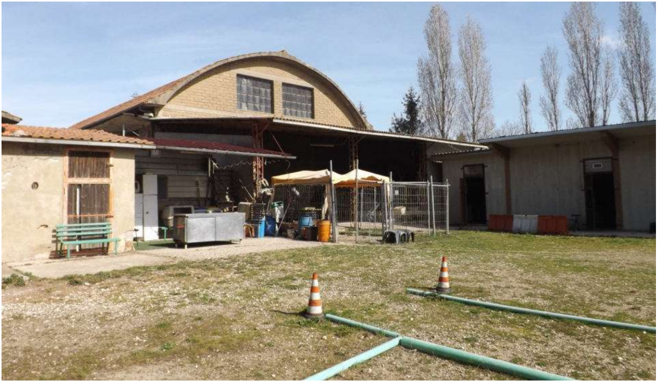
43 - Vista della tetteria adiacente alla particella 714, del fienile e quindi sull'altro lato della scuderia
