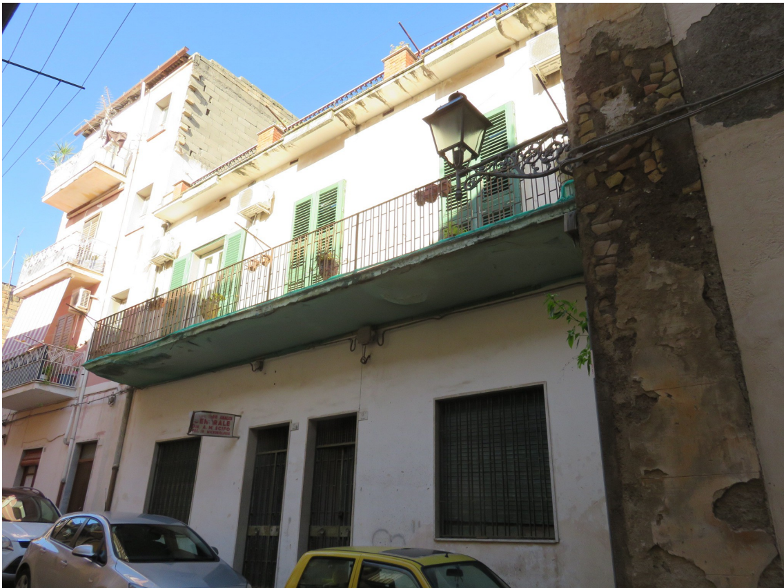
Foto 5 - Prospetto via Nave
