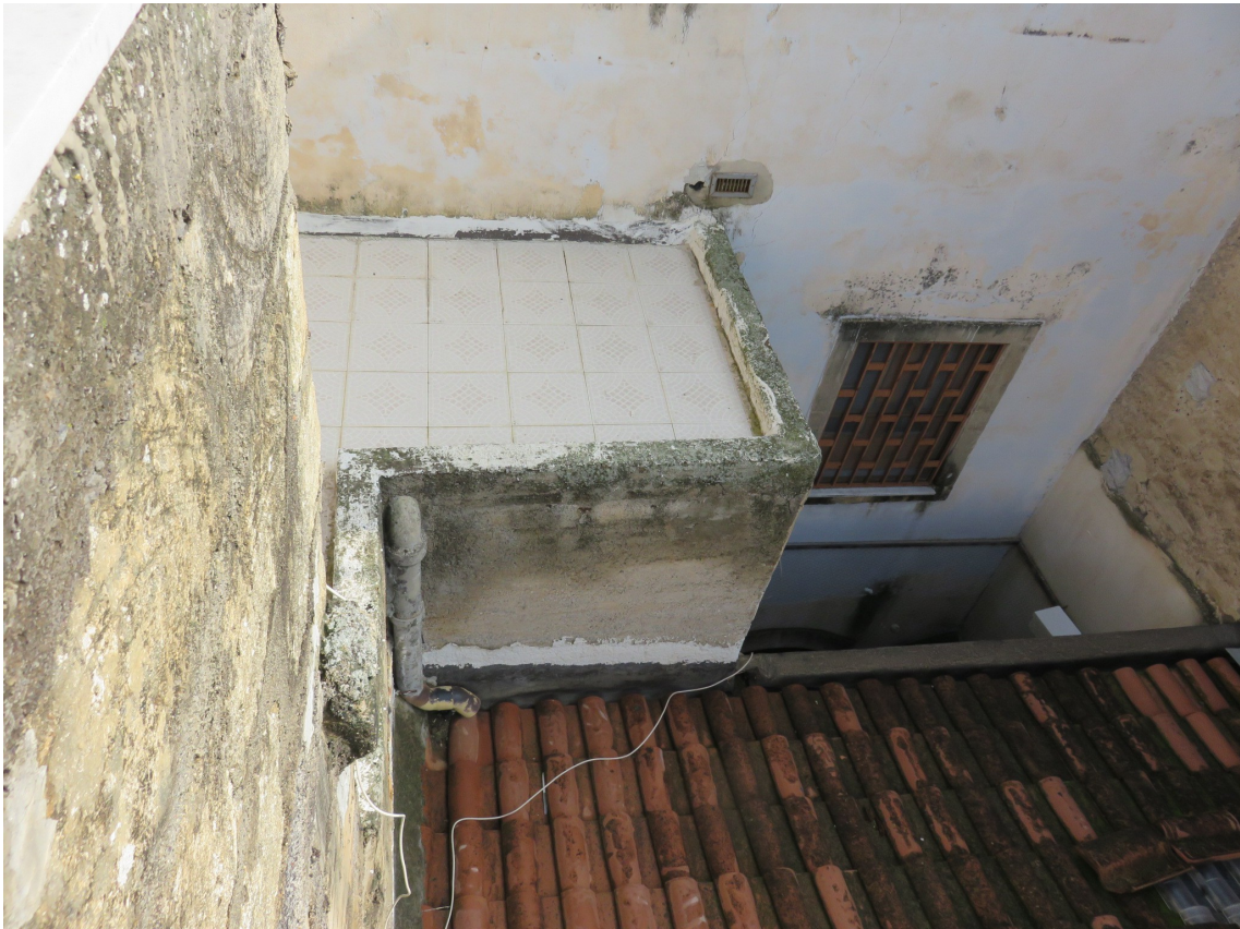
Foto 47 - Vista dal terrazzo 2° piano, Particolare
