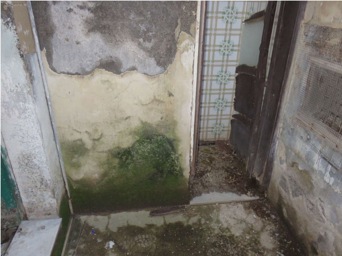
Foto 11 - Laboratorio Artigianale a p.t. Particolare cortiletto interno
