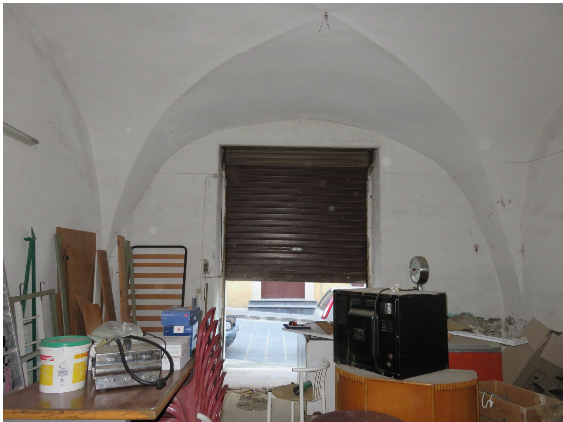
Foto 8 - Laboratorio Artigianale a piano terra
