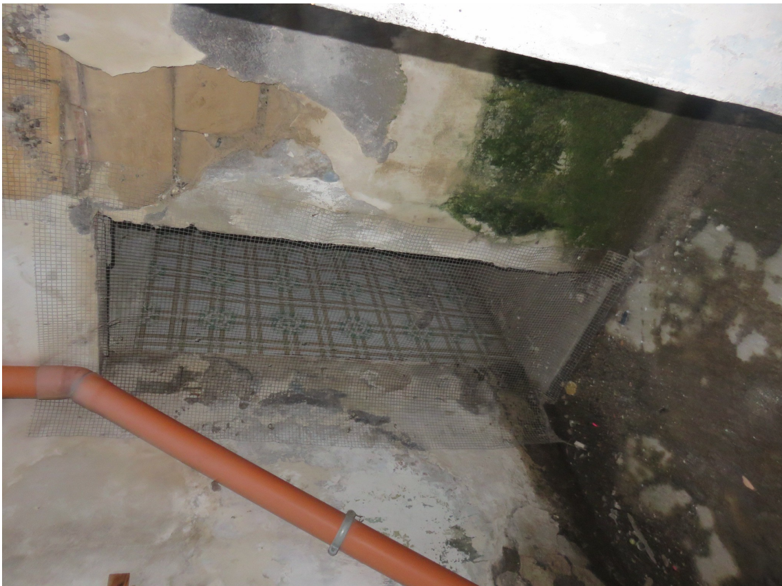
Foto 10 - Laboratorio Artigianale a p.t. Particolare cortiletto interno
