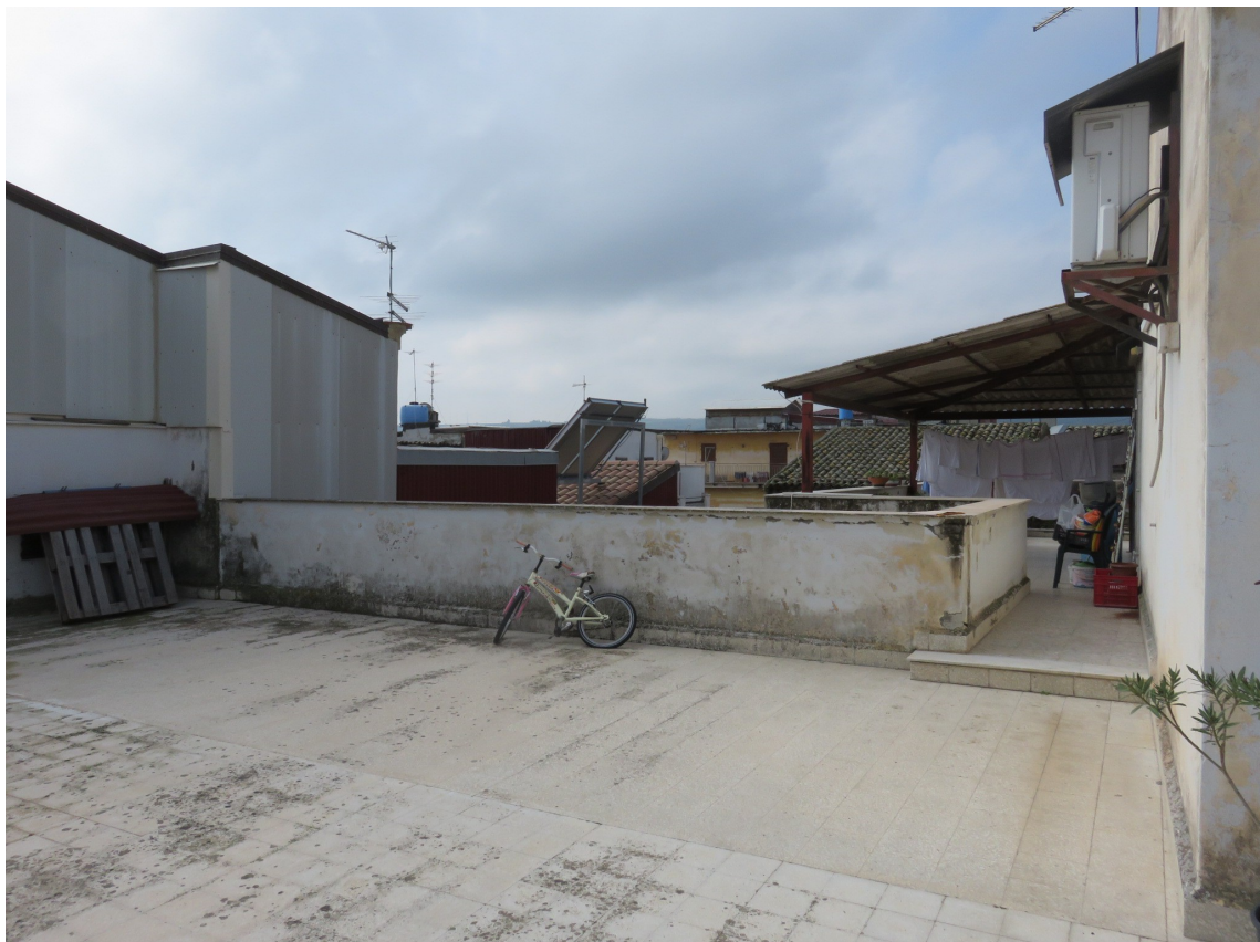
Foto 40 - Terrazzo e tettoia 2° piano
