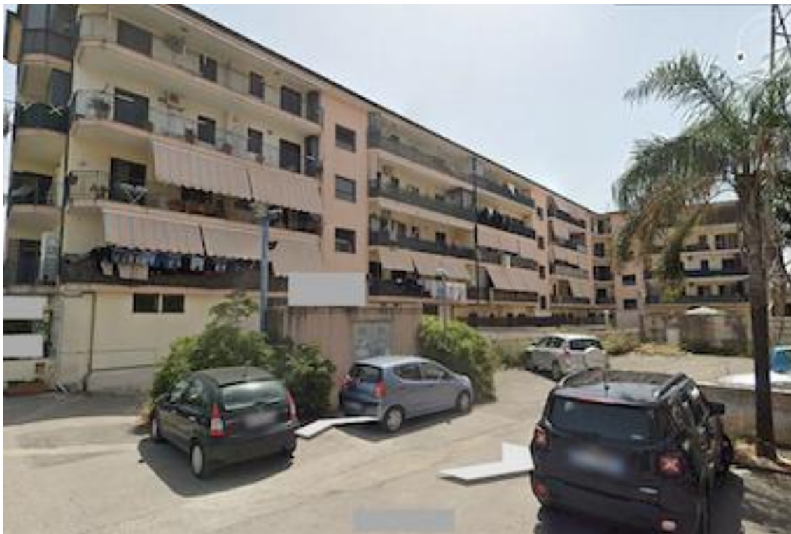
Foto n.1 – Panoramica fabbricato C dal cortile interno
