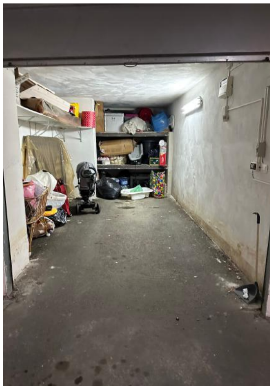
Foto n.2 – particolare box auto
