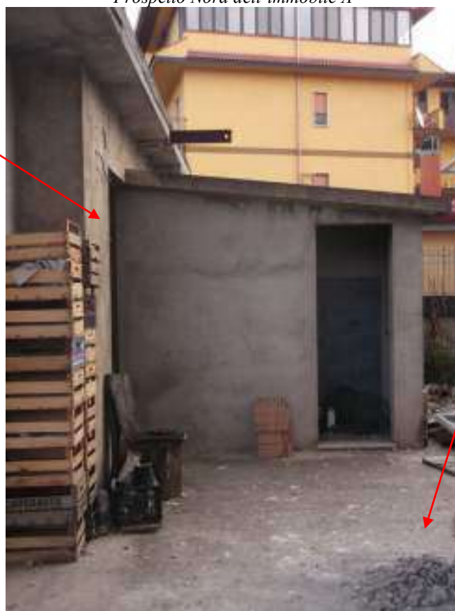
Ingresso wc esterno
