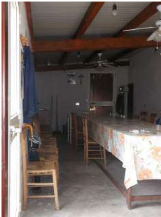
Parte del fabbricato con pavimento in cemento liscio
