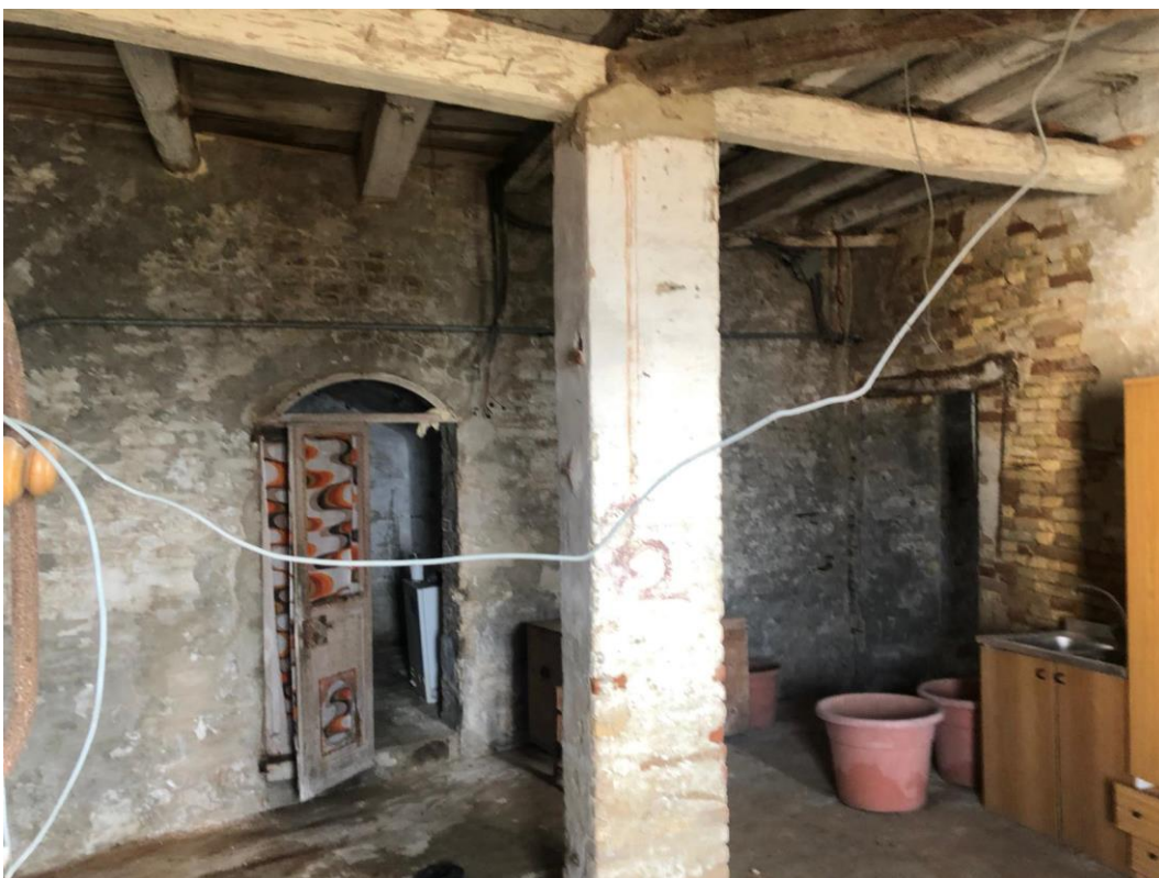
Foto 16: Locale cantina piano seminterrato
