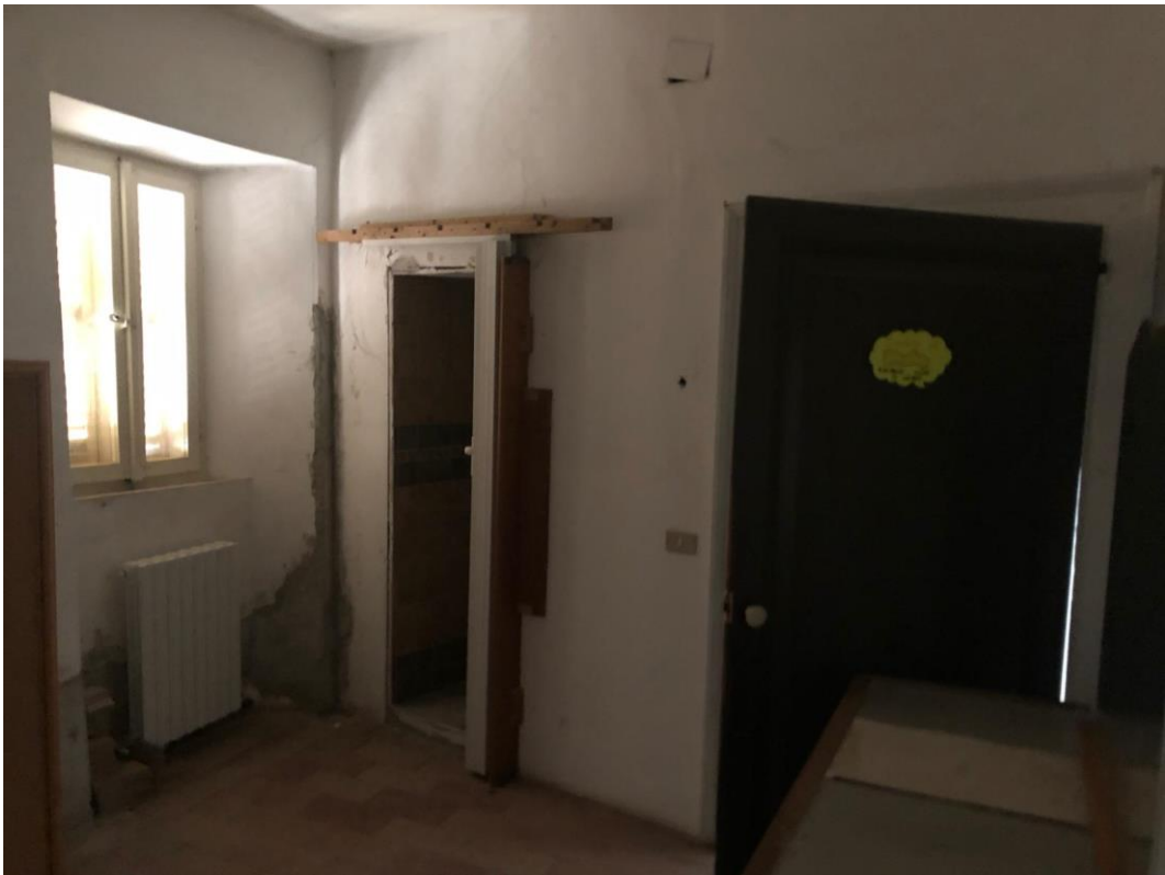
Foto 14: Locale disimpegno piano primo
