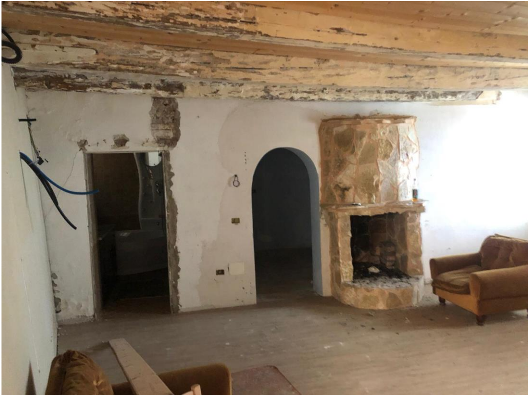
Foto 5: Locale soggiorno piano terra
