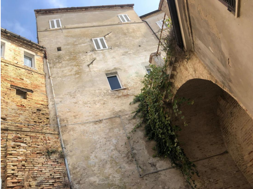
Foto 3: Vista esterna immobile lato sud
