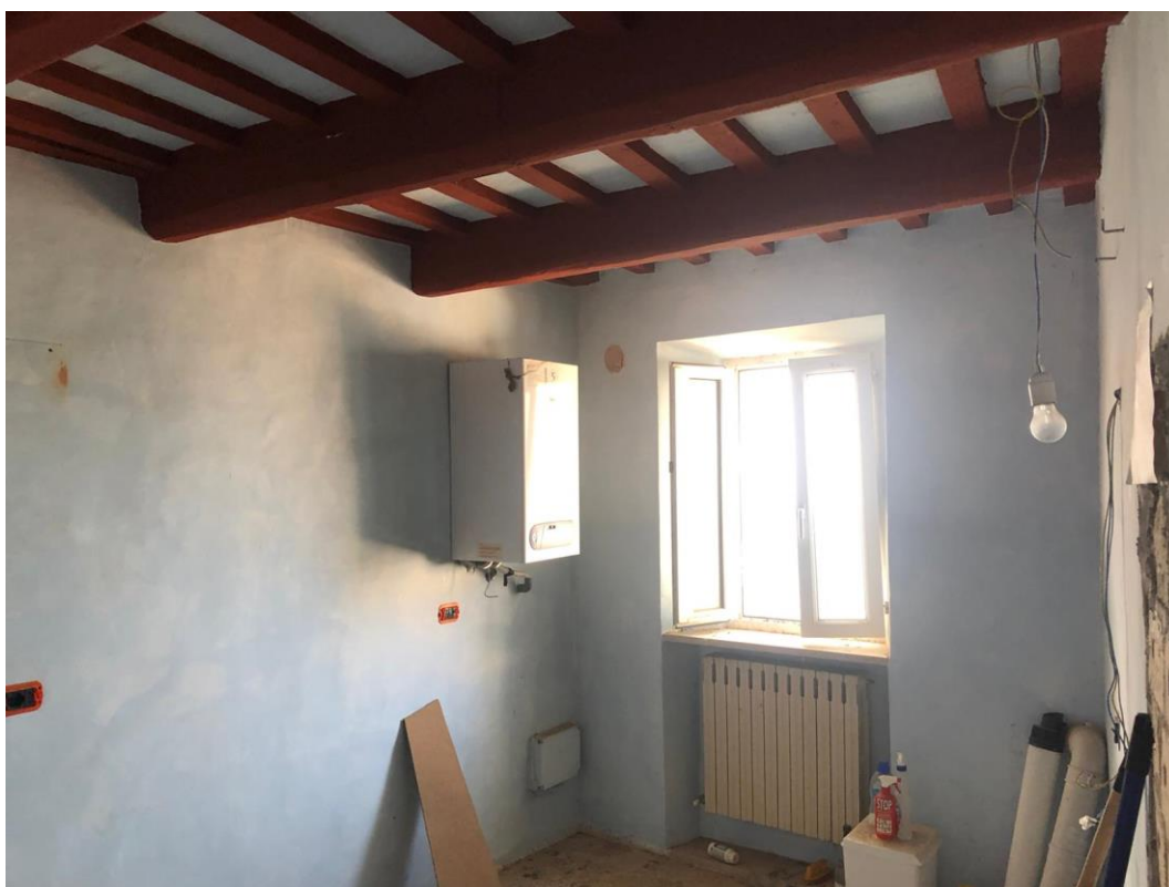
Foto 10: Locale cucina piano terra
