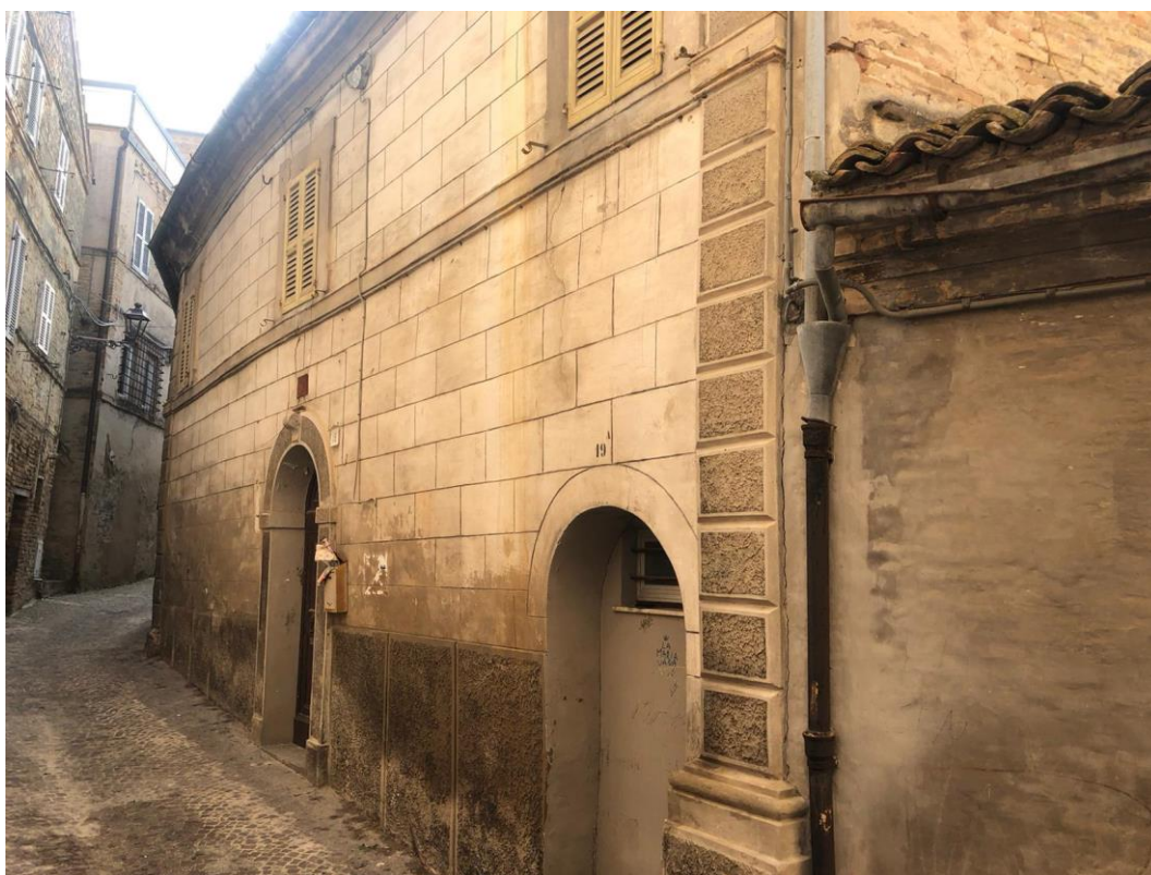
Foto 2: Vista esterna immobile lato nord
