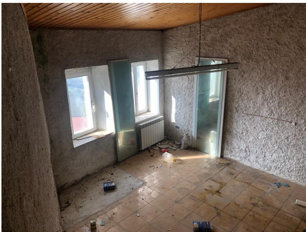
Foto 8: Locale cucina piano terra
