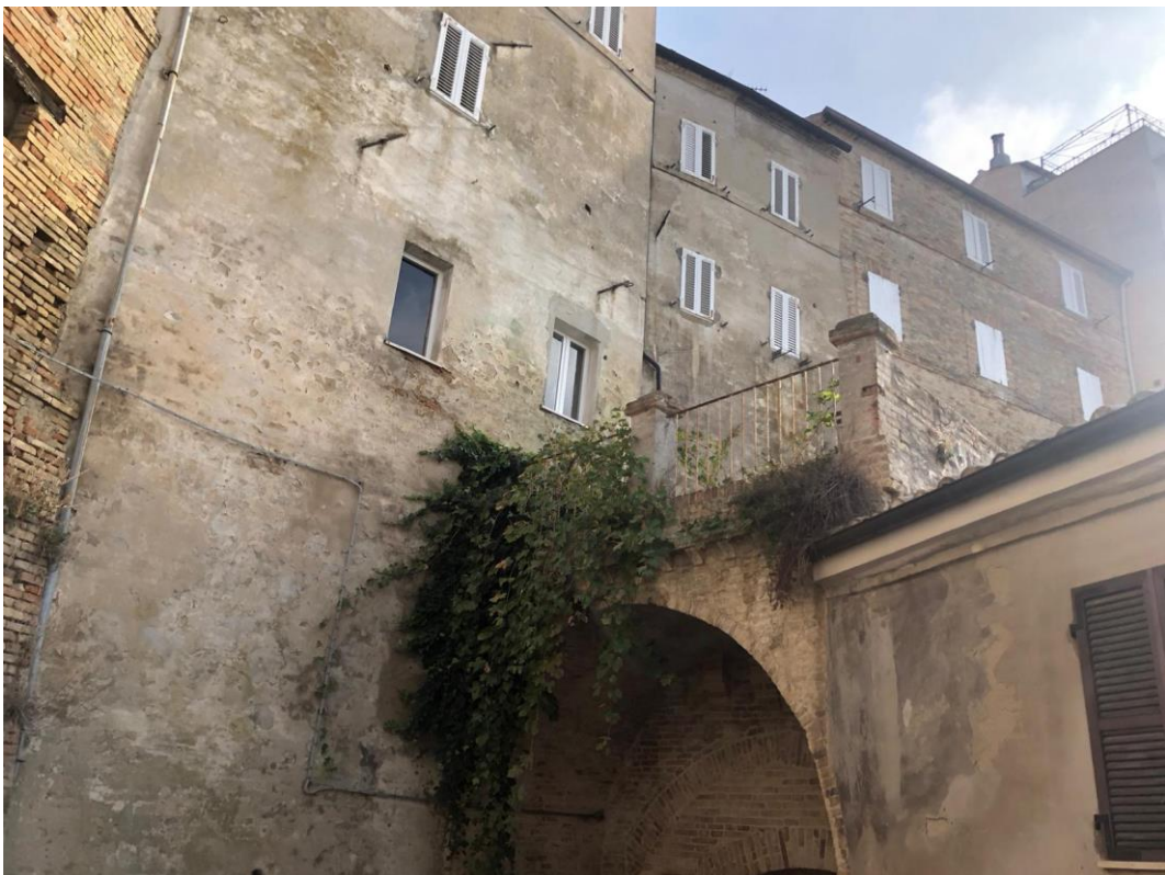
Foto 4: Vista esterna immobile lato sud
