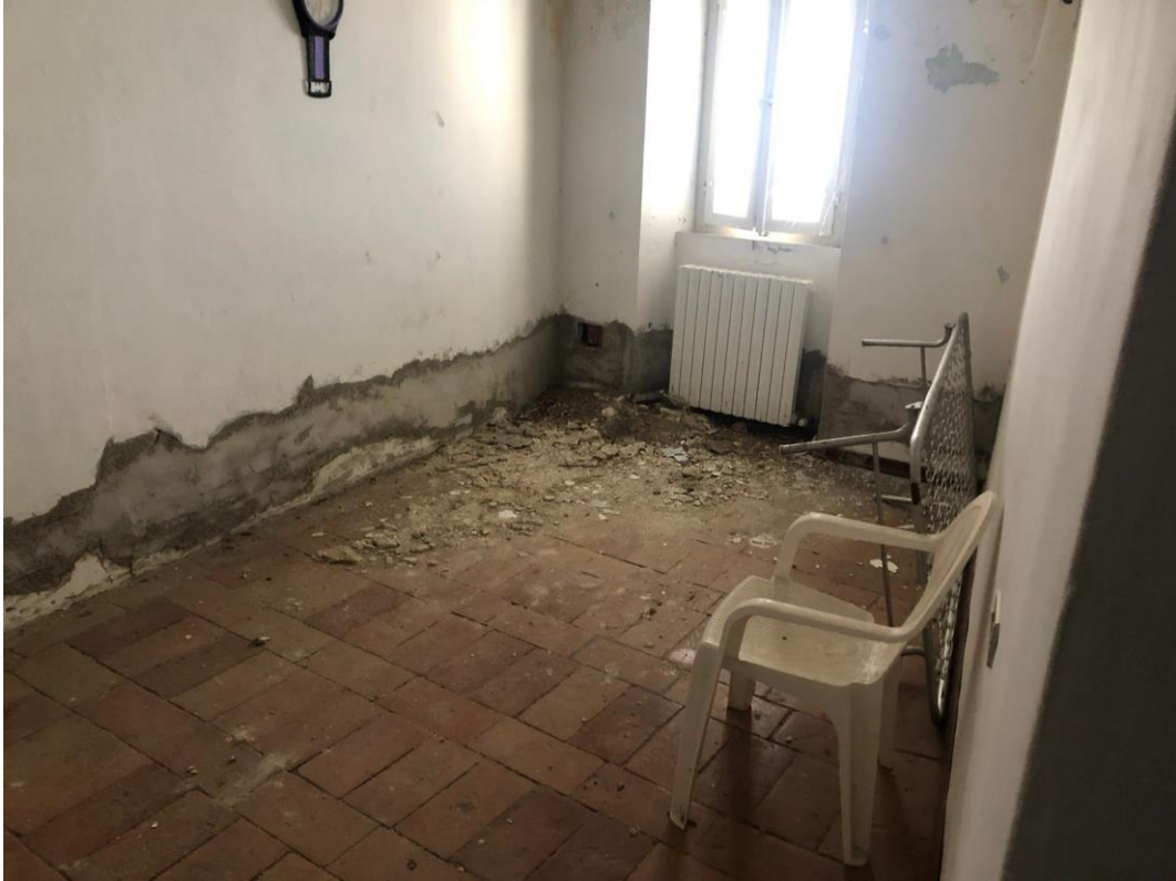
Foto 13: Locale camera piano primo
