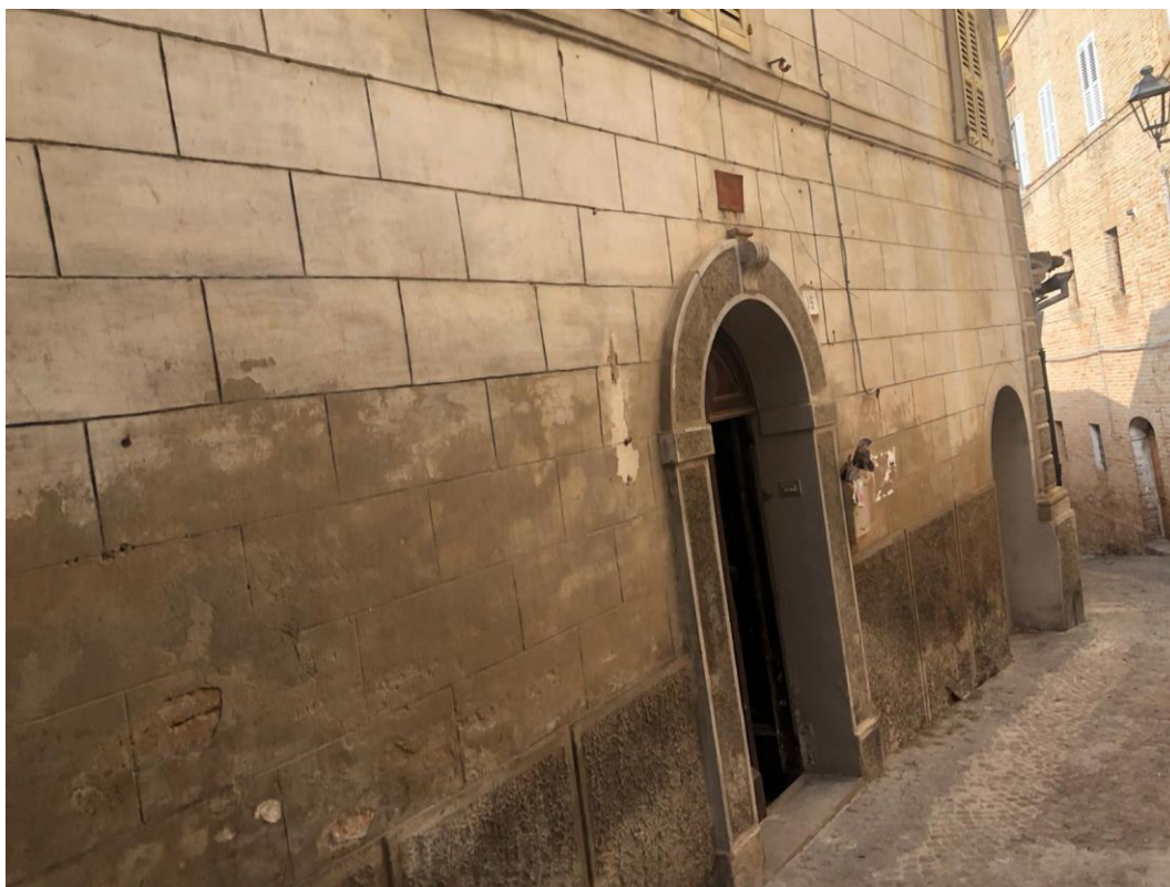
Foto 1: Vista esterna immobile lato nord
