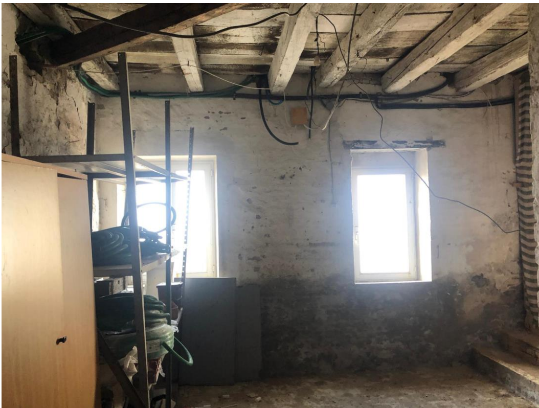
Foto 15: Locale cantina piano seminterrato
