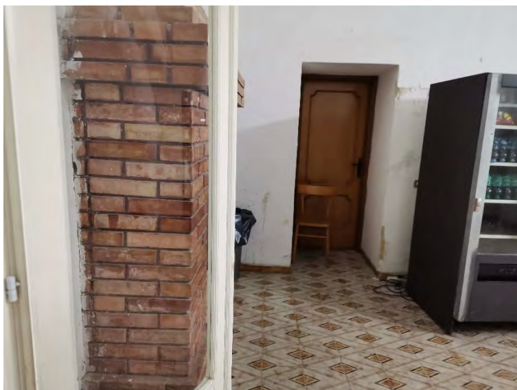
Interno del fabbricato p.lla 148
