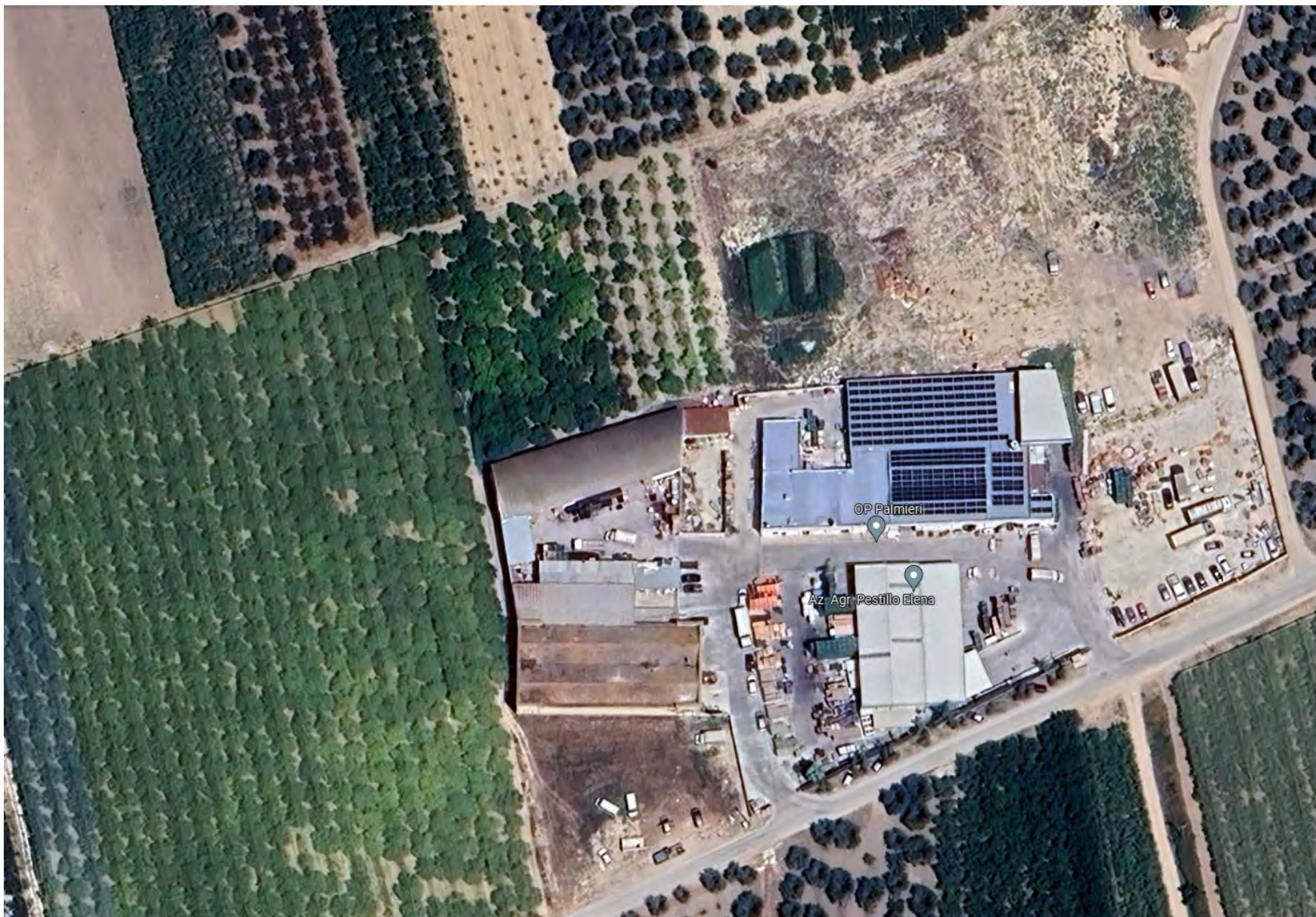
Dettaglio dei fabbricati e delle aree cortilizie e dei terreni incolti
