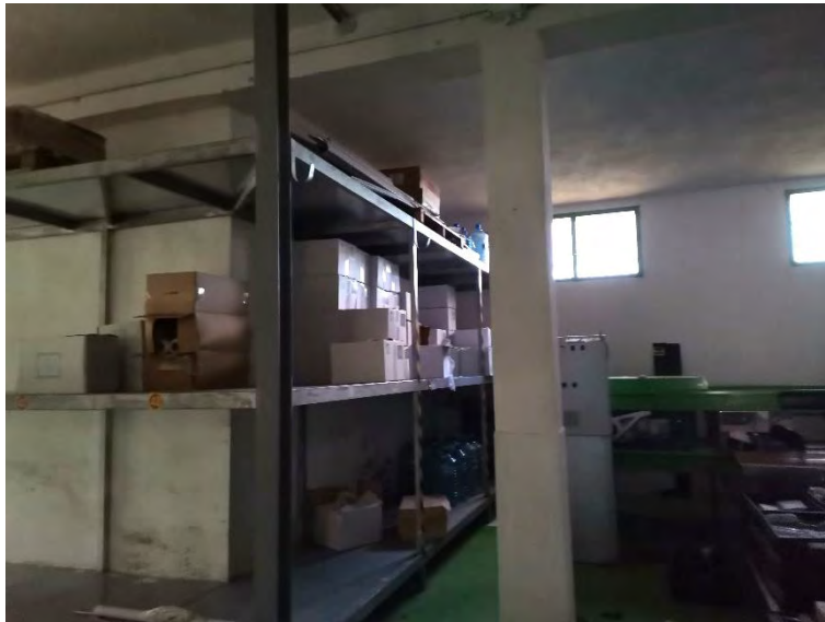
Interno del fabbricato p.lla 149
