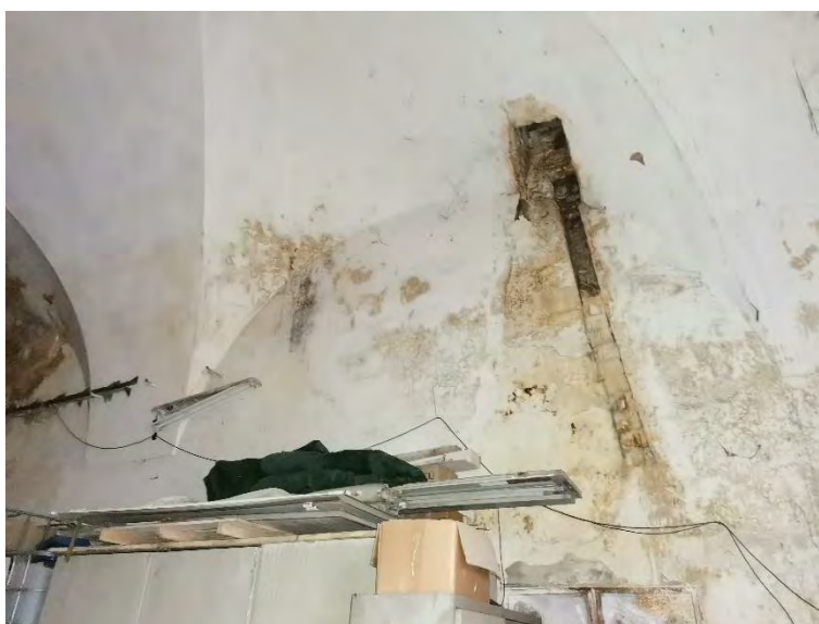
interno del fabbricato p.lla 10
