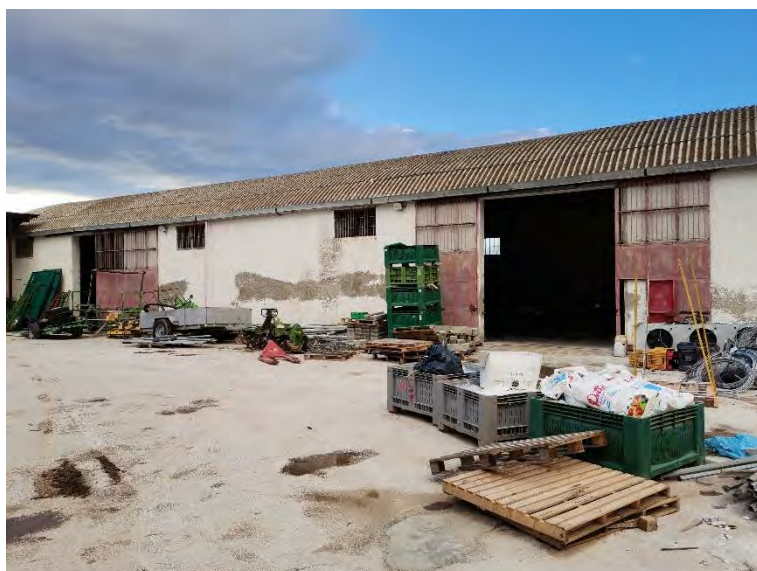
Il fabbricato principale in p.lla 296
