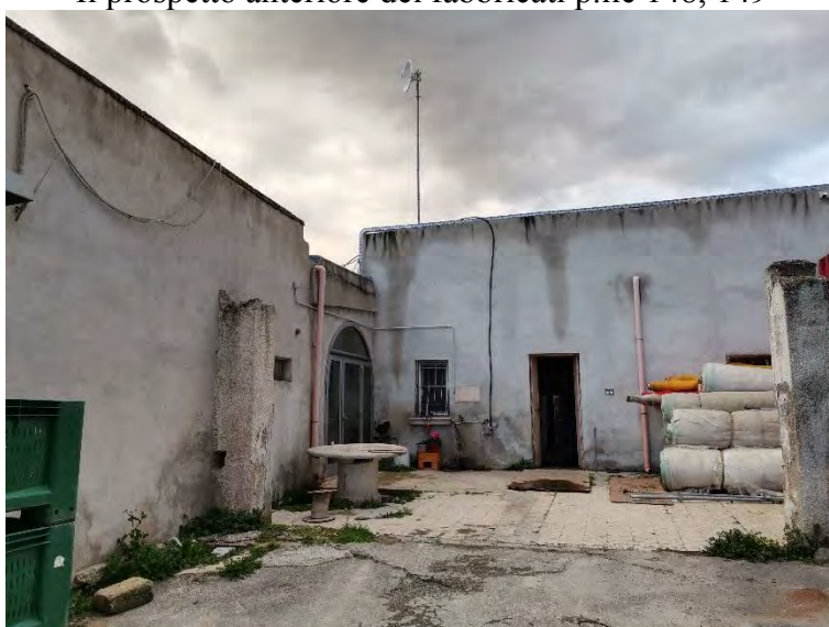
Il prospetto posteriore dei fabbricati p.lle 148, 149 e 272
