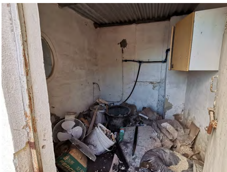
L'interno del fabbricato secondario in p.la 296
