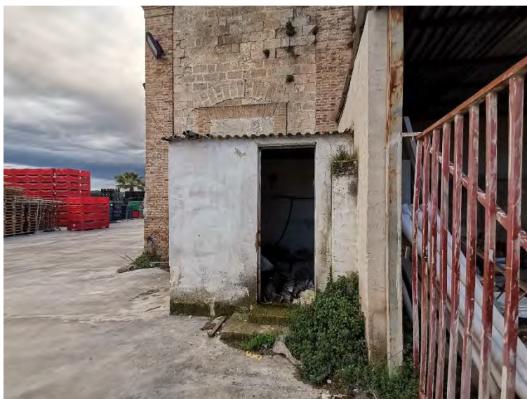
Il fabbricato secondario in p.la 296
