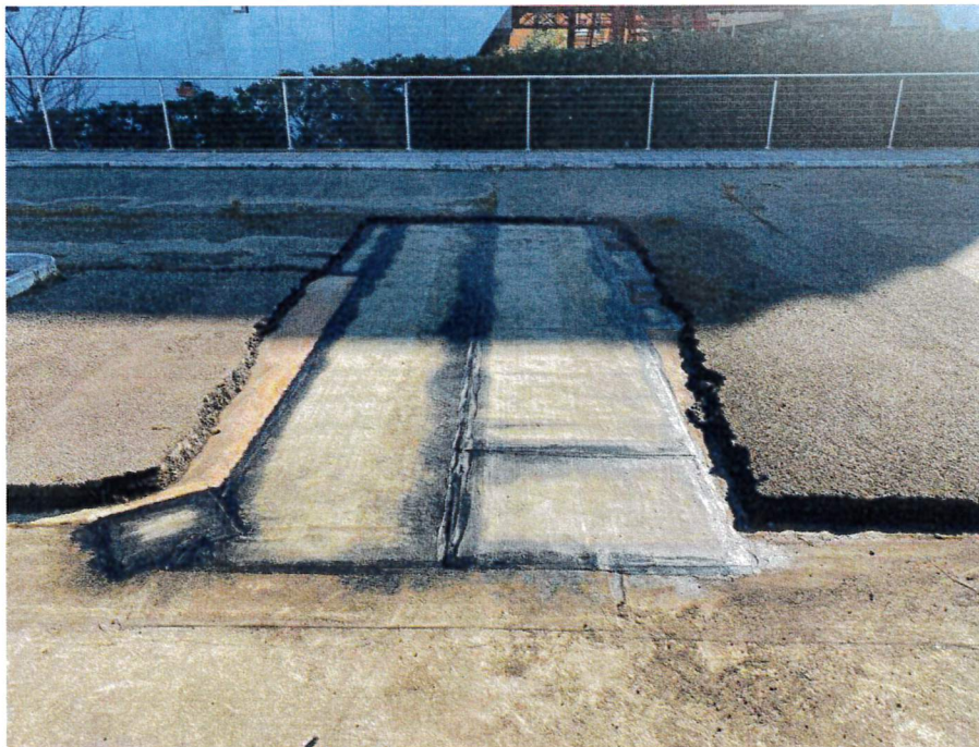
Dettaglio impermeabilizzazione sopra al lotto n.1
