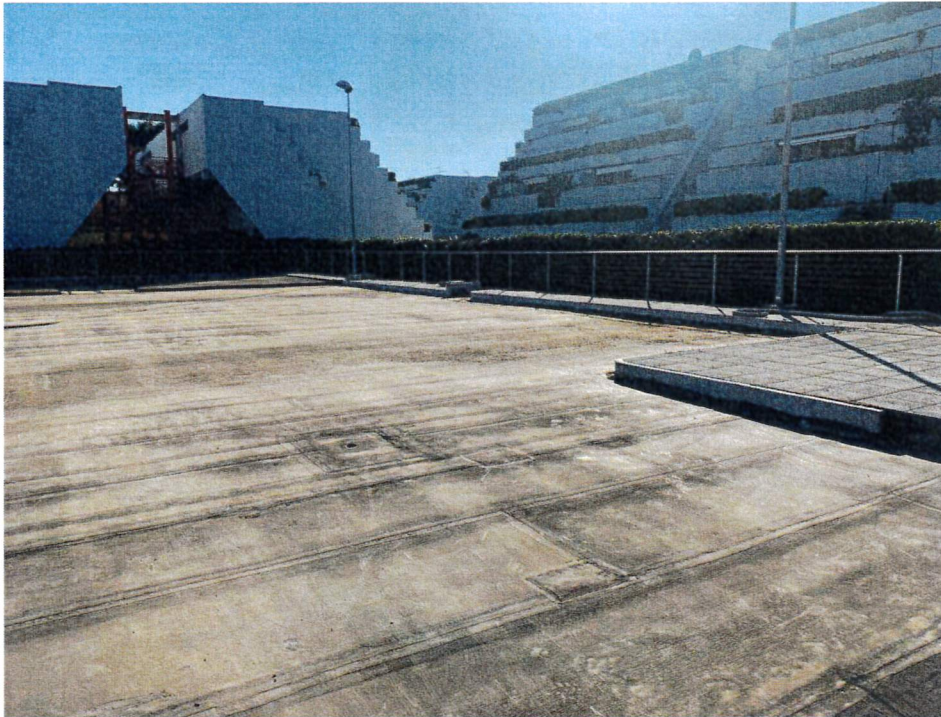
Panoramica lavori di pulizia effettuati
