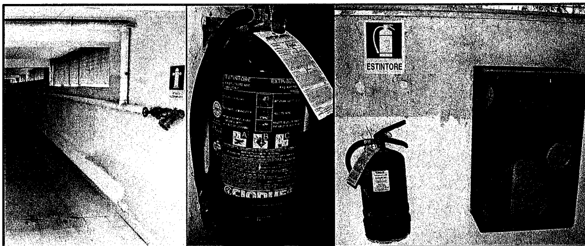
Impianto antincendio: tubazioni, estintore, naspo
